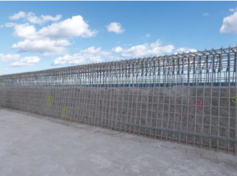
Armadura GFRP en fase de ejecución de la obra de rehabilitación del espaldón
