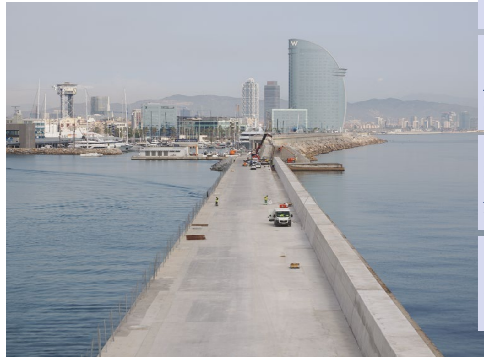
Dique de la bocana norte del Puerto de Barcelona
