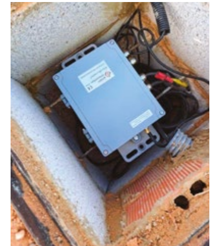
Nodo de inalámbrico de comunicaciones para la lectura de sensores de cuerda vibrante
