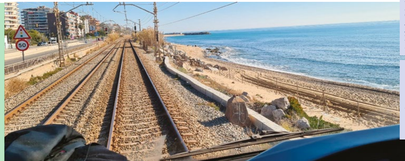
Tramo de la vía del Maresme
