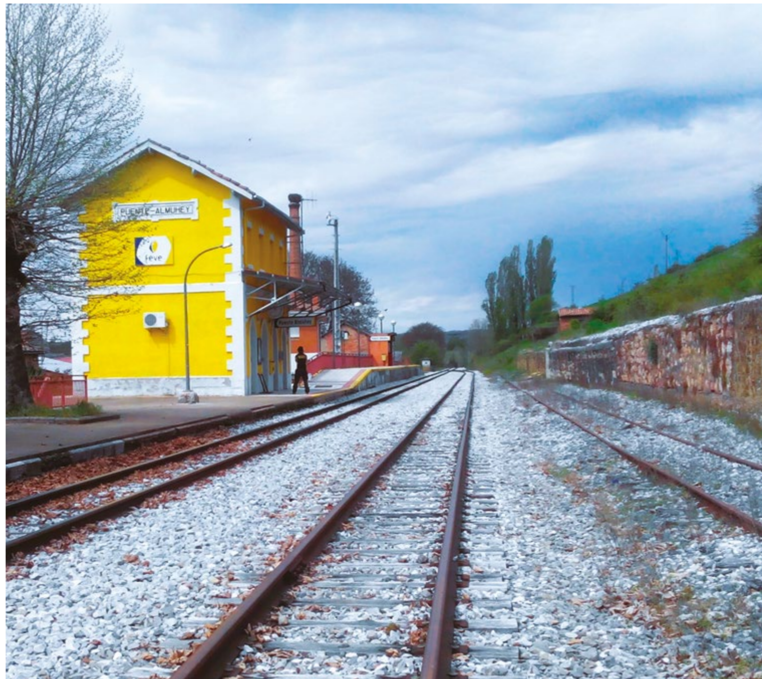
Línea Regional León-Guardo donde se desplegará un piloto de ERTMS Regional
