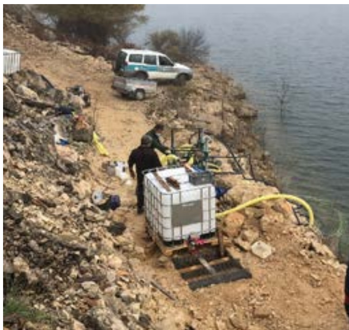
Ejecución del ensayo, alberca de 1x1m
