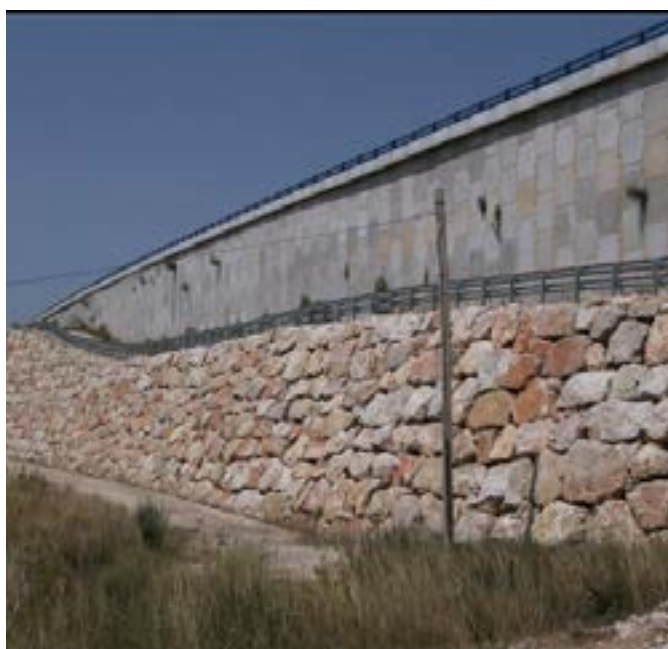
Vista del muro de tierra armada y de escollera junto a la calzada derecha de la BU-30
