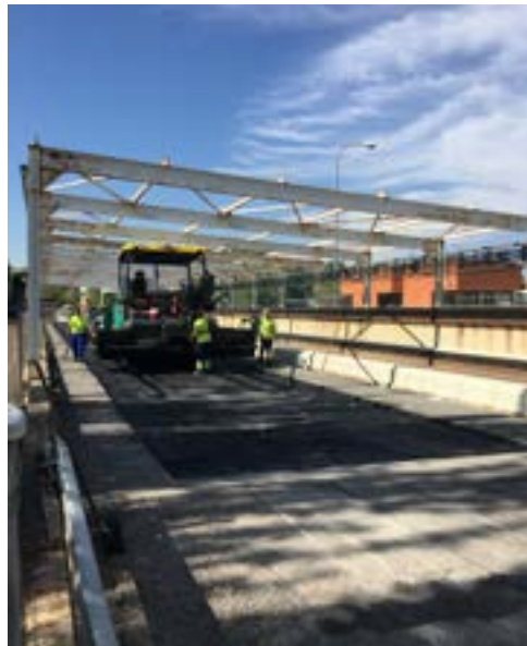
Extendido mezclas bituminosas
