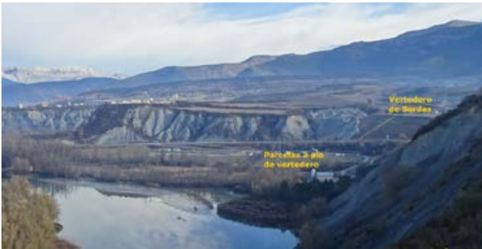
Localización del vertedero de Sardas y el embalse de Sabiñánigo en el río Gállego
