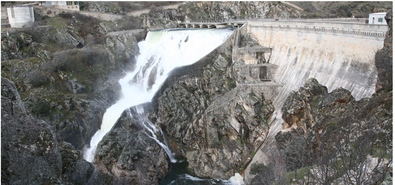
Aliviadero de la presa de El Villar
