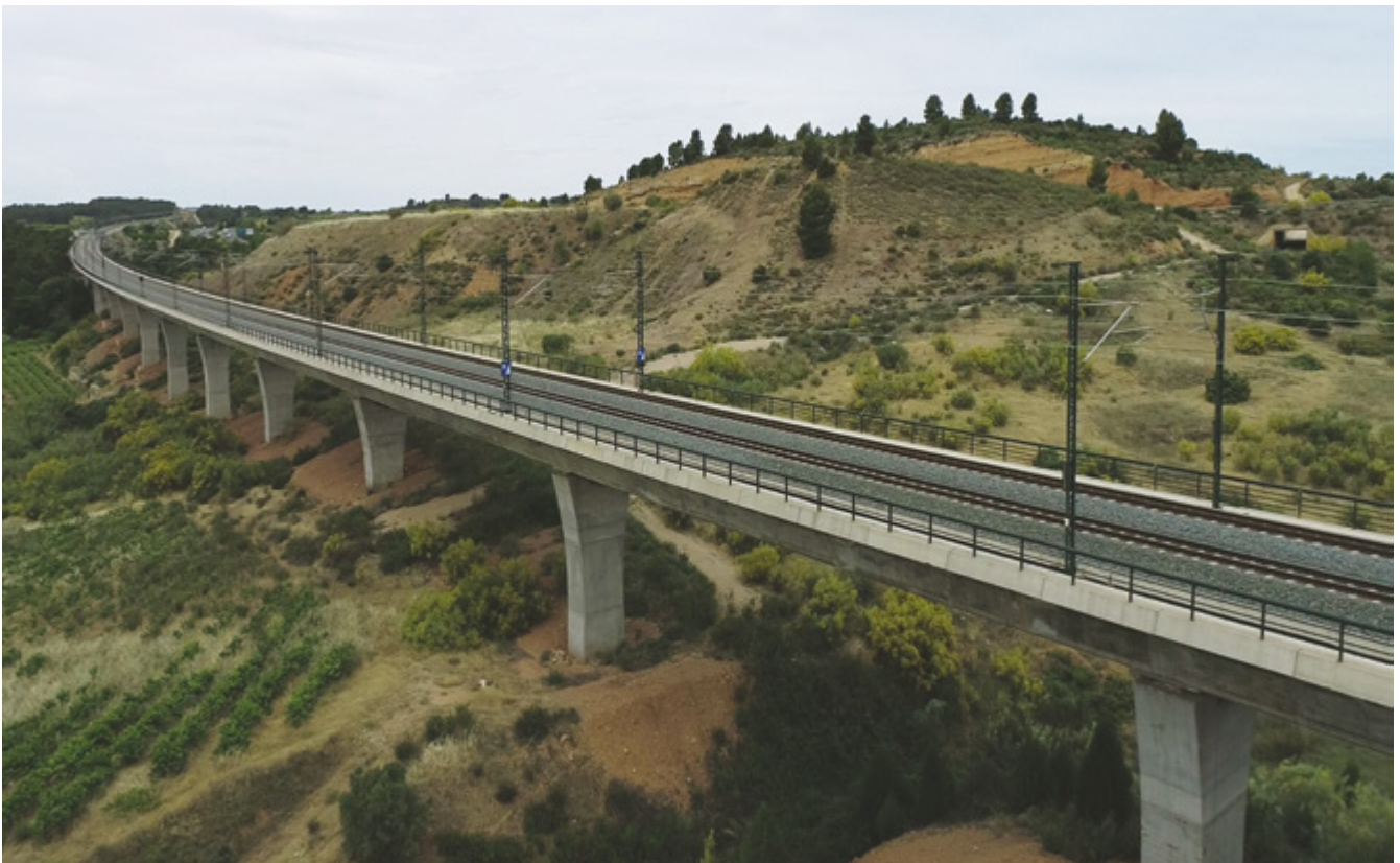
Viaducto de Minglanilla
