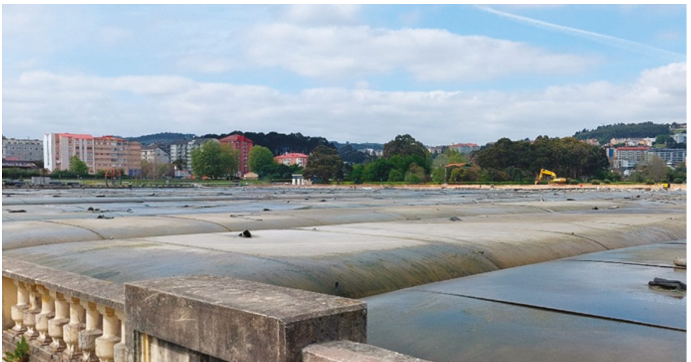
Confinamiento de los sedimentos más contaminados en recinto mediante uso combinado de floculantes y geotubos.
