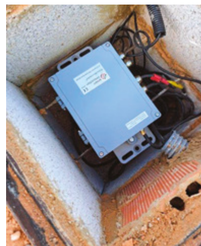
Nodo de inalámbrico de comunicaciones para la lectura de sensores de cuerda vibrante
