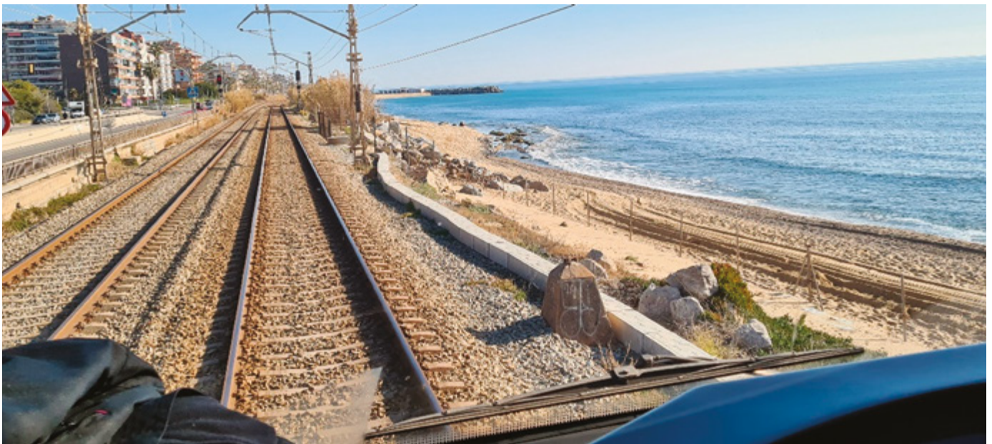
Tramo de la vía del Maresme
