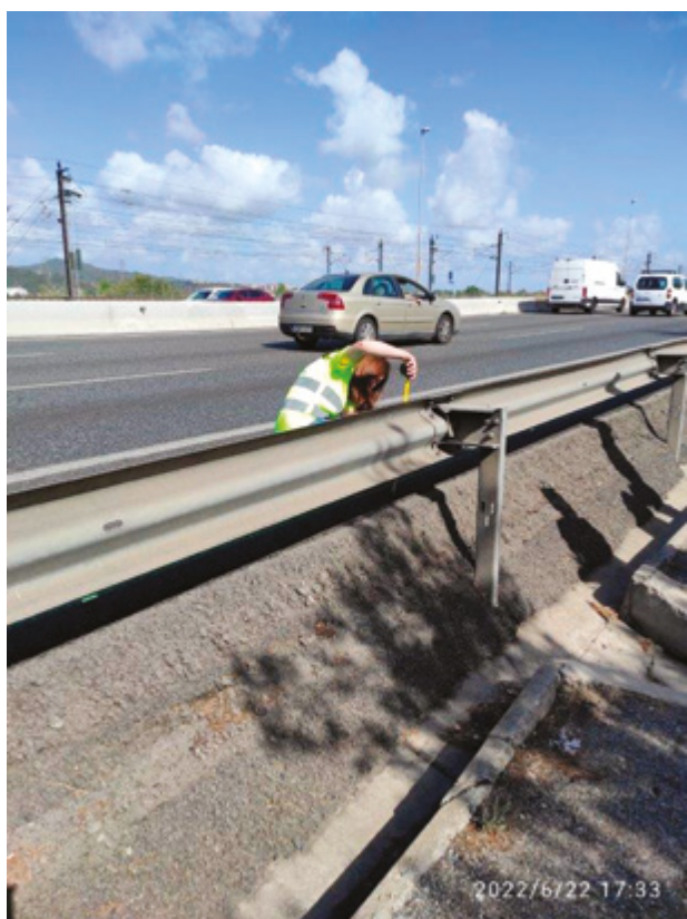
Medición de asentamientos anómalos en la A-2 en Sant Vicenç dels Horts
