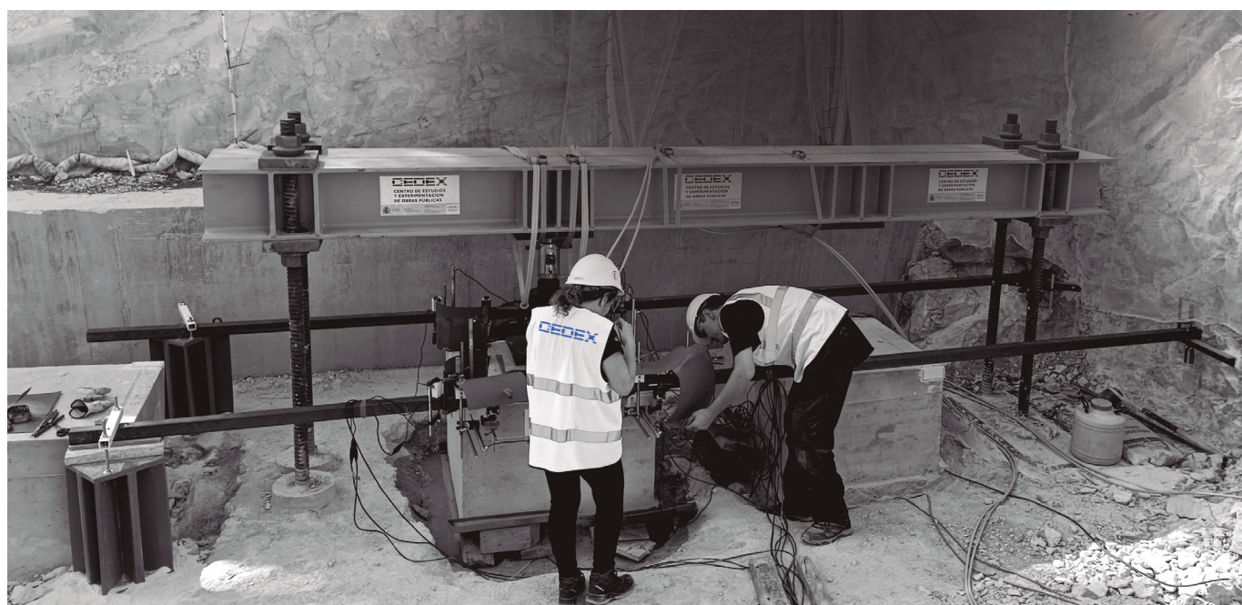
Trabajos en la presa del Amadorio
