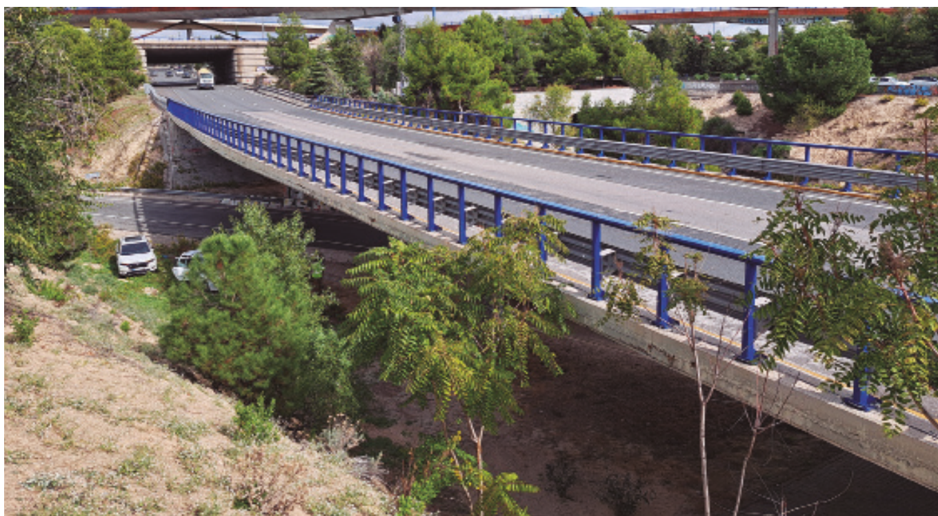
Puente en estudio
