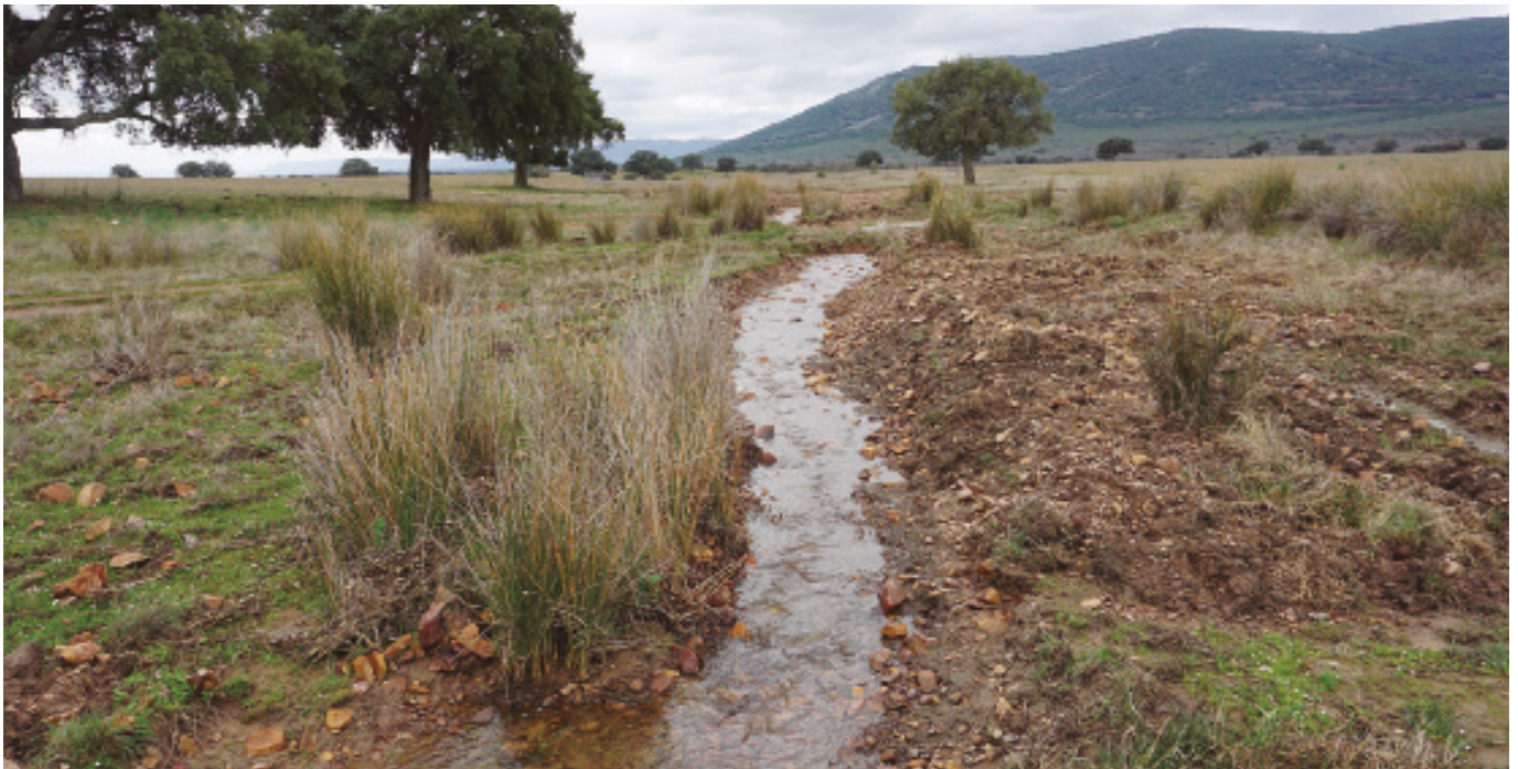
Aspecto del cauce 1 tras las actuaciones
