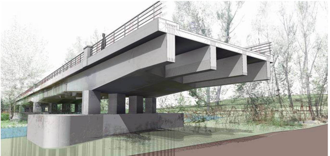
Sección transversal del puente de Villaviciosa de Odón sobre el río Guadarrama construido en 1954 por Carlos Fernández Casado. Vista del MODELO BIM LEVANTADO A PARTIR DE LA NUBE DE PUNTOS 3D. FUENTE: ELABORACIÓN PROPIA
