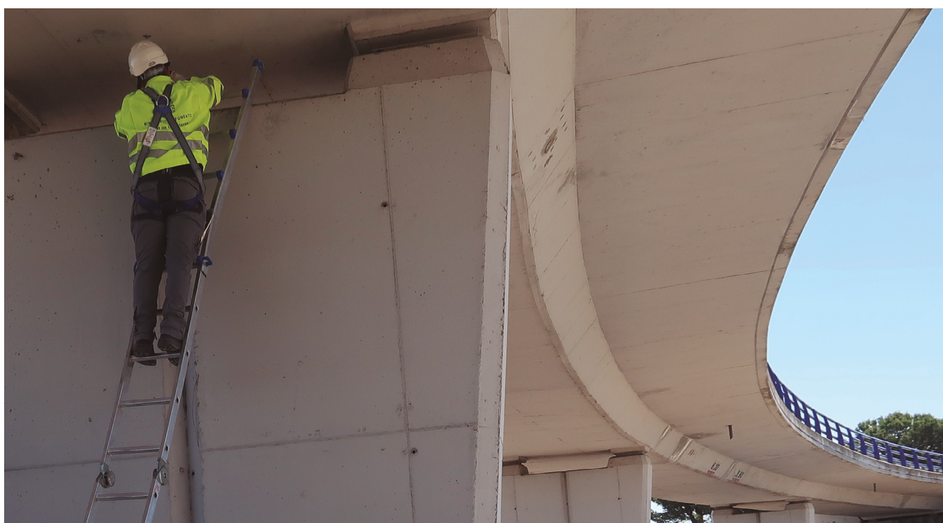
Instalación de un sensor para el control de temperatura y humedad en el interior del hormigón del tablero
