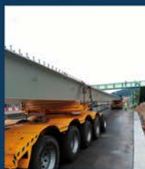
Chegada a Rande da viga caixón
