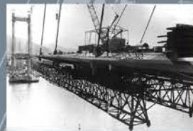
Ponte de Rande, 1977
