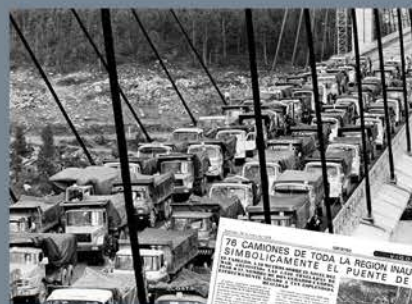
Probas de peso na ponte Foto: Magar, 1978
