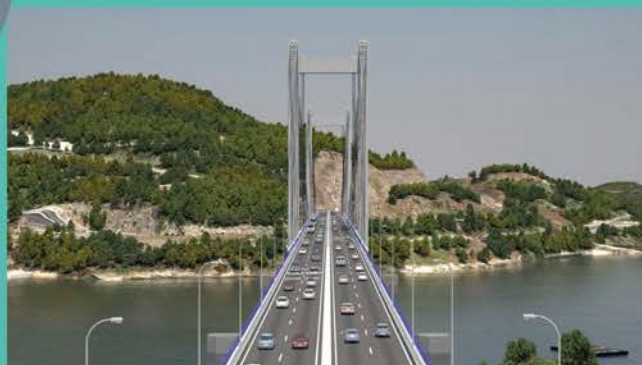
A ponte antes da ampliación
