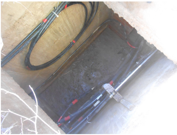
Arqueta de la línea telefónica subterránea
