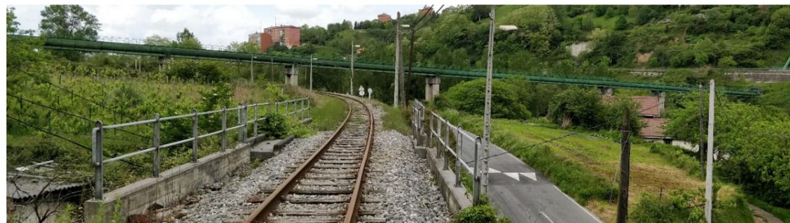
Los dos tramos de línea ferroviaria y la parte más elevada de la tubería son fácilmente accesibles y con amplia zona de cielo despejado sin interferencia de vegetación o sombras. En estos casos, se recogen los datos mediante posicionamiento GPS según la configuración descrita en apartado anterior. Los datos del carril son tomados en la parte superior del hilo bajo y la tubería en la clave del tubo.
