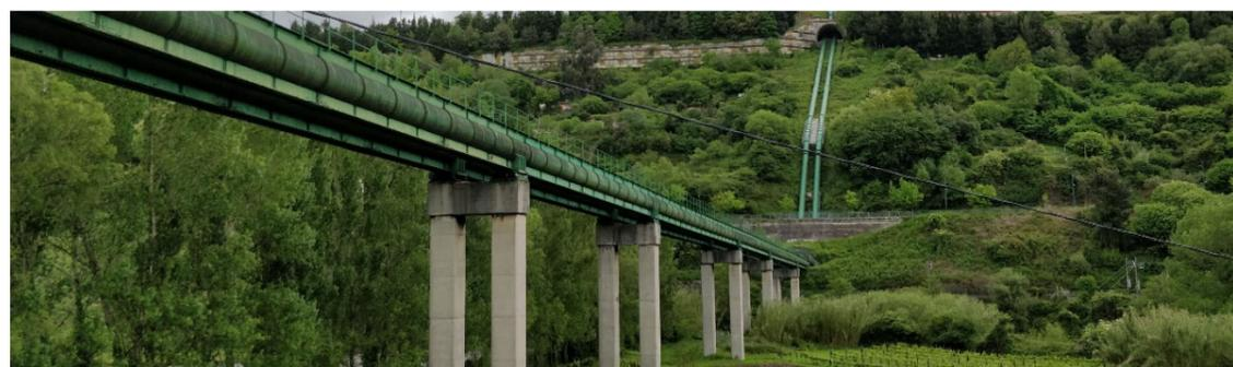
Para la recogida de datos de la tubería en la zona que transcurre elevada se establecen 2 bases (P<sub>3</sub> – P<sub>4</sub>) y se observan con GPS. Sobre estas bases se orienta la estación total y haciendo uso del distanciómetro del equipo se toman referencias al lateral de la tubería, que está definido por una marca de soldadura.
