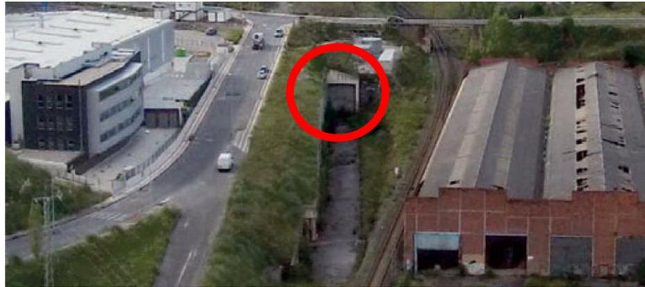
Como se aprecia en la imagen superior, el trazado del túnel en su punto final es paralelo al de las vías allí existentes (línea de cercanías C-2 Bilbao-Muskiz de ADIF), habiéndose ejecutado un tramo de la plataforma que un futuro permitiría dar continuidad a la Variante Sur Ferroviaria entre la boca del túnel y el paso a nivel anterior a la Estación de Ortuella.
