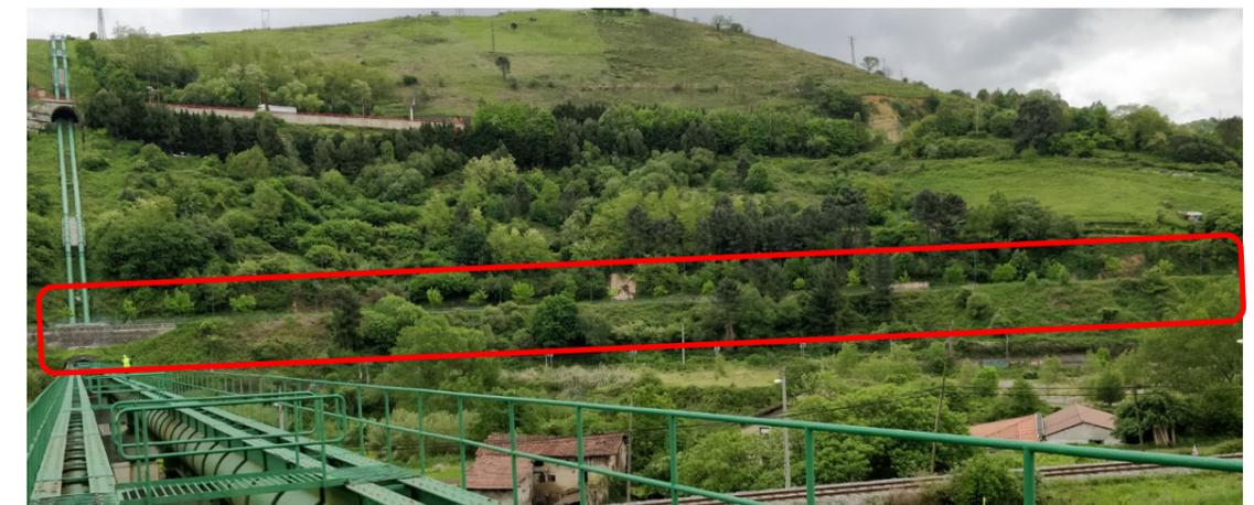
El resultado de todo ello es un perfil longitudinal complicado para el tronco de la VSF en el cruce del Valle del Kadagua que sale a superficie procedente del Castaños en rampa de inclinación 15 milésimas que da paso a un acuerdo vertical convexo de parámetro 11.000 (Kv mínima admisible en tráfico mixto) que permite transicionar a una pendiente de 11 milésimas.
