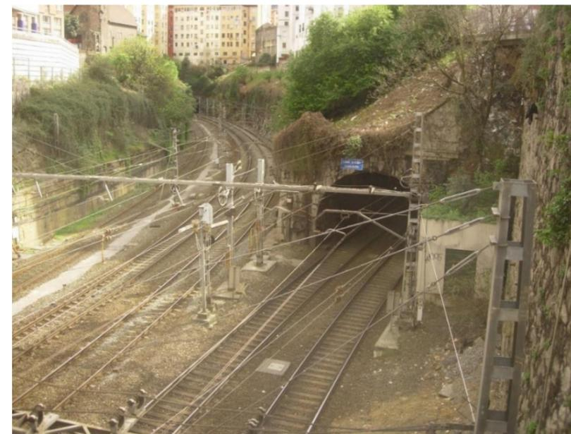
El túnel de Zabalburu del B.P.T. da servicio a las líneas de Cercanías C1 y C2. Éste se encuentra situado entre las estaciones de Zabalburu y Amézola. La cota de vía en la boca de salida del túnel, condiciona el longitudinal de acceso de la estación en el nivel de cercanías, ya que no se contempla realizar actuaciones que suponga rebajes en este túnel, tal y cómo se ha indicado ya anteriormente en el apartado 6.1.1.1 de la presente memoria.
