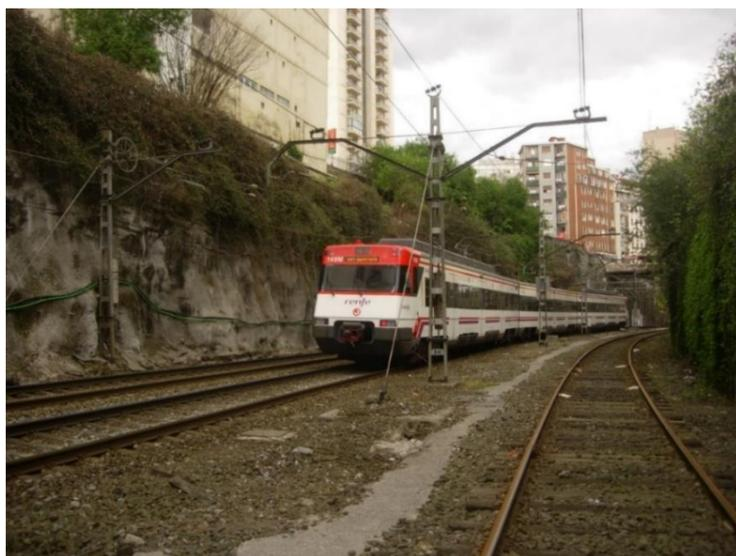
La trinchera ferroviaria existente cuenta con una sección variable de entre 20 y 35 metros partiendo en dos los barrios de Zabálburu y San Francisco. Condiciona tanto las situaciones ferroviarias provisionales para garantizar la continuidad del tráfico ferroviario, como el diseño del cajón ferroviario.
