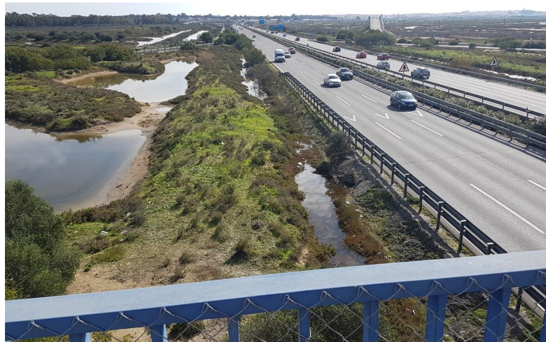
Imagen 8. Márgenes A-48. Motas de protección existentes.
