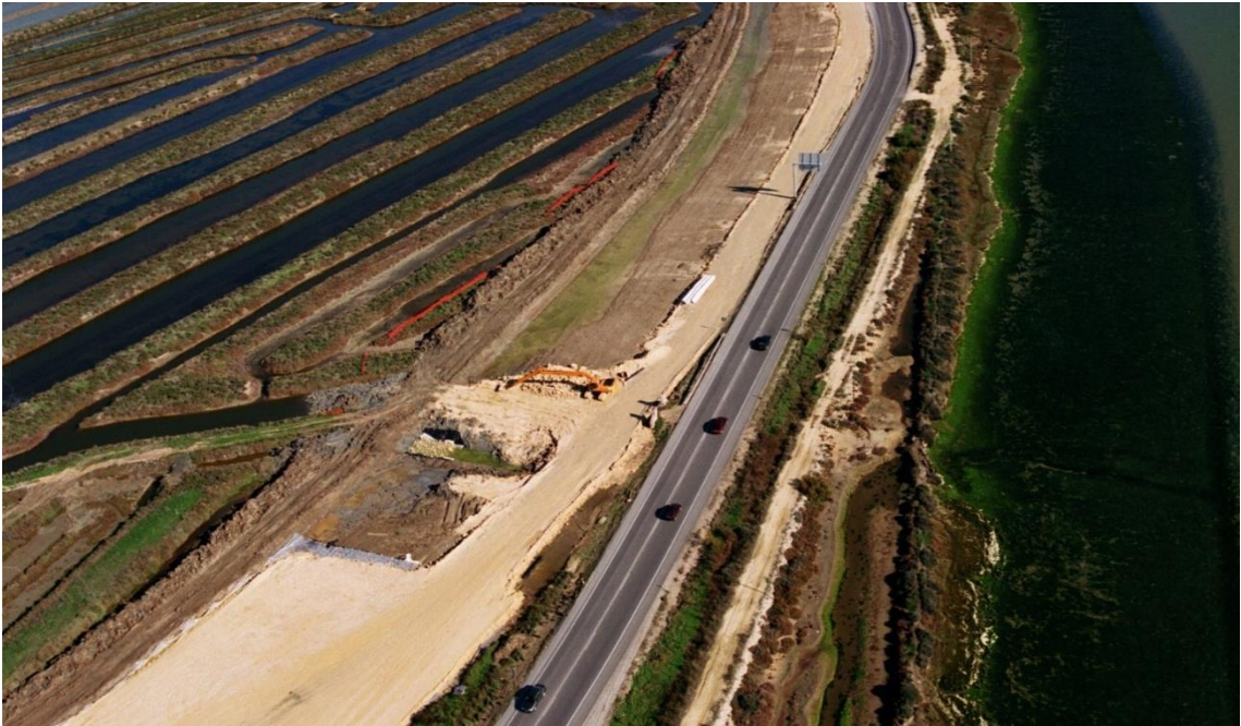
Imagen 18. Obras de Duplicación de la CN-IV. Material procedente de la Cantera San Kristóbal. Material = Suelo seleccionado.
