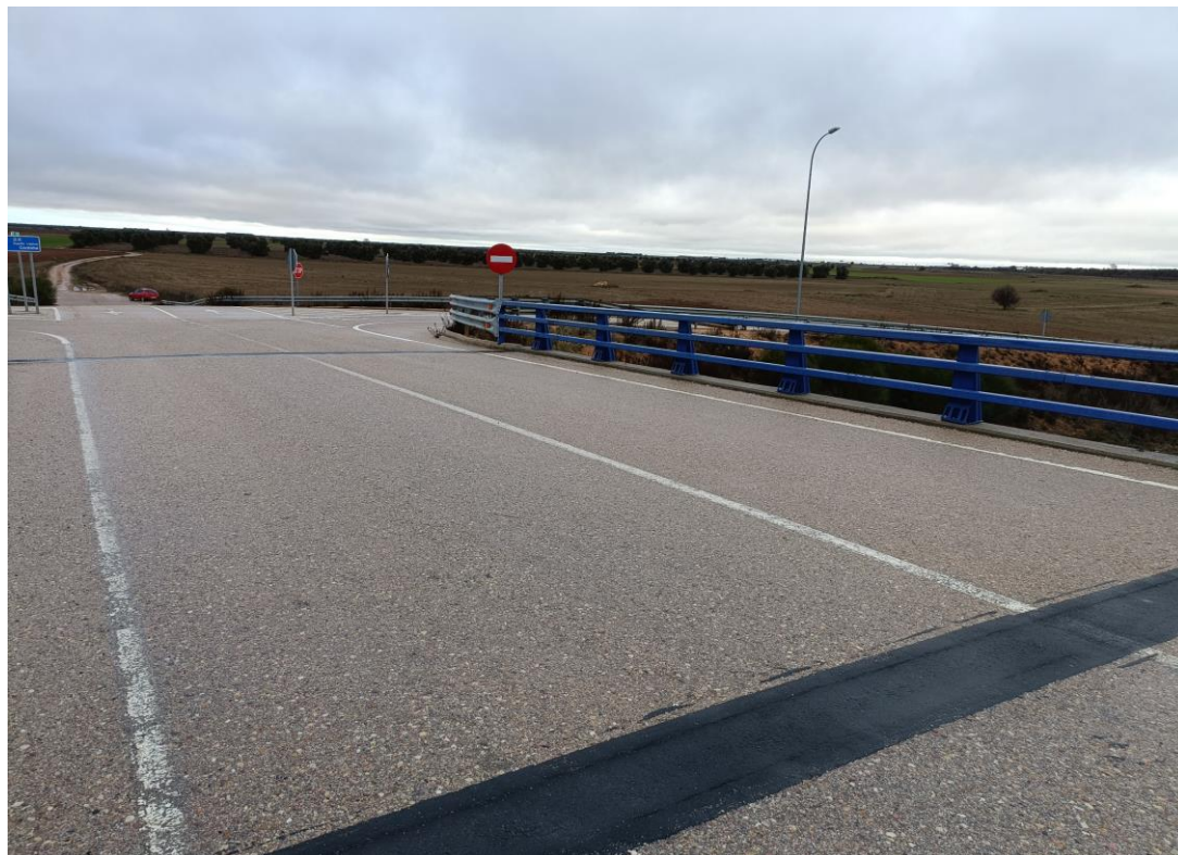
Foto Nº 1 . Vista de la plataforma del Paso Superior 0A-0004-0067+500 D. Estado de la junta de dilatación sobre el estribo E1.
