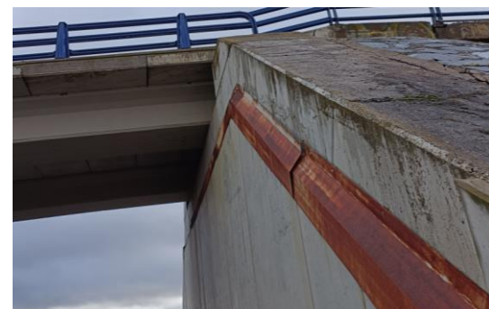
Figura 38 Manchas puntuales de óxido debido a las chapas metálicas del estribo 1 (central)
