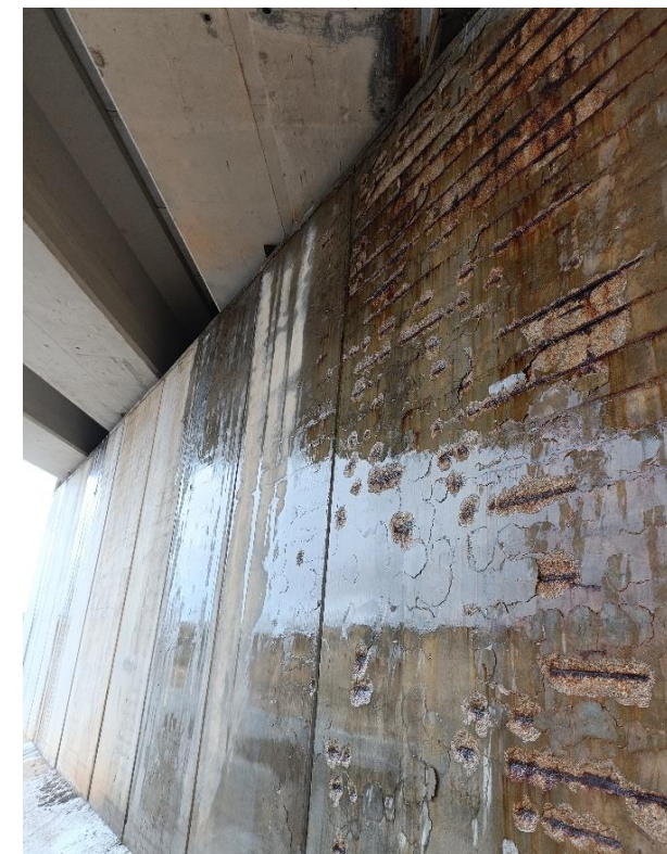
Foto Nº 24 . Falta de recubrimiento y armaduras vistas en el alzado de los muros del Estribo 1.
