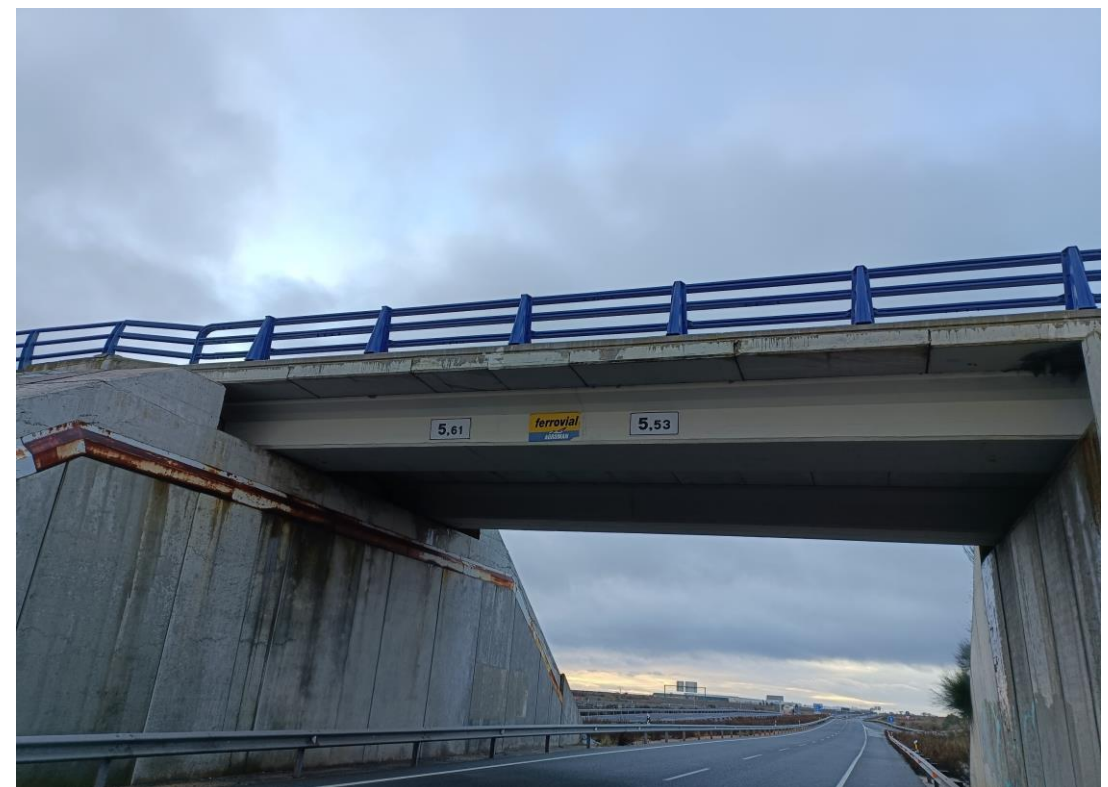
Foto Nº 20 . Estribo E1. Fisuras y eflorescencias en alzado de muros.
