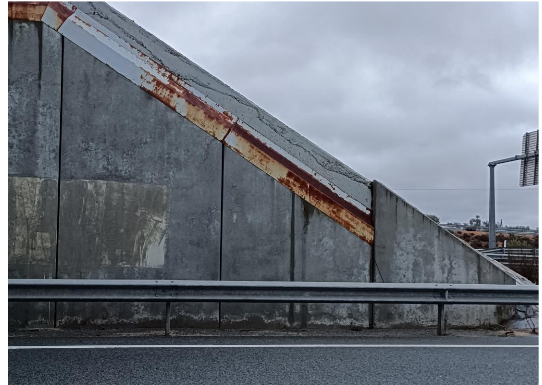
Foto Nº 19 . Deformación en alzado de muro extremo. Fisura superior siguiendo la pendiente de los muros.
