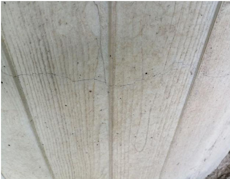
Figura 23. Fisuras en mapa en pilas, extraído de la inspección principal de 2020
