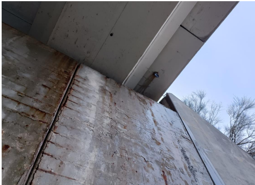
Foto Nº 30 . Estribo E1. Detalle de oxidación de barras y falta de recubrimiento en alzado de muros. Manchas de humedad y eflorescencias en alzado de muros. Agua discurriendo por alzado de estribo. Detalle de humedad en proximidad de tubo de drenaje.
