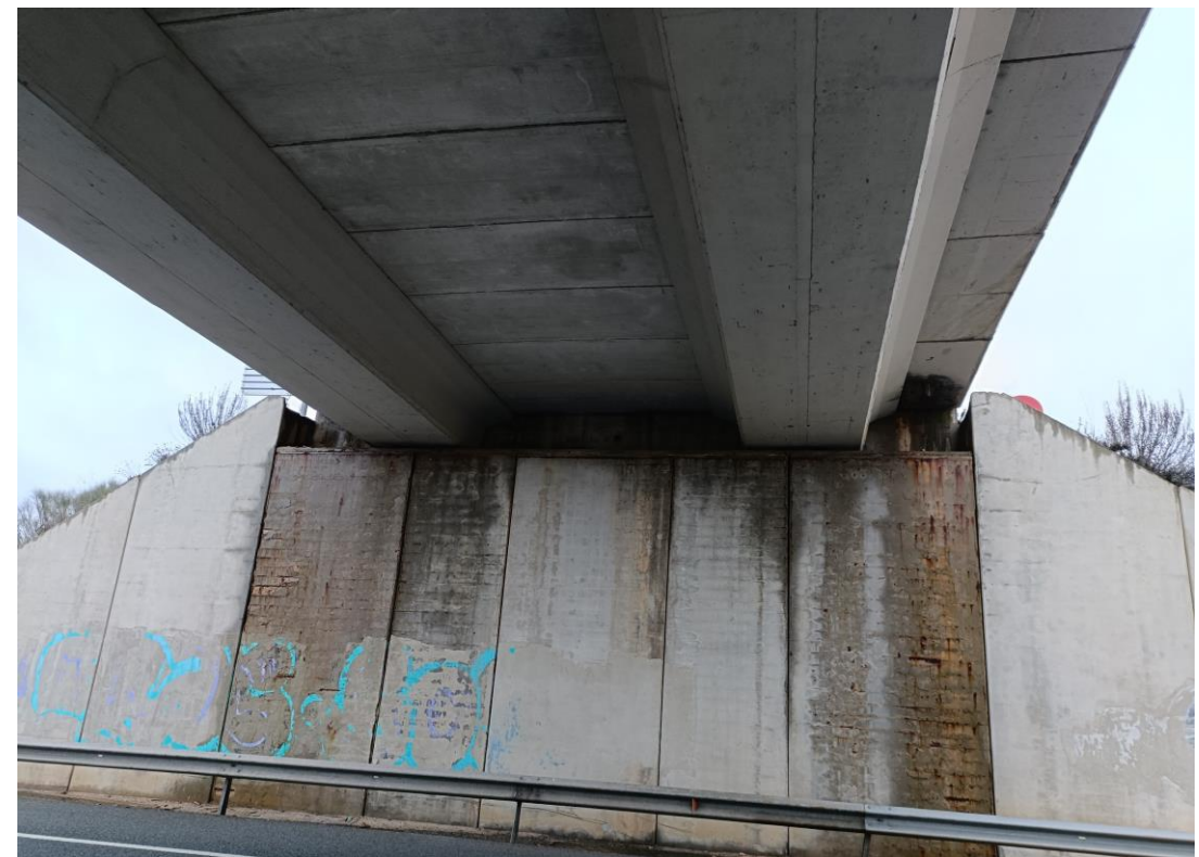
Foto Nº 36 . Estribo E2. Fisuras y eflorescencias en alzado de muros. Grafitis en alzado de muros.
