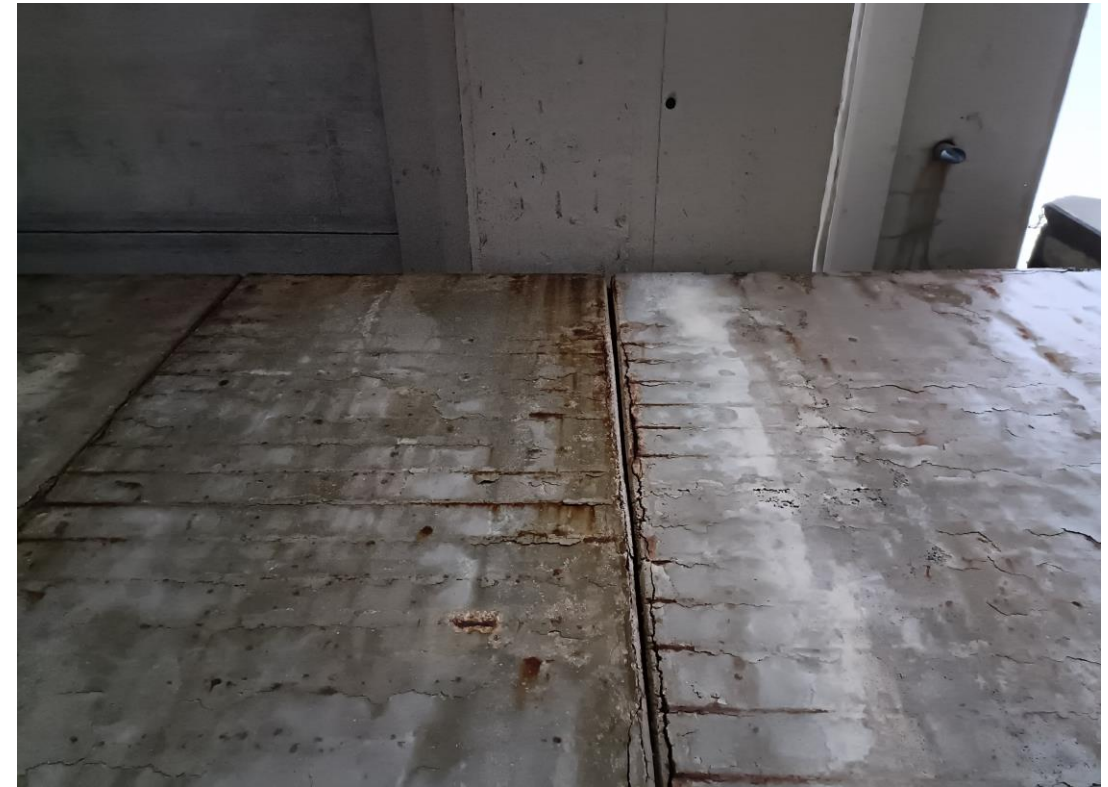
Foto Nº 31 . Estribo E1. Detalle de oxidación de barras y falta de recubrimiento en alzado de muros. Manchas de humedad y eflorescencias en alzado de muros. Agua discurriendo por alzado de estribo. Detalle de humedad en proximidad de tubo de drenaje.
