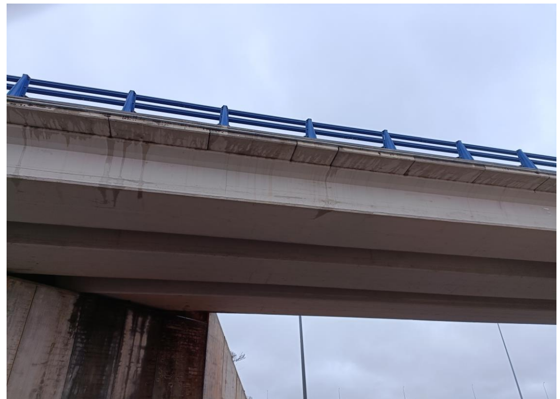
Foto Nº 60 . Vista inferior del Paso Inferior. Viga artesa extrema en buen estado de conservación.
