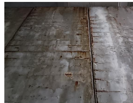
Figura 36 Falta de recubrimiento y oxidación de armaduras en muros de estribo 2 (lateral)
