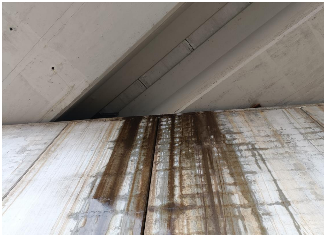
Foto Nº 34 . Falta de recubrimiento y armaduras vistas en el alzado de los muros del Estribo 1.
