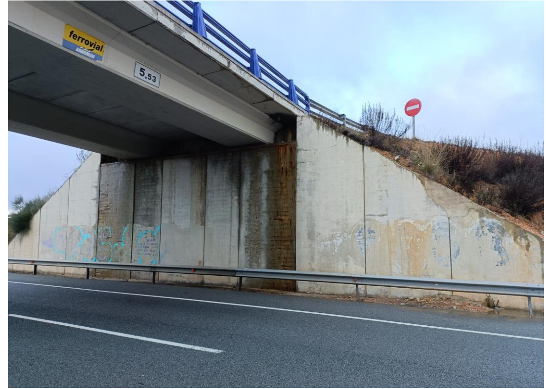
Foto Nº 39 . Estribo E2. Fisuras y eflorescencias en alzado de muros. Grafitis en alzado de muros.
