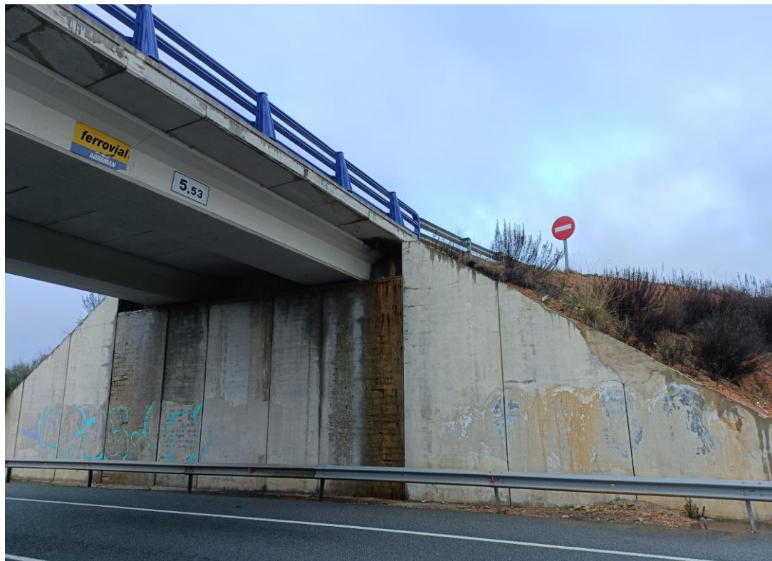
Foto Nº 38 . Estribo E2. Fisuras y eflorescencias en alzado de muros. Grafitis en alzado de muros.
