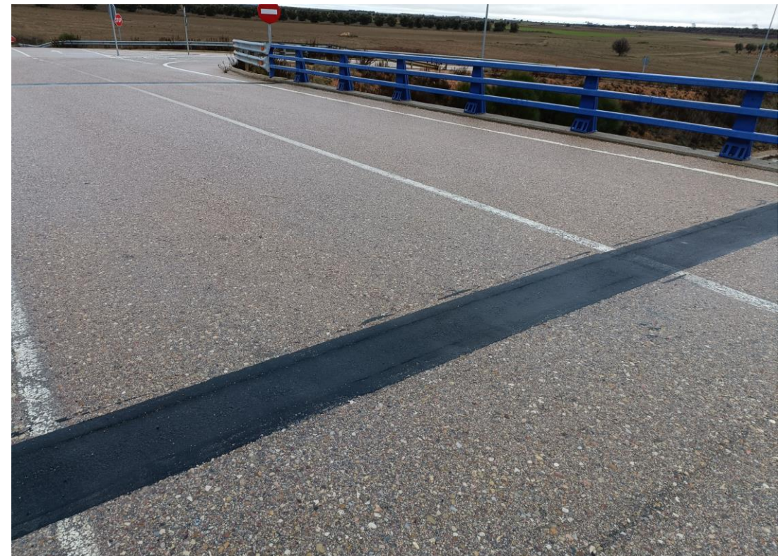
Foto Nº 3 . Vista de la plataforma del Paso Superior 0A-0004-0067+500 D. Estado de la junta de dilatación sobre el estribo E2.
