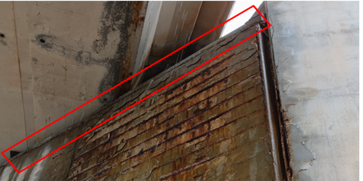
Figura 24 Fisura horizontal en el cargadero del Estribo 1, debajo de viga 1
