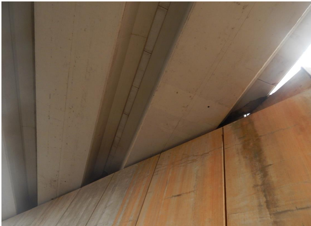
Foto Nº 46 . Humedades y eflorescencias en espaldón de Estribo 2. Manchas de humedad en el tablero.
