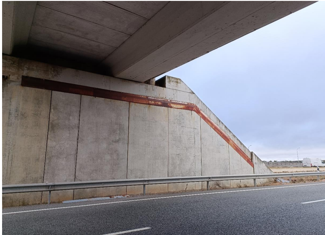
Foto Nº 13 . Estribo E2. Manchas de óxido por corrosión de chapa de unión en cabeza de alzado de muros. Deformación en alzado de muro extremo.
