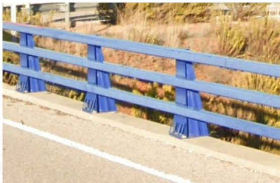
Figura 65 Puntos de descascarillamiento en pintura protectora de los largueros horizontales del sistema de contención derecho.
