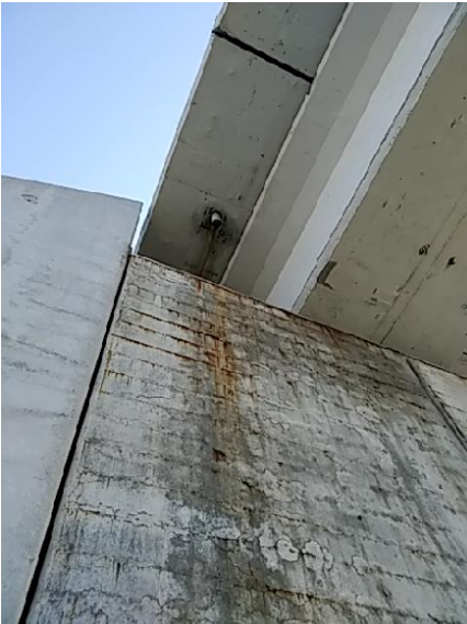
Pátinas alrededor de desagüe en prelosa
