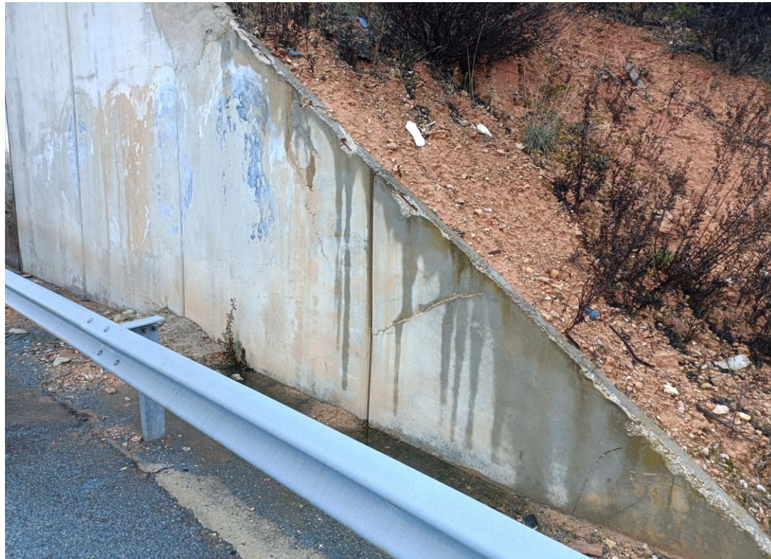
Foto Nº 41 . Estribo E2. Alzado de muros en prolongación conteniendo el terraplén. Manchas de humedad en los alzados.
