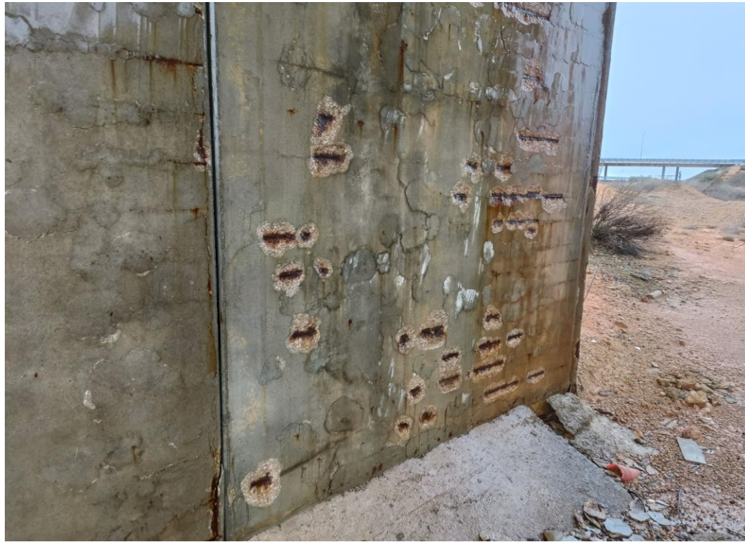
Foto Nº 29 . Falta de recubrimiento y armaduras vistas en el alzado de los muros del Estribo 1.
