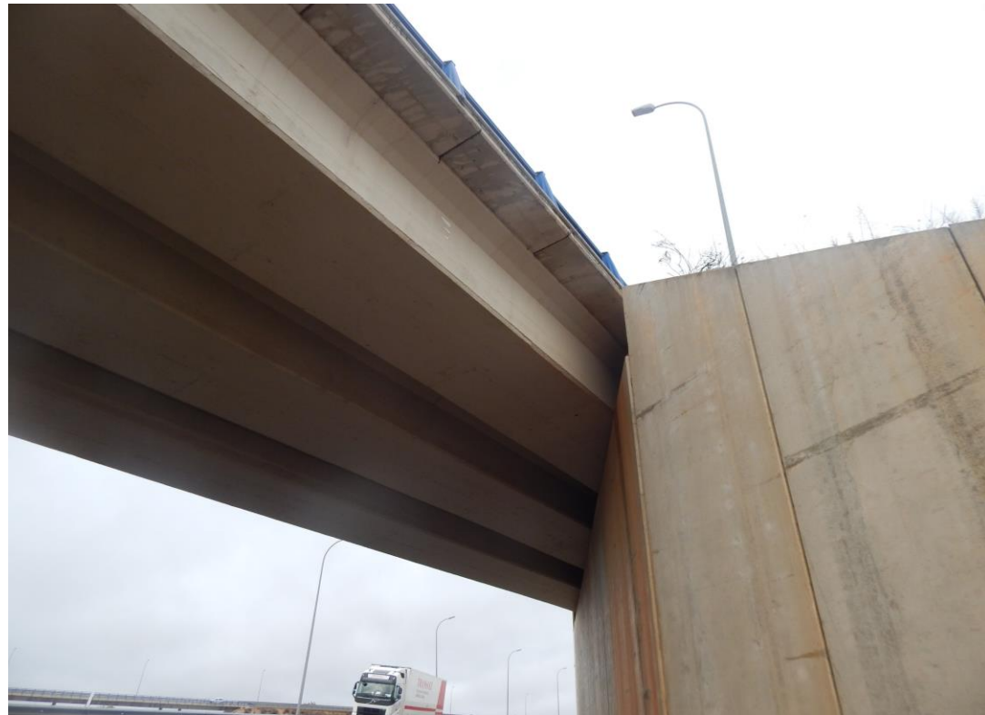
Foto Nº 49 . Muros de acompañamiento en Estribo 2.
