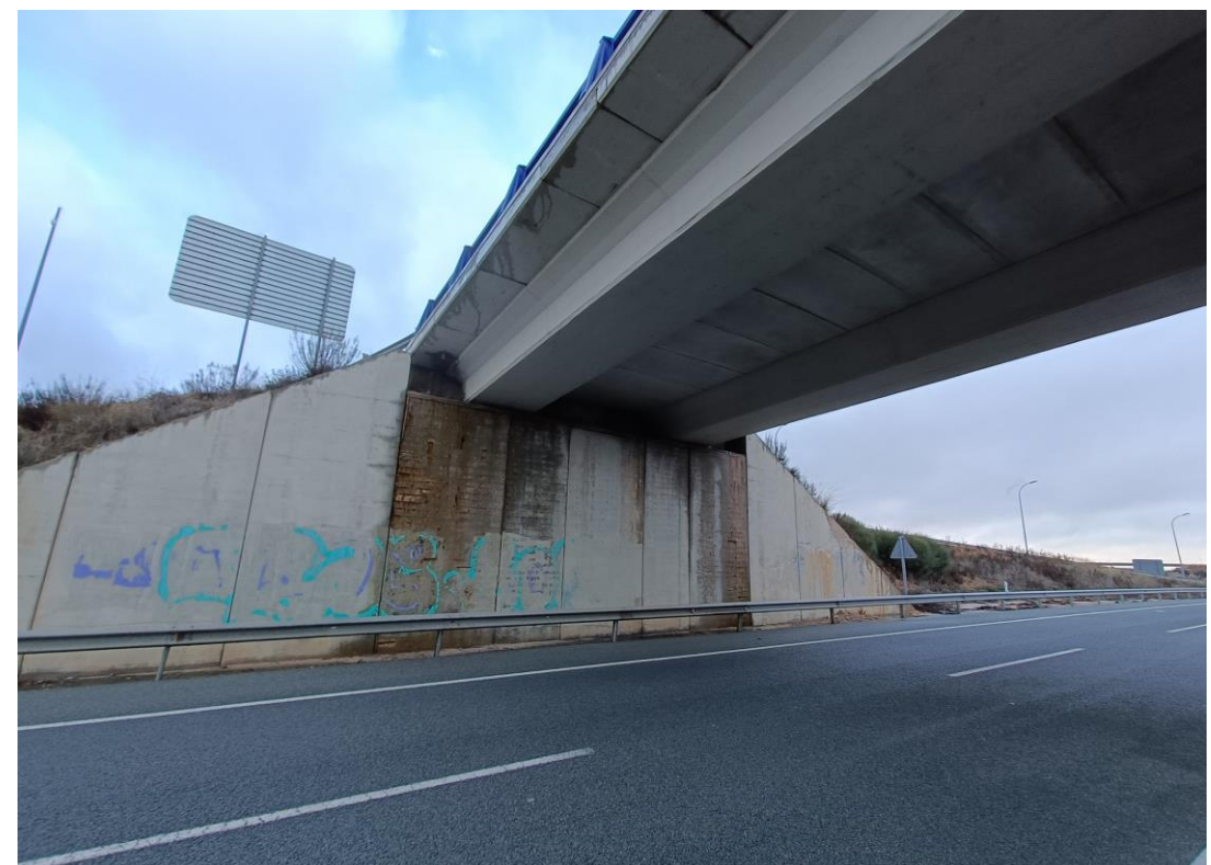
Foto Nº 28 . Estribo E2. Armaduras sin recubrimiento y oxidadas en alzados de muros. Grafitis en alzado de muros.
