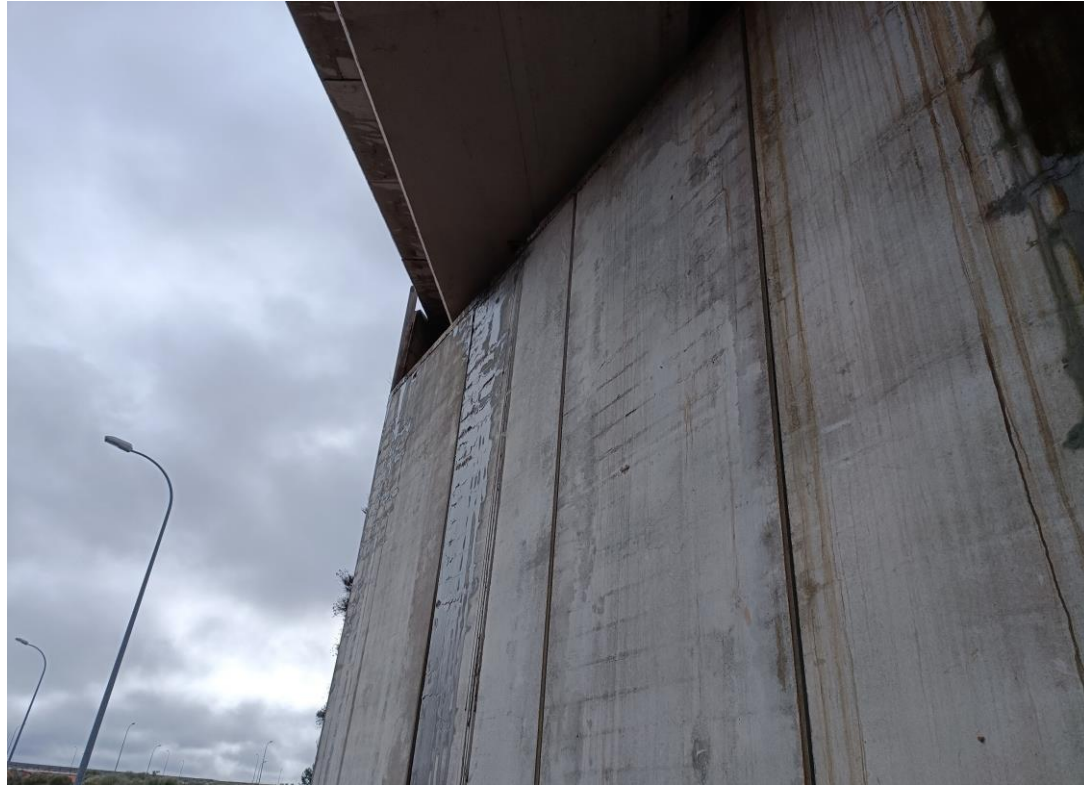
Foto Nº 37 . Agua filtrándose por el alzado de los muros del Estribo 1.
