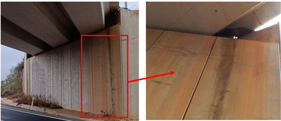
Figura 17 Humedades y eflorescencias en muros de Estribo 2
