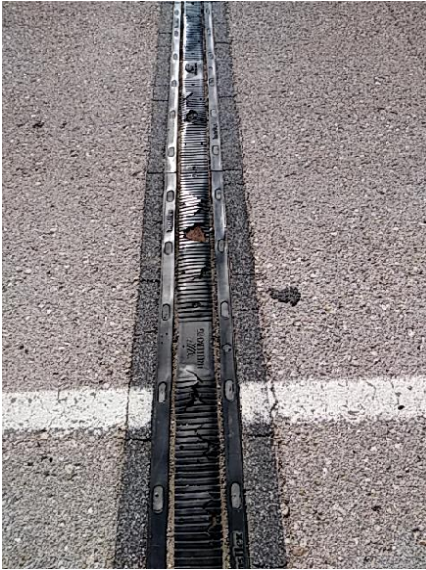
Deterioro de la Junta 1
