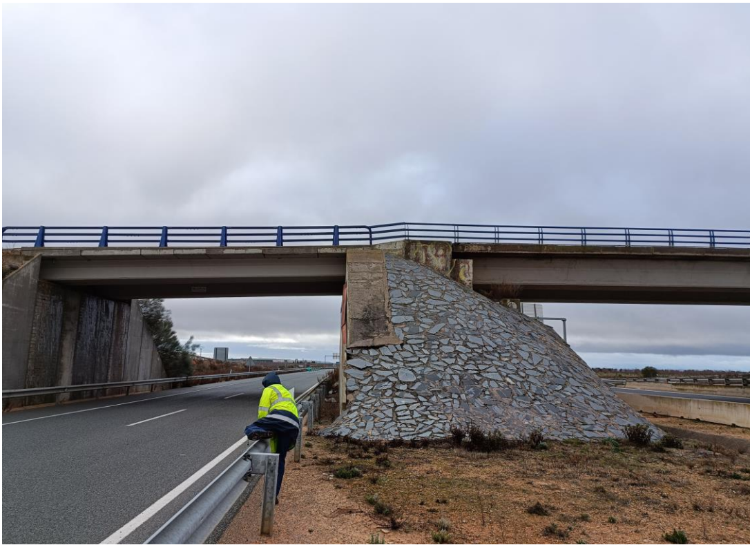
Foto Nº 25 . Estribo E2. Detalle de enchachado y hormigón sobre estribo.
