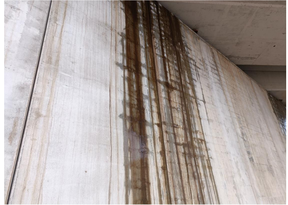
Foto Nº 39 . Falta de recubrimiento y armaduras vistas en el alzado de los muros del Estribo 1.
