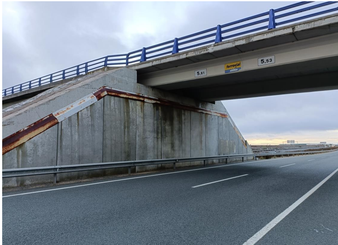
Foto Nº 21 . Estribo E1. Fisuras y eflorescencias en alzado de muros.
