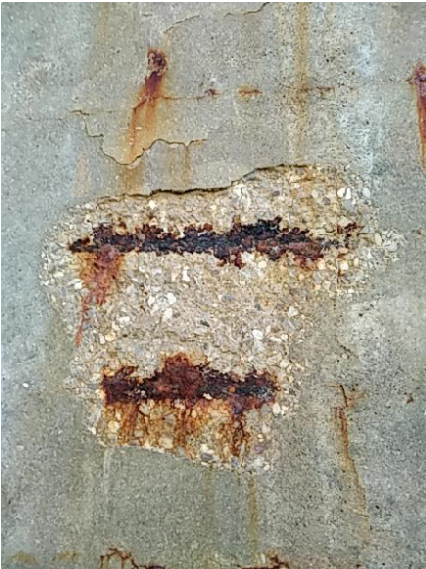
Perdida se sección en armadura en estribo 2
