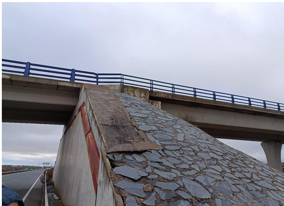
Foto Nº 22 . Estribo E2. Detalle de encachado y hormigón sobre estribo.
