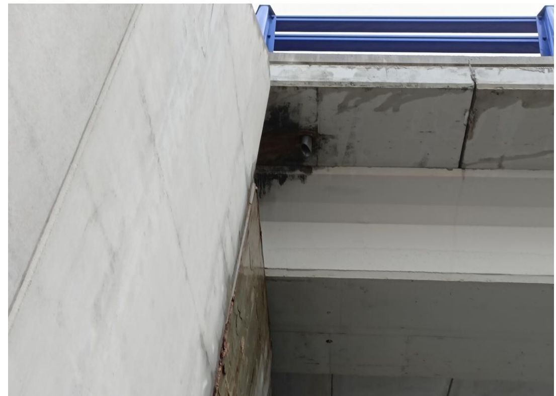
Foto Nº 24 . Detalle tubo de drenaje próximo a estribo E2.
