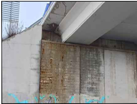
FOTO 6 HUMEDADES EN ALZADO DE MUROS DE ESTRIBO 1 EN PROXIMIDADES DEL TUBO DE DRENAJE DERECHO
