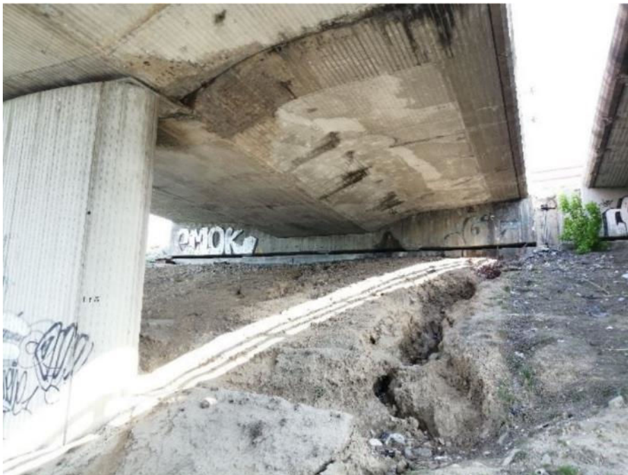
Figura 14. Vista del alzado frontal de uno de los estribos, que se encuentra prácticamente enterrado
