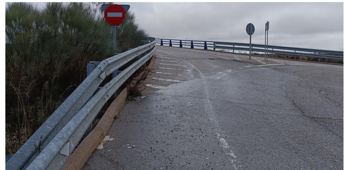
Figura 64 Grietas y zonas cuarteadas en el pavimento, zona accesos a la estructura
