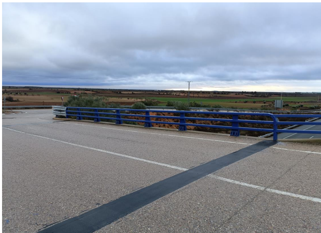
Foto N° 14 . Estado de la junta de dilatación del Paso Superior Izquierdo.
