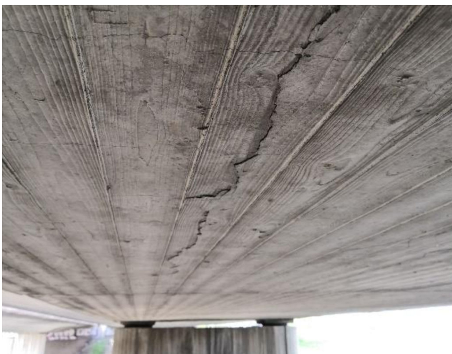
Figura 32. Fisuras longitudinales en la losa del tablero de la calzada derecha, extraído de la inspección principal de 2020
