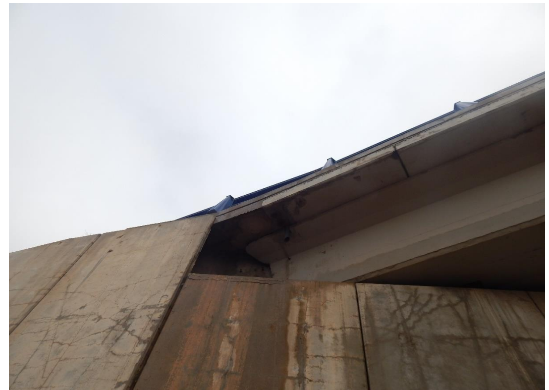
Foto Nº 12 . Humedades y eflorescencias en alzado de muros de Estribo 1.
