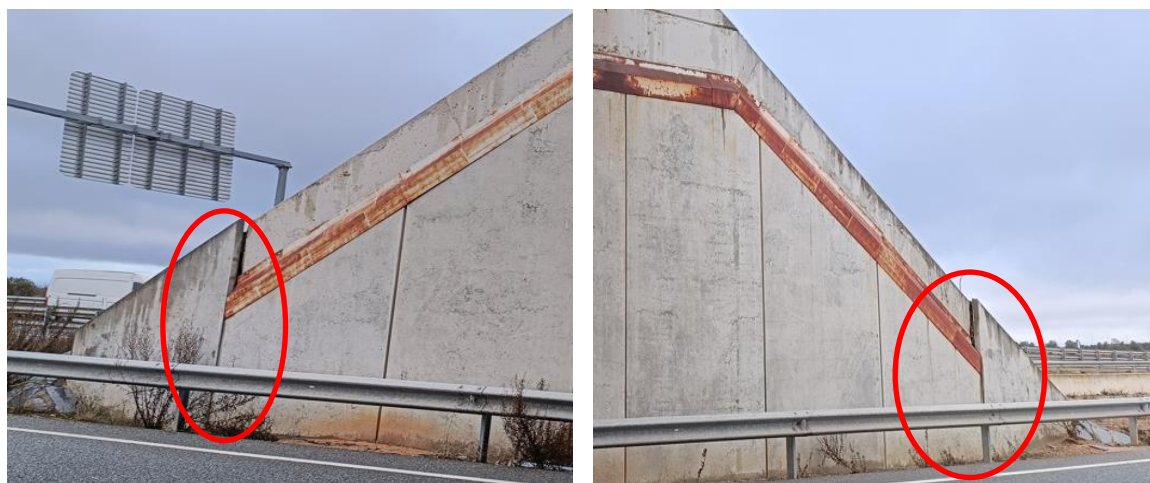
Figura 41 Basculamientos de los muros laterales extremos del estribo 1
