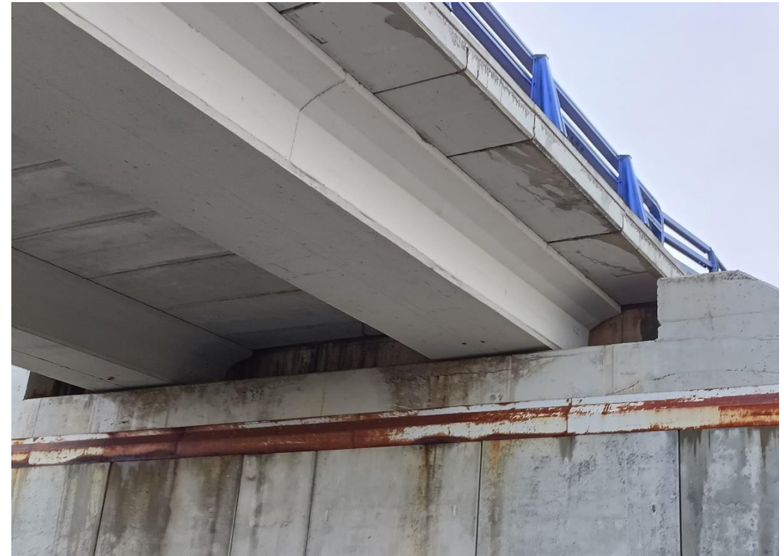
Foto Nº 15 . Estribo E1. Fisuras y eflorescencias en alzado de muros y cargadero.
