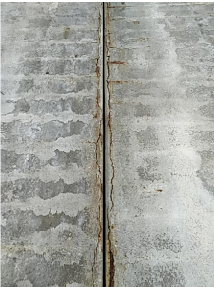
Fisuras verticales en estribo 2
