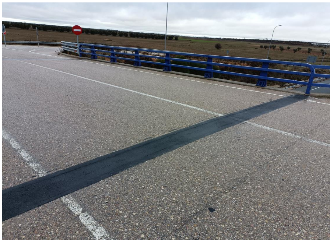
Foto Nº 2 . Vista de la plataforma del Paso Superior 0A-0004-0067+500 D. Estado de la junta de dilatación sobre el estribo E1.
