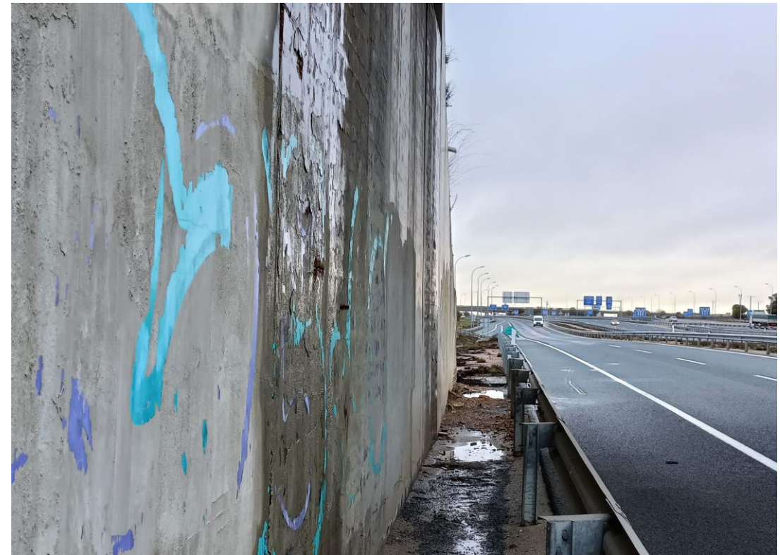
Foto Nº 23 . Estribo E2. Fisuras, eflorescencias, falta de recubrimiento y oxidación en alzado de muros. Grafitis en alzado de muros.
