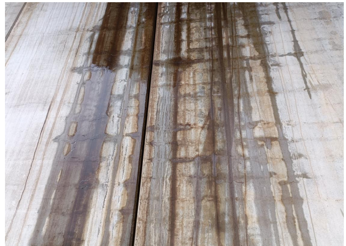
Foto Nº 36 . Falta de recubrimiento y armaduras vistas en el alzado de los muros del Estribo 1.
