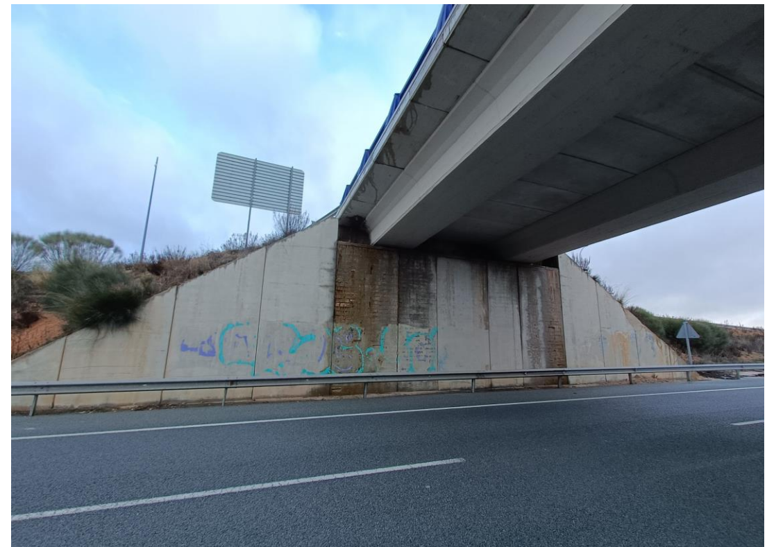
Foto Nº 27 . Estribo E2. Armaduras sin recubrimiento y oxidadas en alzados de muros. Grafitis en alzado de muros.
