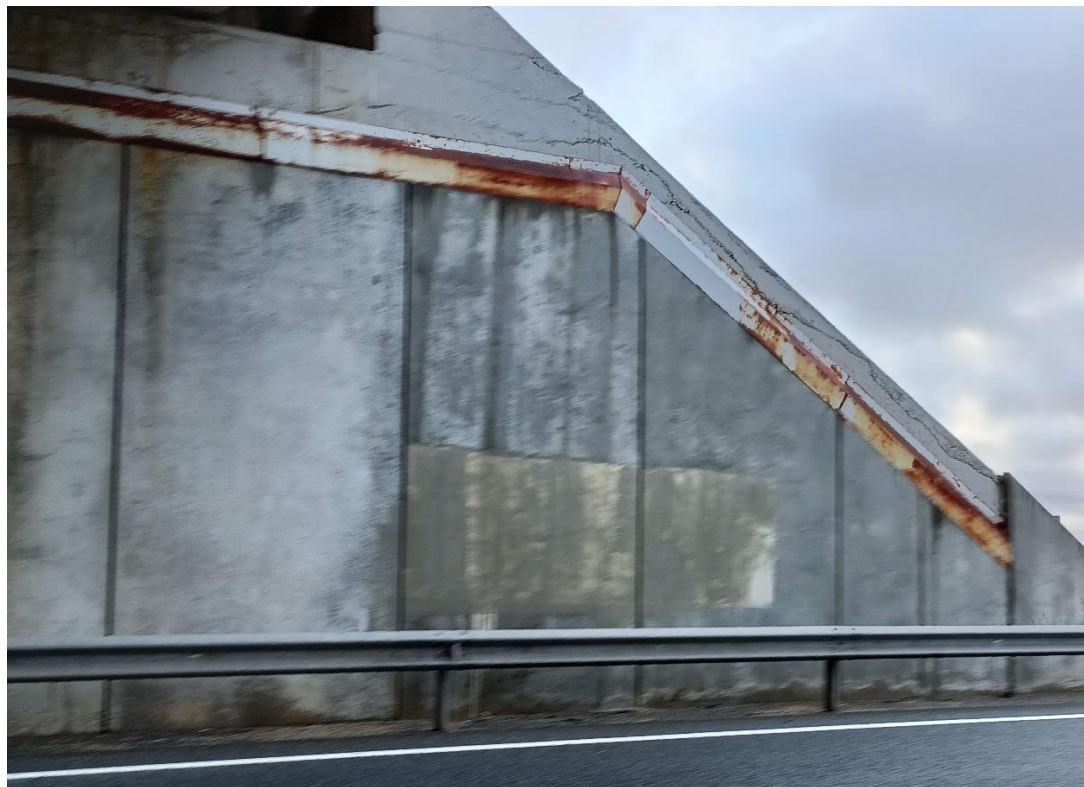
Foto Nº 14 . Estribo E1. Fisuras y eflorescencias en alzado de muros. Deformación en alzado de muro extremo.
