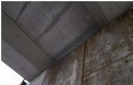
Figura 43 Manchas de humedad en la parte inferior de las prelasas
