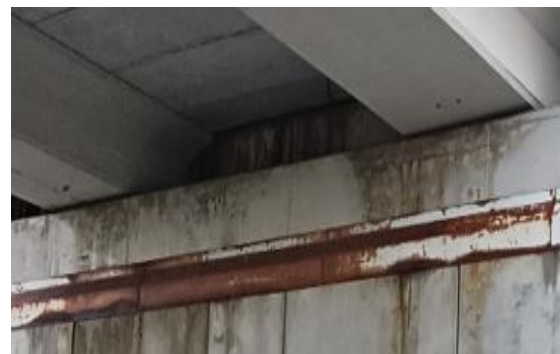
Figura 58 Fisura horizontal en el cargadero del Estribo 1, debajo de cada viga
