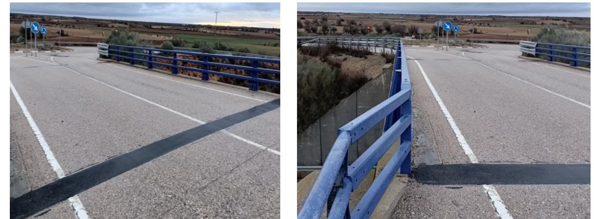
Figura 42 Estado de conservación de la junta de dilatación del Paso Superior 0A-0004-0067+500 I
