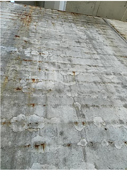
Manchas de corrosión en estribo 2
