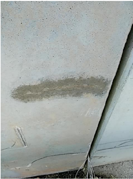
Fisuración horizontal en estribo 2
