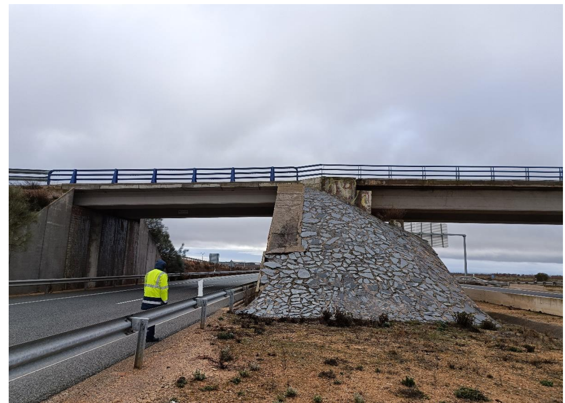
Foto Nº 24 . Estribo E2. Detalle de encachado y hormigón sobre estribo.
