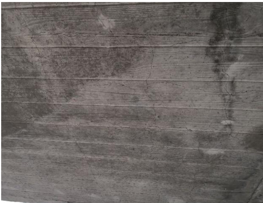
Figura 31. Fisuras en mapa en la losa del tablero de la calzada derecha, extraído de la inspección principal de 2020
