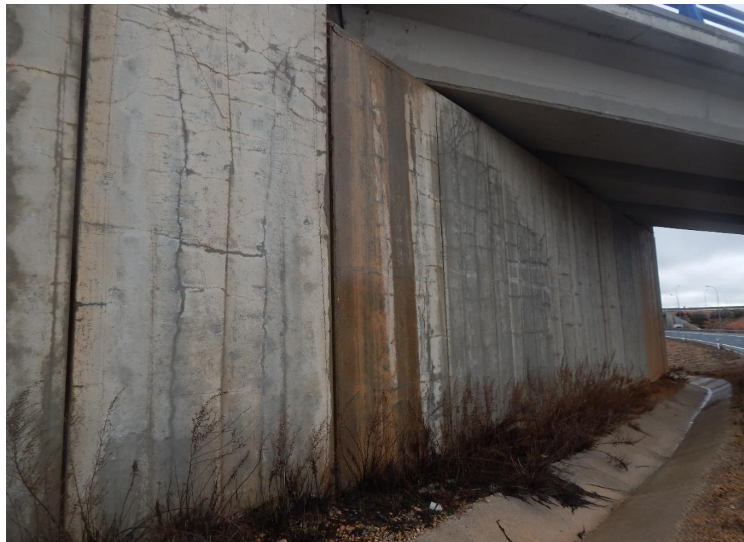
Foto Nº 10 . Humedades y eflorescencias en alzado de muros de Estribo 1.
