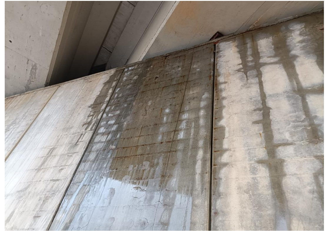
Foto Nº 31 . Falta de recubrimiento y armaduras vistas en el alzado de los muros del Estribo 1.
