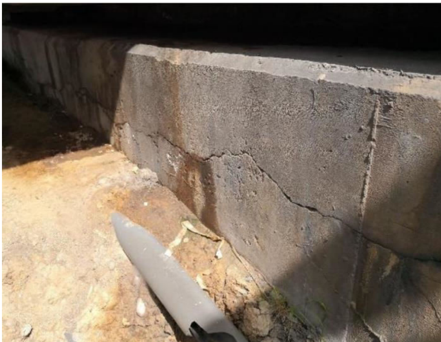
Figura 20. Manchas de humedad y fisuras horizontales en el muro frontal del estribo 1 de la calzada derecha, extraída de la inspección realizada en 2024
