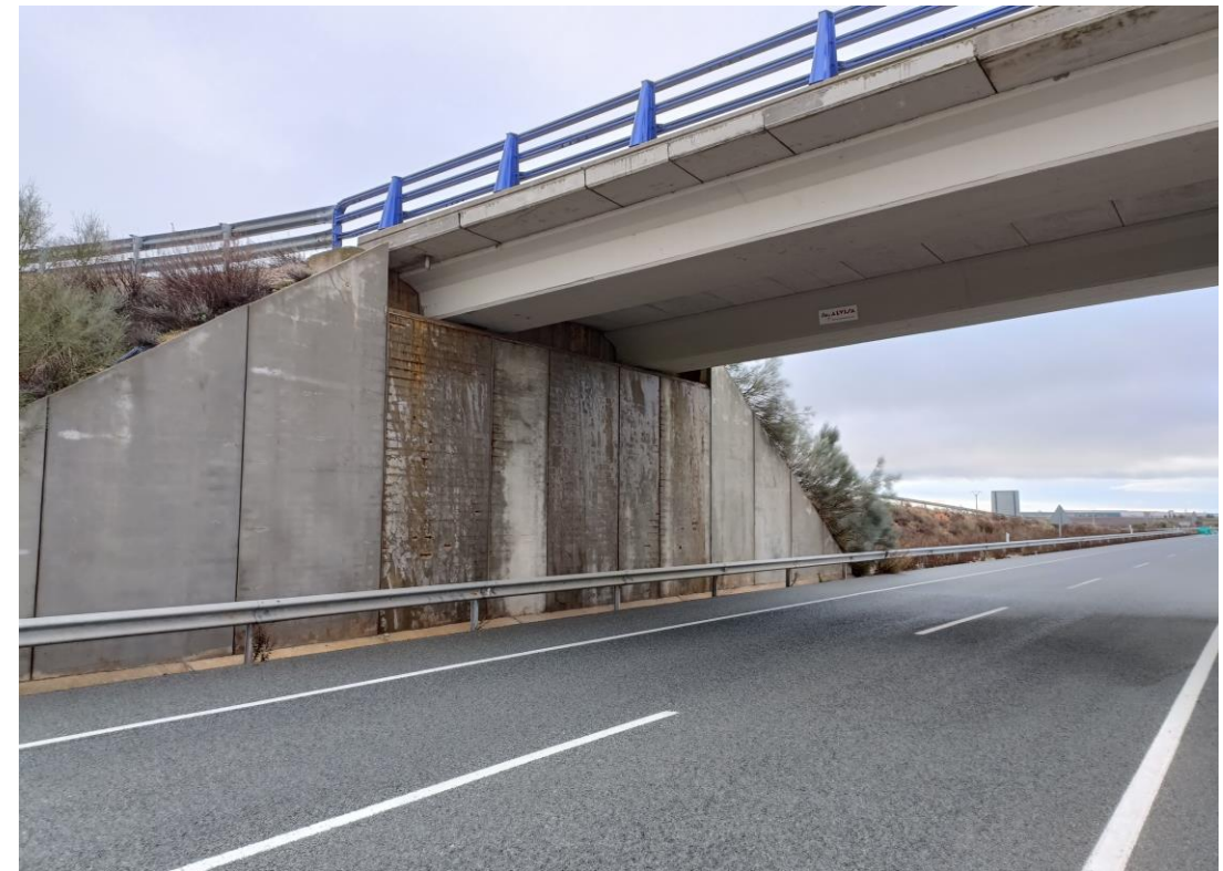
Foto Nº 36 . Alzado de estribo E1. Estado de conservación.
