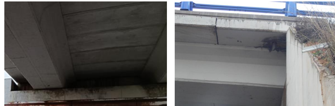
Figura 62 Manchas de humedad en la parte inferior de las prelosas
