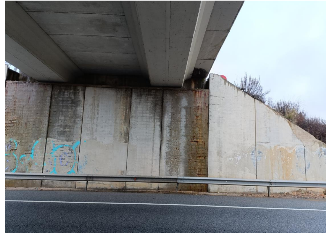
Foto Nº 35 . Estribo E2. Fisuras y eflorescencias en alzado de muros. Grafitis en alzado de muros.
