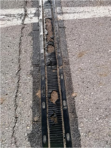
Deterioro de la Junta 2
