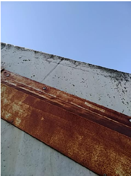
Fisura inclinada en estribo 1
