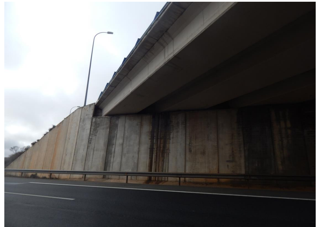
Foto Nº 56 . Vista inferior del Paso Inferior. Viga artesa extrema en buen estado de conservación.
