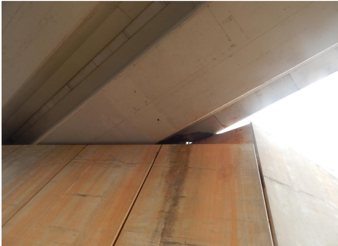
Foto Nº 45 . Humedades y eflorescencias en espaldón de Estribo 2. Manchas de humedad en el tablero.
