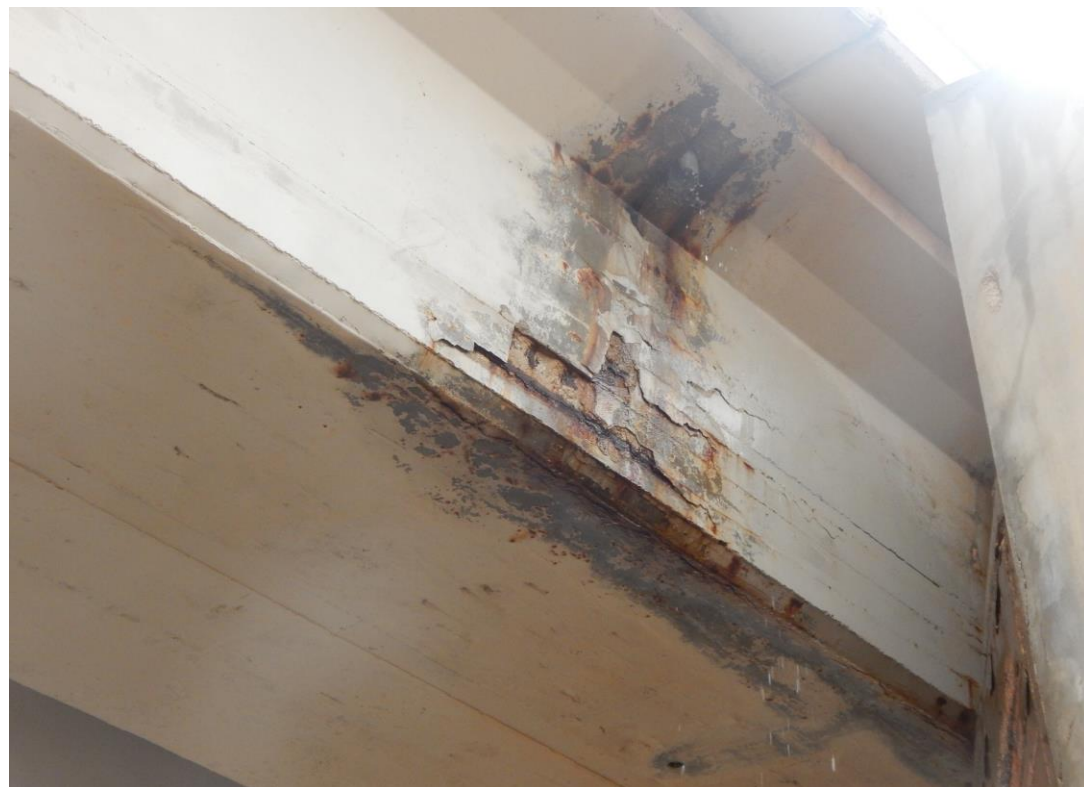
Foto Nº 58 . Viga artesa extrema con falta de recubrimiento y armaduras vistas. Agua saliendo por el tubo de drenaje.
