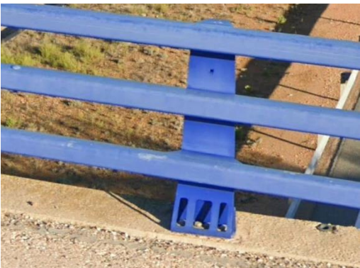
Figura 47 Decoloración incipiente en pintura protectora del sistema de contención derecho
