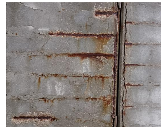
Figura 37 Detalle de armaduras oxidadas y falta de recubrimiento en estribo 2
