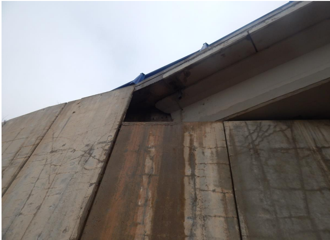
Foto Nº 13 . Humedades y eflorescencias en alzado de muros de Estribo 1.
