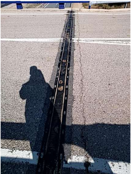
Junta de dilatación en estribo 2
