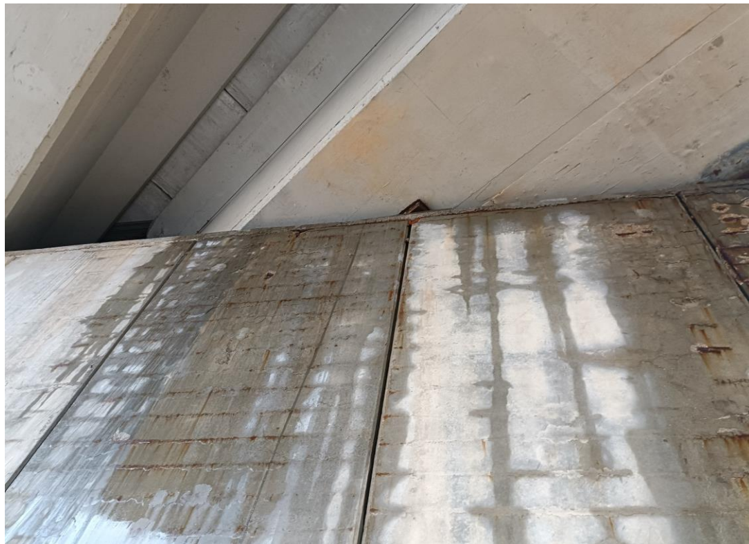
Foto Nº 30 . Falta de recubrimiento y armaduras vistas en el alzado de los muros del Estribo 1.
