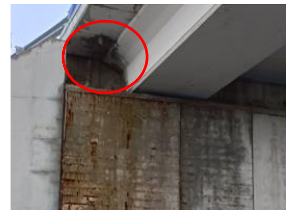
Figura 53 Humedades y escurridos en proximidades de tubos de drenaje
