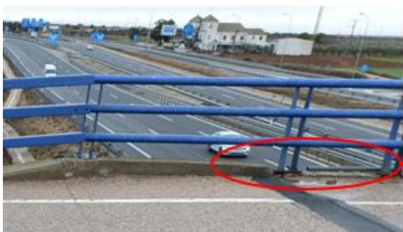
Figura 67 Zona de unión de los sistemas de contención lateral y central.
