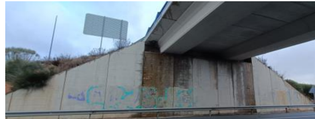
Figura 59 Pintadas vandálicas en los alzados de los muros del Estribo 2
