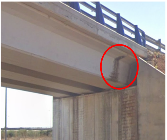
Figura 28 Esgurrido y humedades en proximidades de tubos de drenaje de Estribo 1
