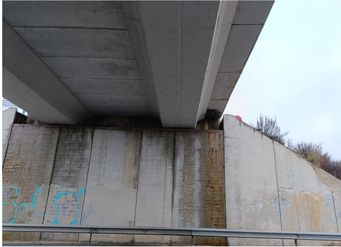
Foto Nº 37 . Estribo E2. Fisuras y eflorescencias en alzado de muros. Grafitis en alzado de muros.
