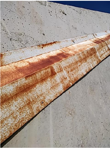
Deterioro chapa protectora en estribo 1
