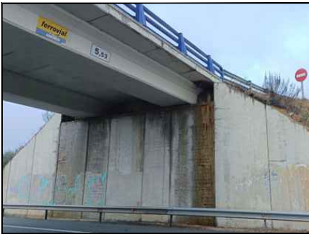
FOTO 7 HUMEDADES EN ALZADO DE MUROS DE ESTRIBO 1 EN PROXIMIDADES DEL TUBO DE DRENAJE IZQUIERDO
