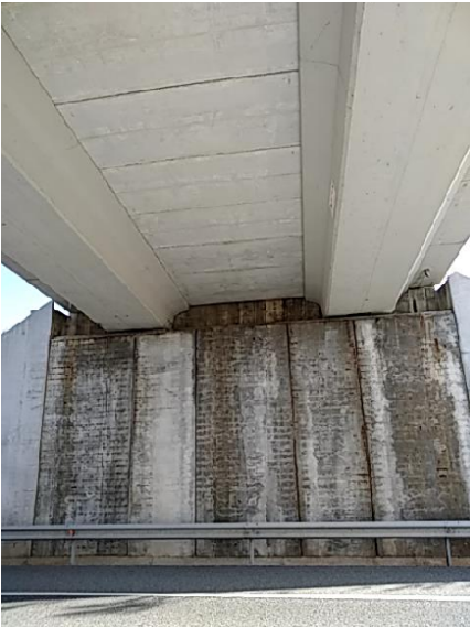
Pátinas en cargadero de estribo 2
