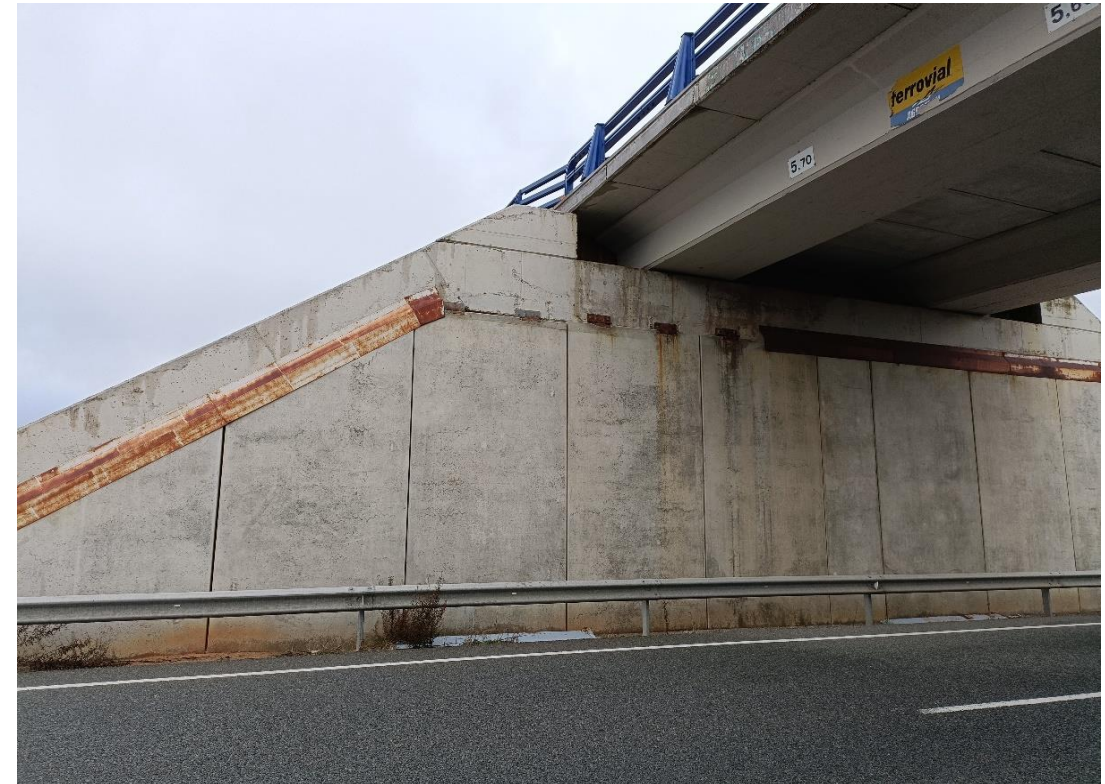
Foto Nº 7 . Vista estribo E2. Humedades y eflorescencias en cargadero y alzado de muros.
