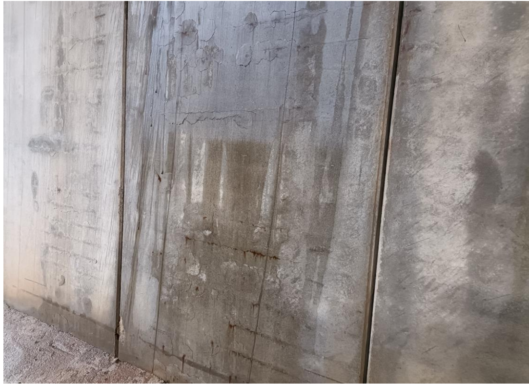
Foto Nº 33 . Falta de recubrimiento y armaduras vistas en el alzado de los muros del Estribo 1.
