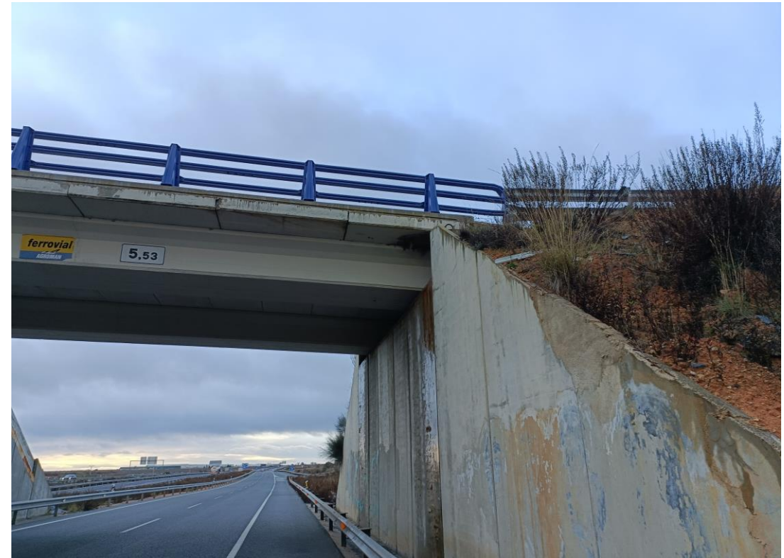
Foto Nº 43 . Estribo E2. Alzado de muros en prolongación conteniendo el terraplén. Restitución geometría original en alzado de muros.
