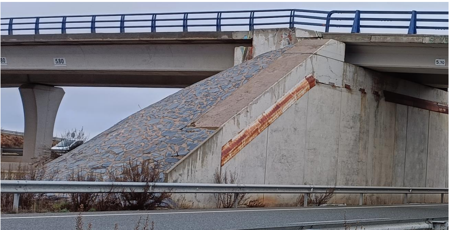
Figura 13 Apoyo central del Paso Superior 0A-0004-0067+500-I compartido con el paso superior sobre la autovía
