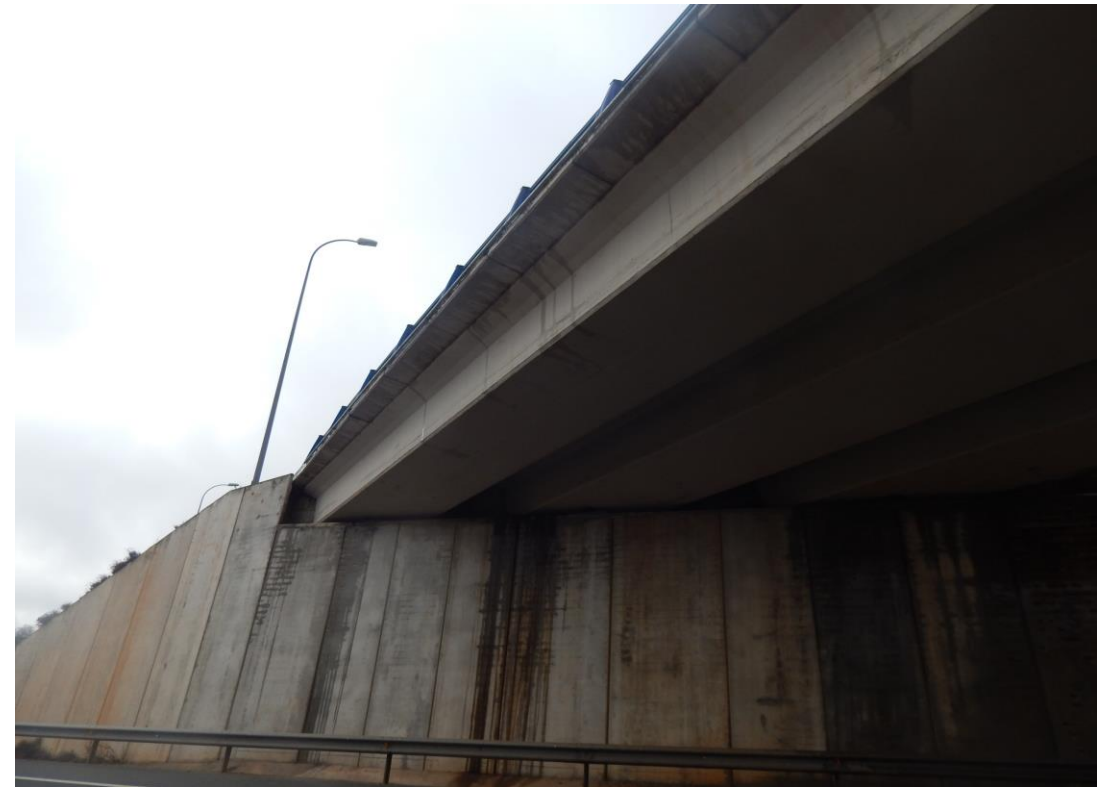
Foto Nº 55 . Vista inferior del Paso Inferior. Viga artesa extrema en buen estado de conservación.
