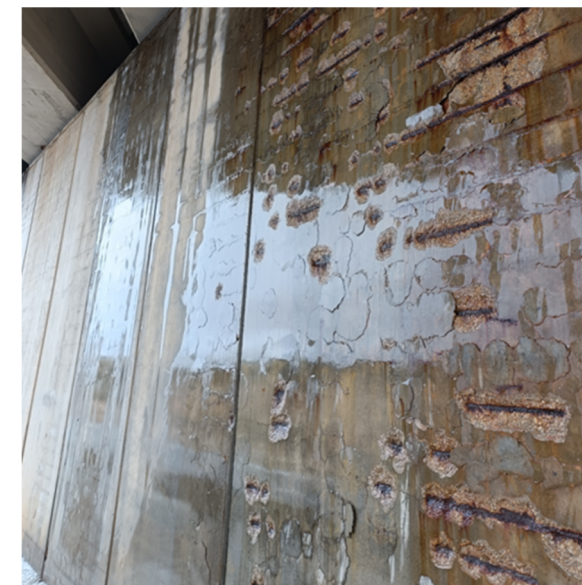
Figura 21 Agua escurriendo por el frente del Estribo 1
