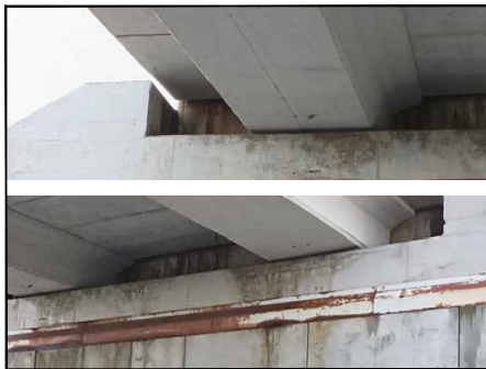
FOTO 3 FISURA HORIZONTAL EN EL CARGADERO DEL ESTRIBO 2, DEBAJO DE CADA VIGA
