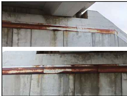
FOTO 2 MANCHAS PUNTUALES DE ÓXIDO EN LAS PROXIMIDADES DE LAS CHAPAS METÁLICAS DE ESTRIBO 2
