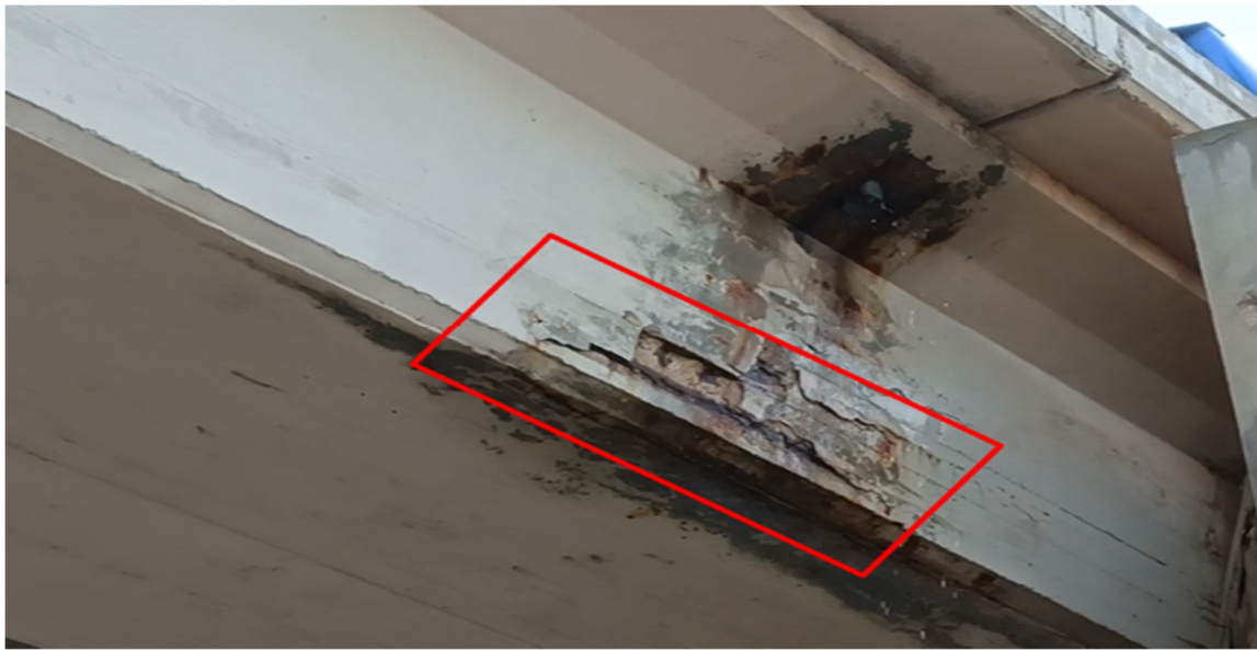
Figura 25 Pérdida de recubrimiento en armadura de viga artesa extrema próxima a Estribo 1
