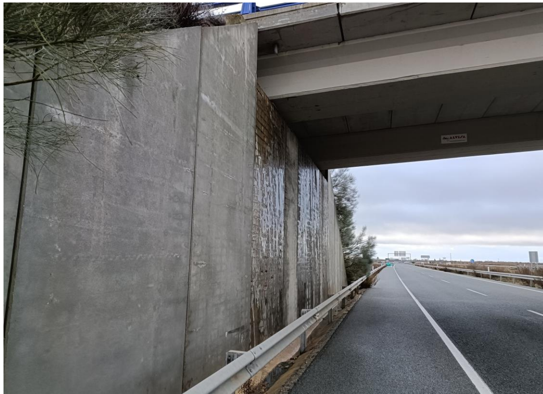
Foto Nº 34 . Estribo E1. Agua discurriendo por alzado de estribo en zona de desagüe de los tubos de drenaje.
