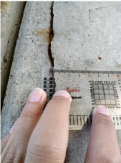
Fisuración vertical en estribo 2
