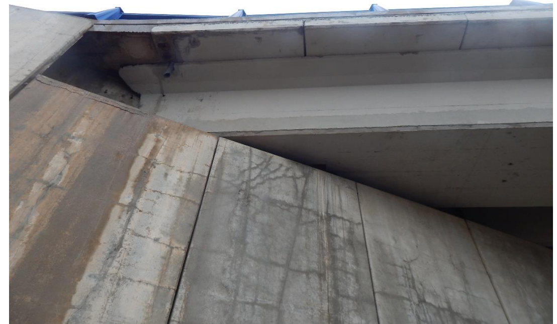
Foto Nº 11 . Humedades y eflorescencias en alzado de muros de Estribo 1.
