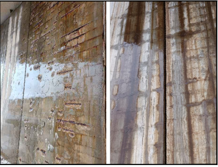
FOTO 6 AGUA ESCURRIENDO POR EL FRENTE DEL ESTRIBO 1
