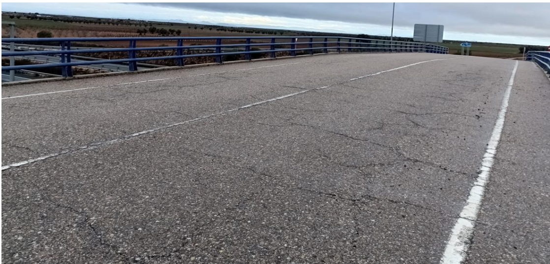
Figura 45 Grietas y zonas cuarteadas en el pavimento
