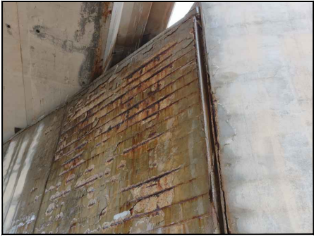
FOTO 4 ARMADURAS OXIDADAS EN MURO DEL ESTRIBO 1
