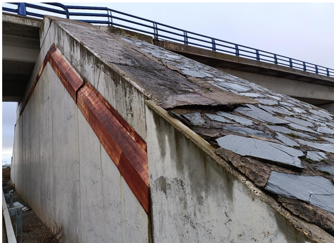
Foto Nº 18 . Estribo E2. Detalle de falta de alineación de muro extremo. Detalle de enchado sobre estribo.
