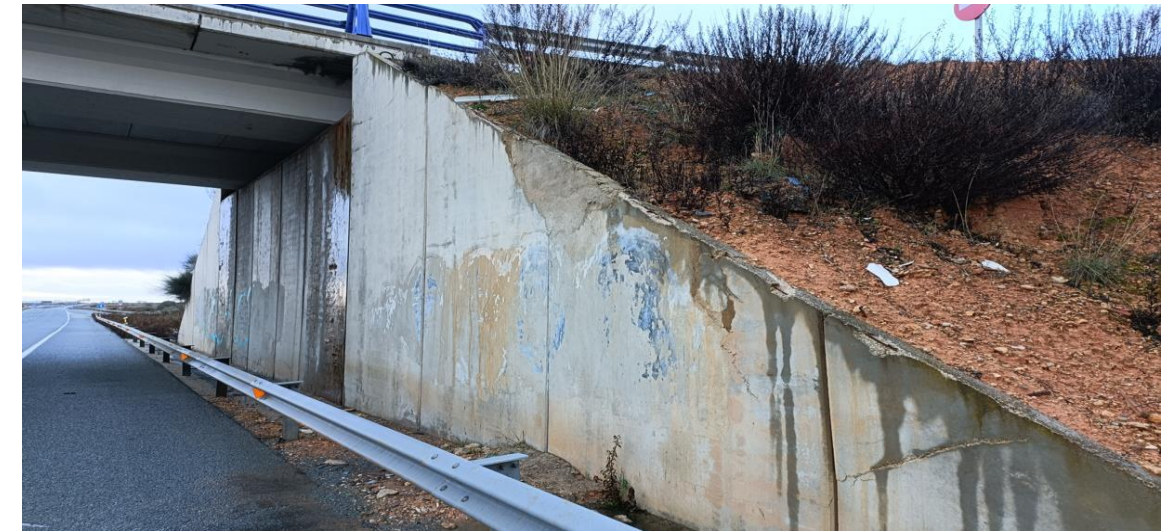
Figura 52 Humedades en alzado de los muros de prolongación de Estribo 2
