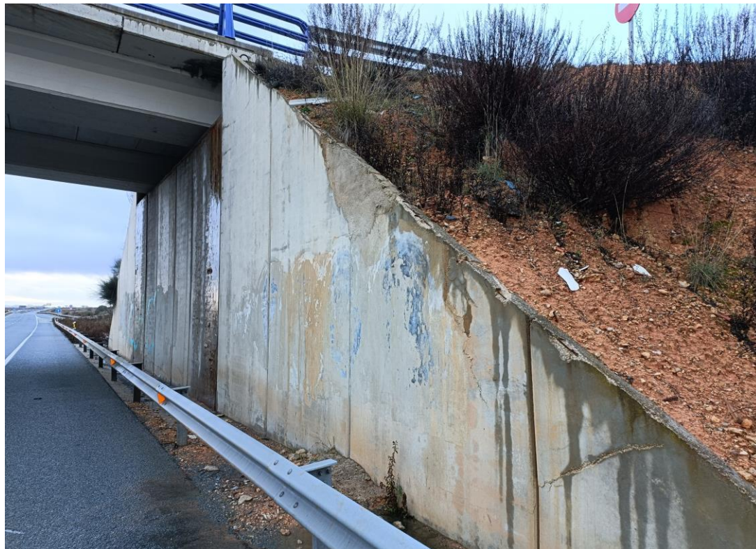
Foto Nº 42 . Estribo E2. Alzado de muros en prolongación conteniendo el terraplén. Restitución geometría original en alzado de muros.
