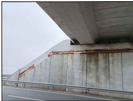
FOTO 1 HUMEDADES Y EFLORESCENCIAS EN MUROS DE ESTRIBO 2
