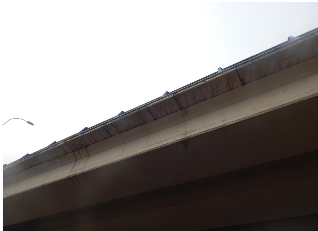
Foto Nº 54 . Vista inferior del Paso Inferior. Filtración del agua desde el tablero por falta de vierteaguas o goterón.
