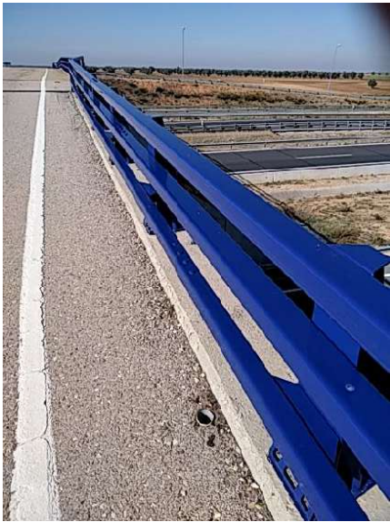
Pretil metálico en lado PK-
