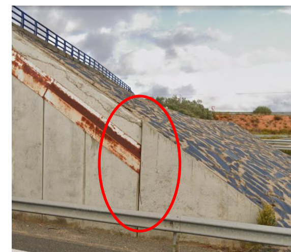
Figura 60 Basculamientos de los muros laterales extremos del Estribo 1
