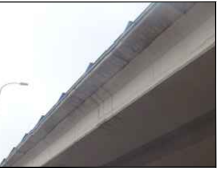
FOTO 14 MANCHAS DE HUMEDAD EN LOS EXTREMOS DE LAS PRELOSAS
