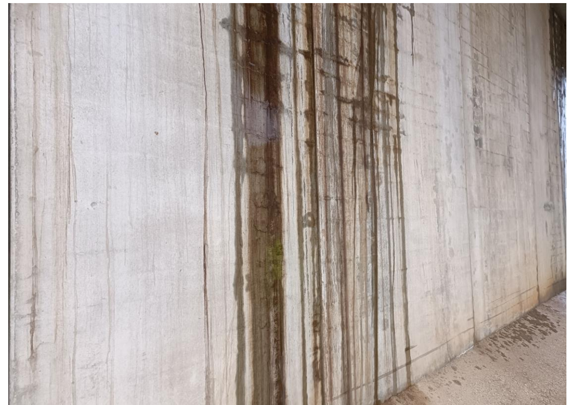
Foto Nº 40 . Falta de recubrimiento y armaduras vistas en el alzado de los muros del Estribo 1.
