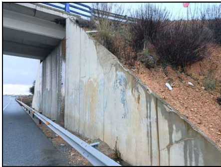
FOTO 8 HUMEDADES EN ALZADO DE LOS MUROS EN PROLONGACIÓN DE ESTRIBO 1
