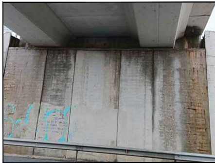
FOTO 10 ARMADURAS OXIDADAS EN LOS ALZADOS DE LOS MUROS DEL ESTRIBO 1
