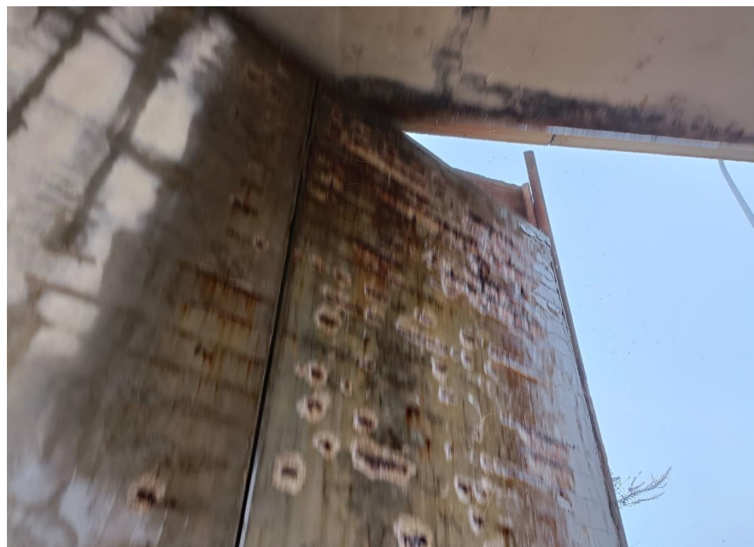
Foto Nº 26 . Falta de recubrimiento y armaduras vistas en el alzado de los muros del Estribo 1.
