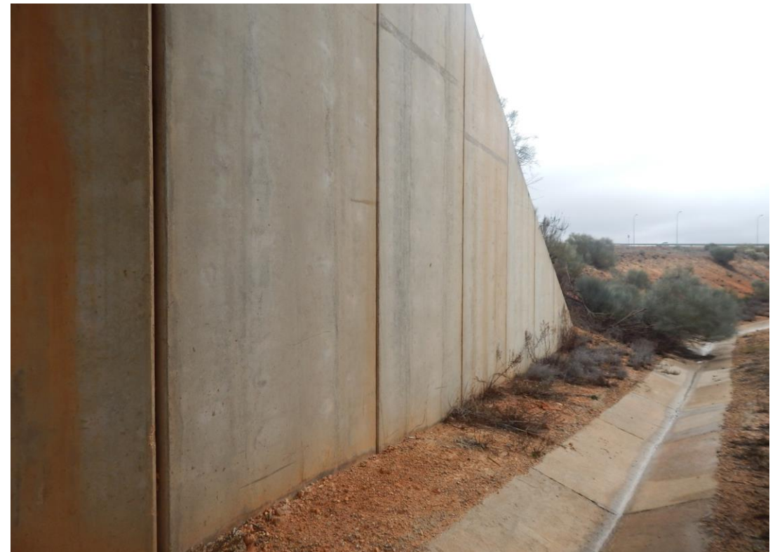
Foto Nº 48 . Muros de acompañamiento en Estribo 2.
