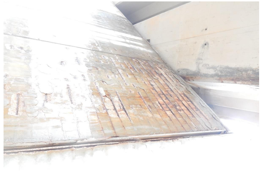
Foto Nº 16 . Falta de recubrimiento y armaduras vistas en el alzado de los muros del Estribo 1.
