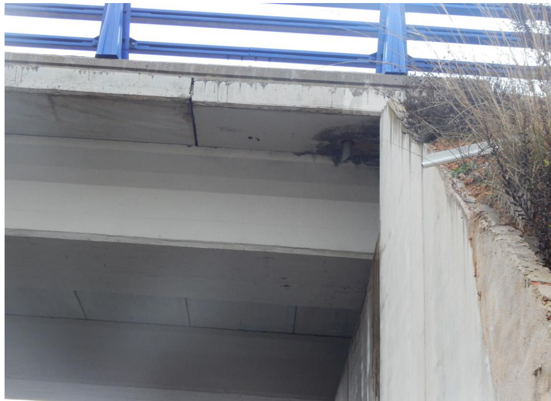
Foto Nº 25 . Detalle tubo de drenaje próximo a estribo E3.
