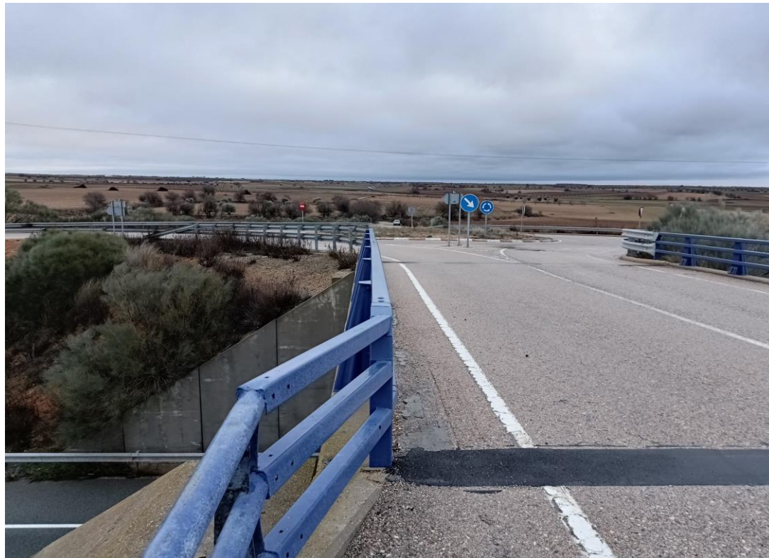
Foto Nº 9 . Vista de la plataforma del Paso Superior 0A-0004-0067+500 I. Estado de la junta de dilatación sobre el estribo E2. Transición entre los sistemas de contención del Paso Superior Central y el Izquierdo.
