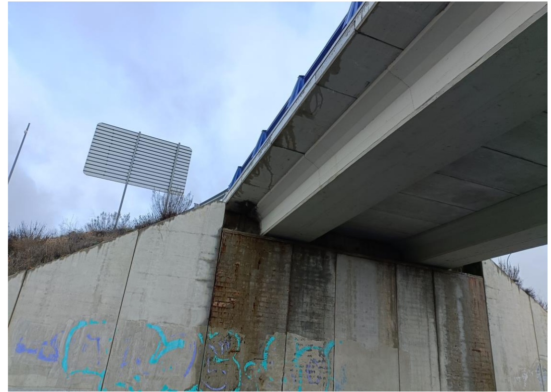
Foto Nº 31 . Estribo E2. Armaduras sin recubrimiento y oxidadas en alzados de muros. Grafitis en alzado de muros.
