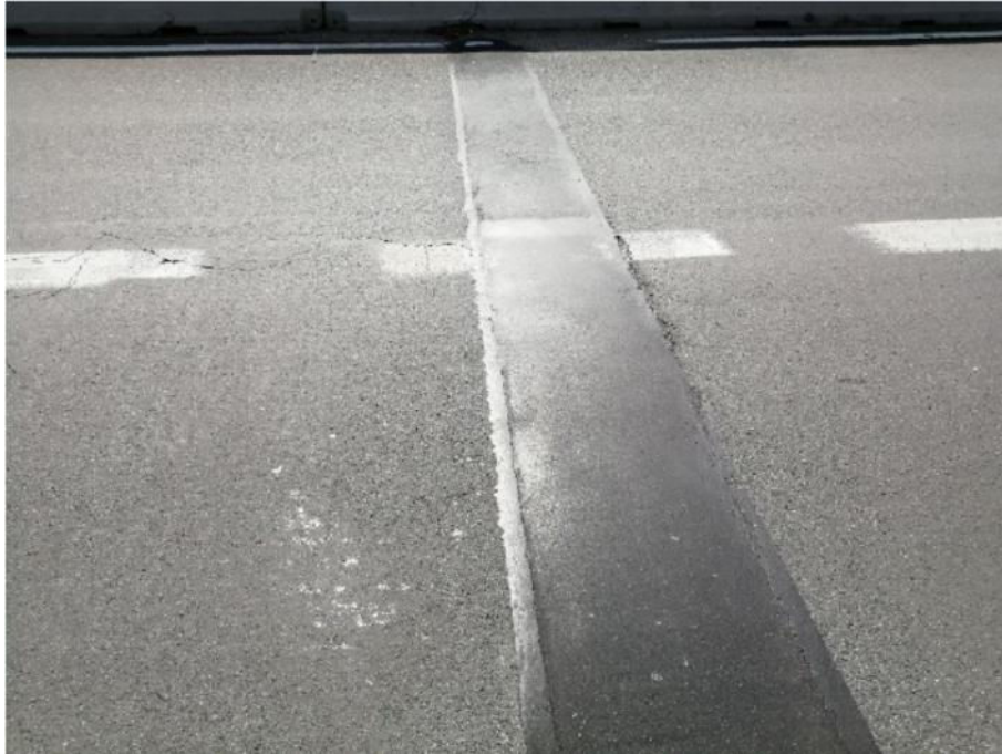
Figura 17. Juntas de betún modificado en los apoyos a media madera
