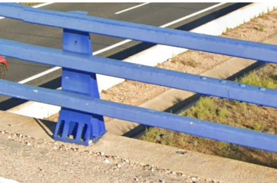
Figura 46 Puntos de descascarillamiento en pintura protectora de los largueros horizontales del sistema de contención derecho.
