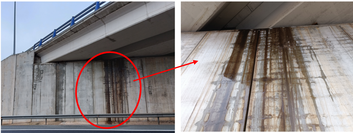
Figura 15 Manchas de humedad, escurridos y eflorescencias en Estribo 1
