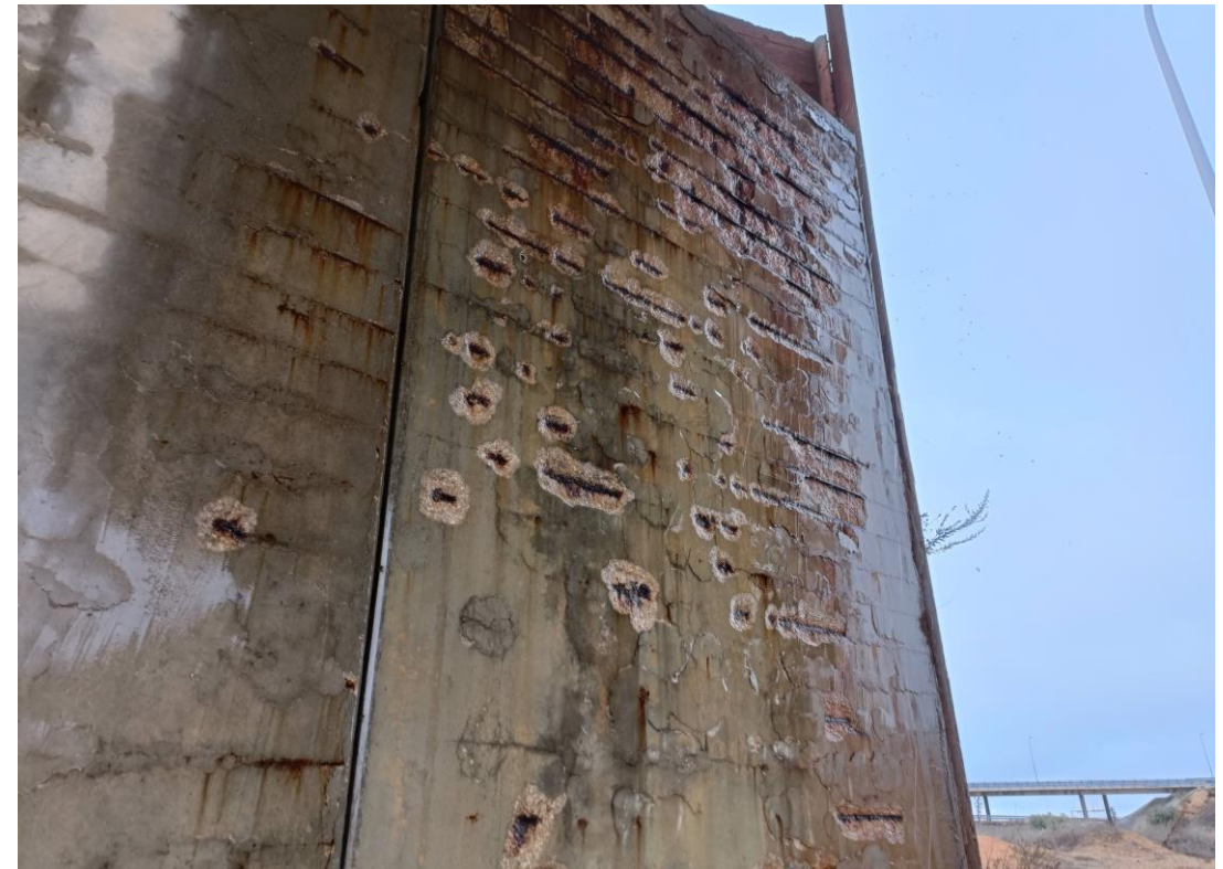
Foto Nº 27 . Falta de recubrimiento y armaduras vistas en el alzado de los muros del Estribo 1.
