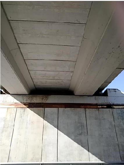
Pátinas en cargadero de estribo 1
