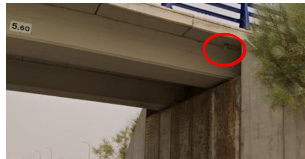
Figura 18 Tubo de drenaje 2 del Paso Superior 0A-0004-0067+500-I
