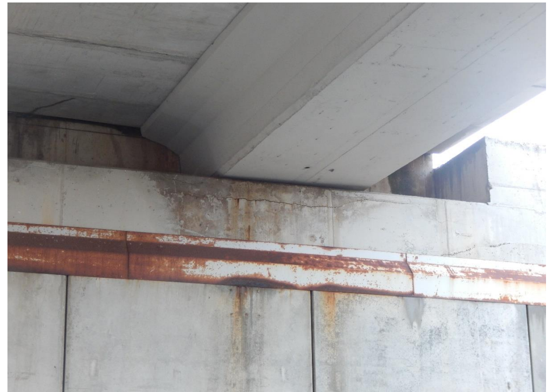
Foto Nº 7 . Fisura horizontal en cargadero debajo de la viga.
