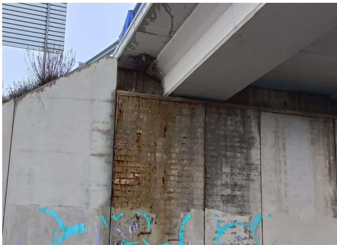
Foto Nº 26 . Estribo E2. Armaduras sin recubrimiento y oxidadas en alzados de muros. Grafitis en alzado de muros.
