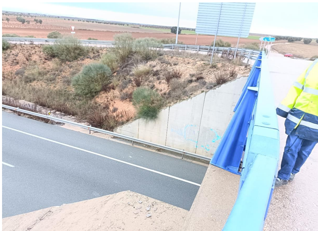
Foto Nº 2 . Vista de la autovía desde plataforma del paso superior central. Detalle sistema de contención.
