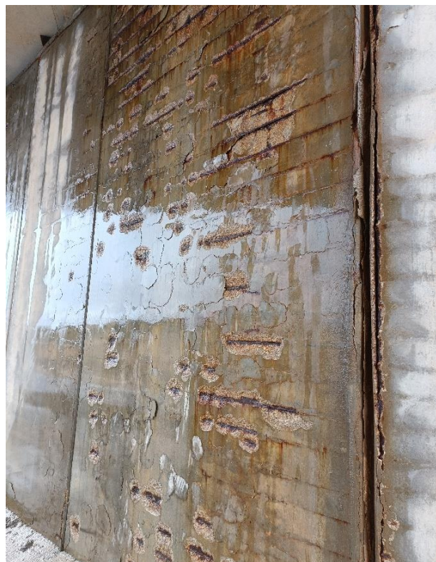
Foto Nº 22 . Falta de recubrimiento y armaduras vistas en el alzado de los muros del Estribo 1.
