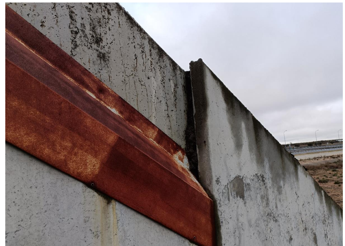
Foto Nº 20 . Estribo E2. Detalle de falta de alineación de muro extremo.
