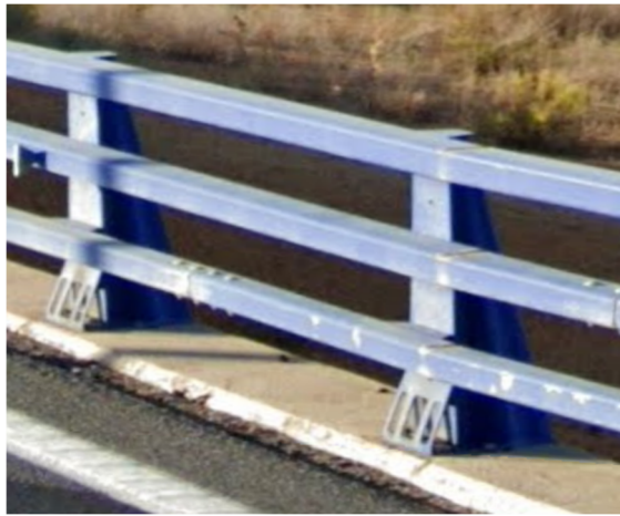
Figura 30 Decoloración incipiente en pintura protectora del sistema de contención
