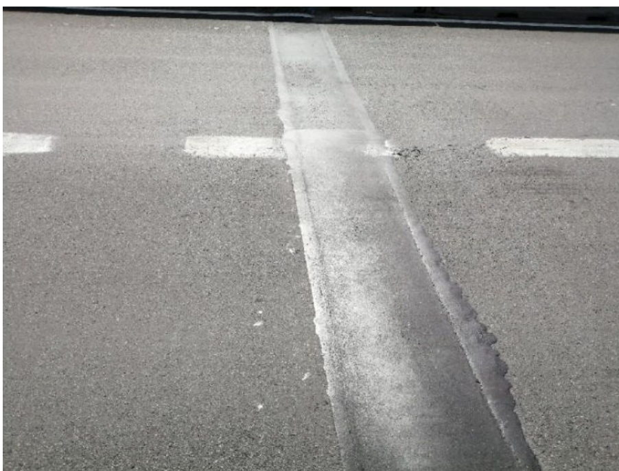
Figura 37. Juntas de betún modificado de los apoyos a media madera, en estado razonablemente bueno. Inspección principal de 2020
