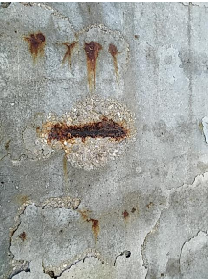
Armadura vista en estribo 2
