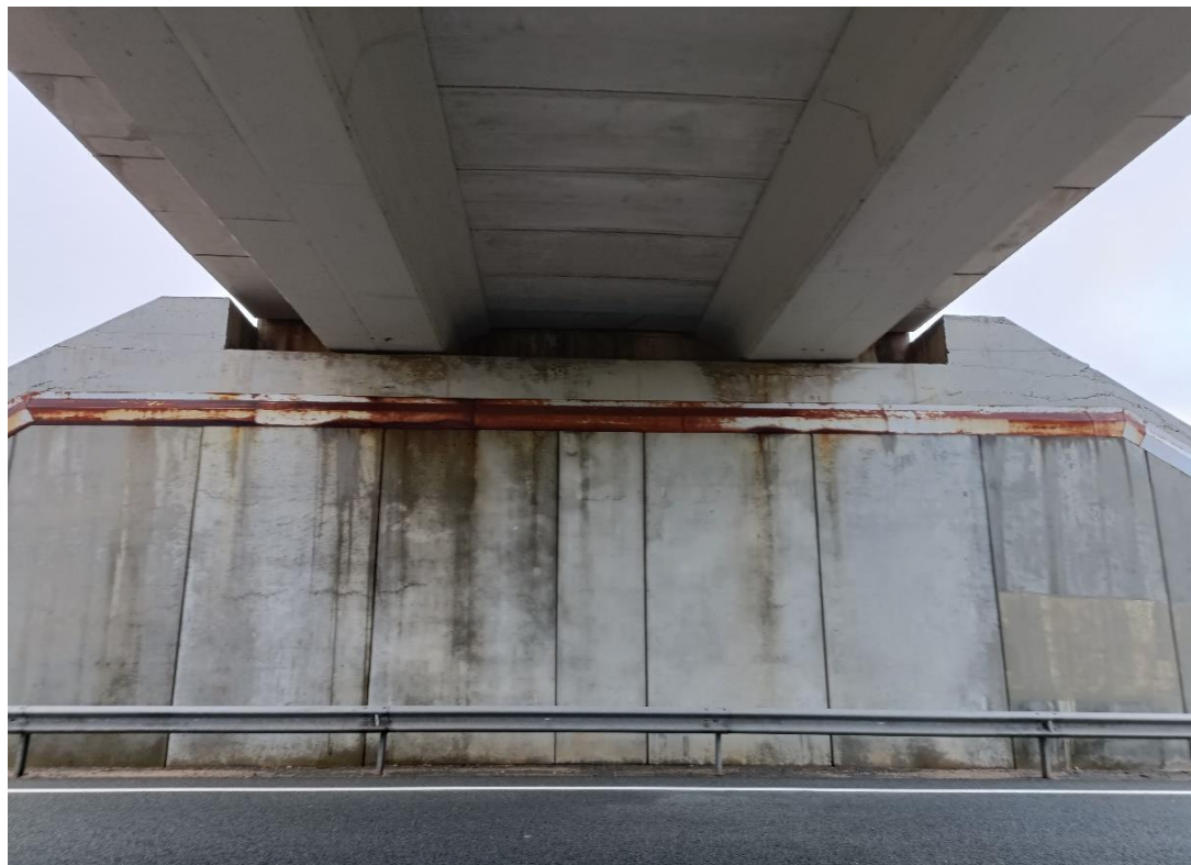
Foto N° 10 . Estribo E1. Fisuras y eflorescencias en alzado de muros.
