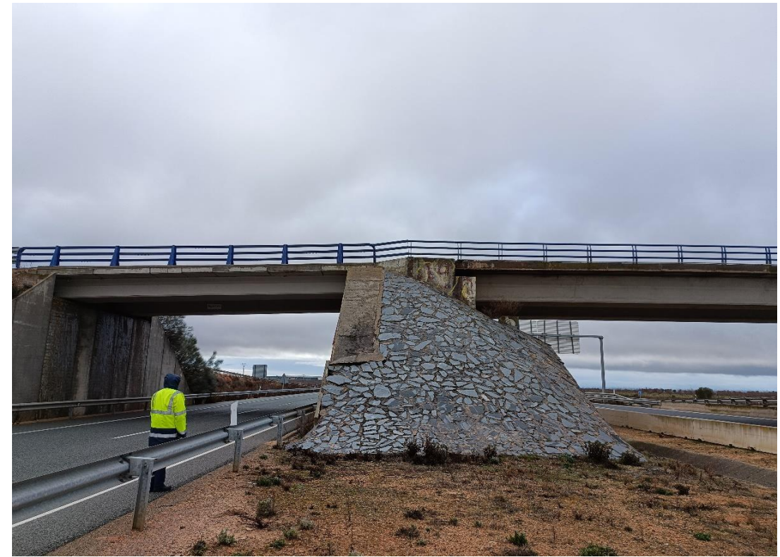
Foto Nº 23 . Estribo E2. Detalle de encachado y hormigón sobre estribo.
