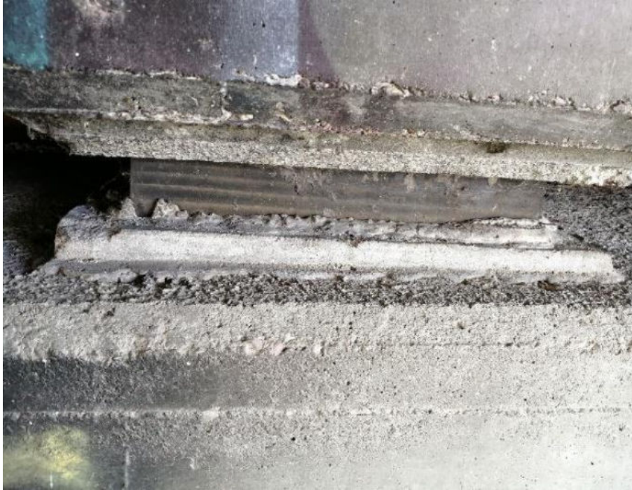
Figura 35. Apoyo de neopreno del estribo 2 de la calzada izquierda
