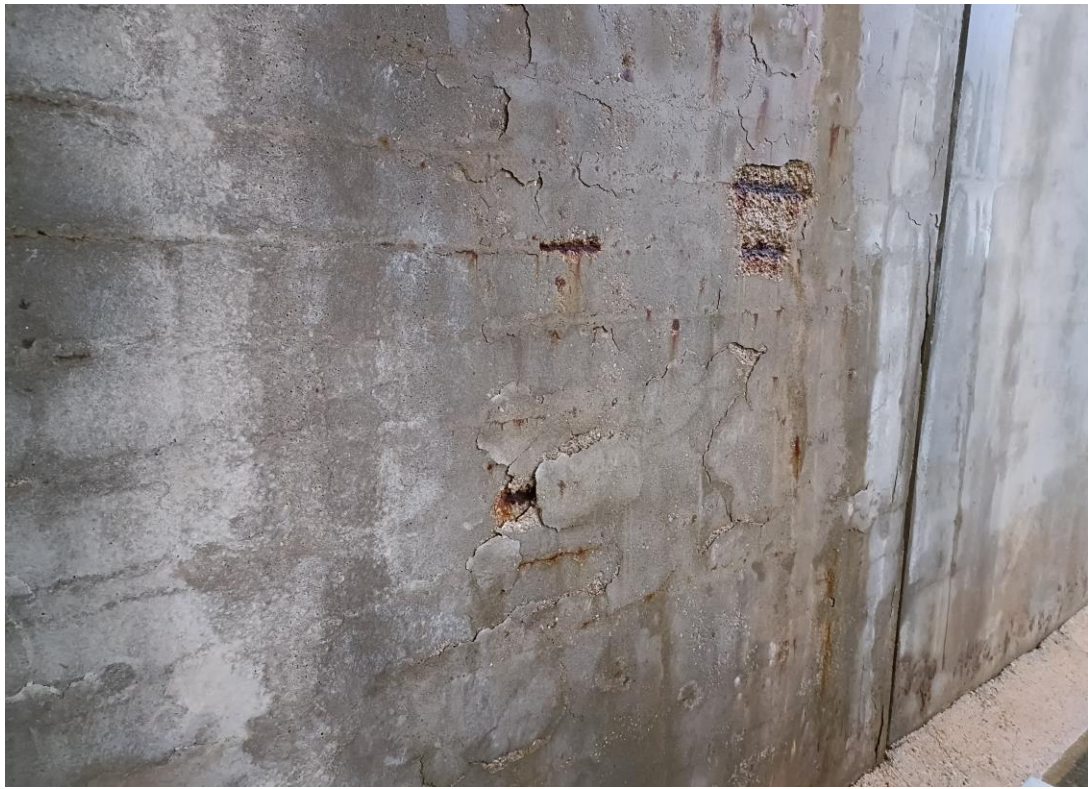
Foto Nº 28 . Estribo E1. Detalle de oxidación de barras y falta de recubrimiento en alzado de muros. Manchas de humedad y eflorescencias en alzado de muros.
