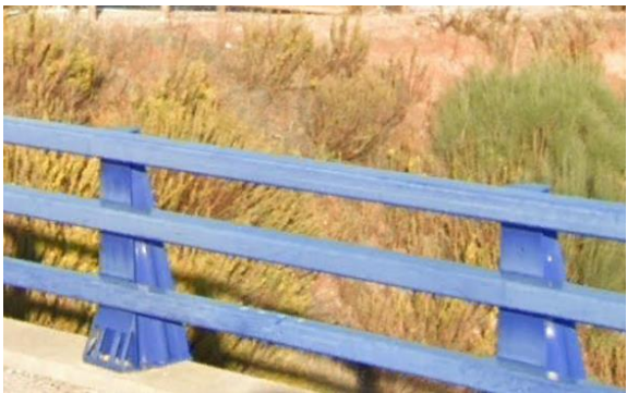
Figura 66 Decoloración incipiente en pintura protectora del sistema de contención derecho
