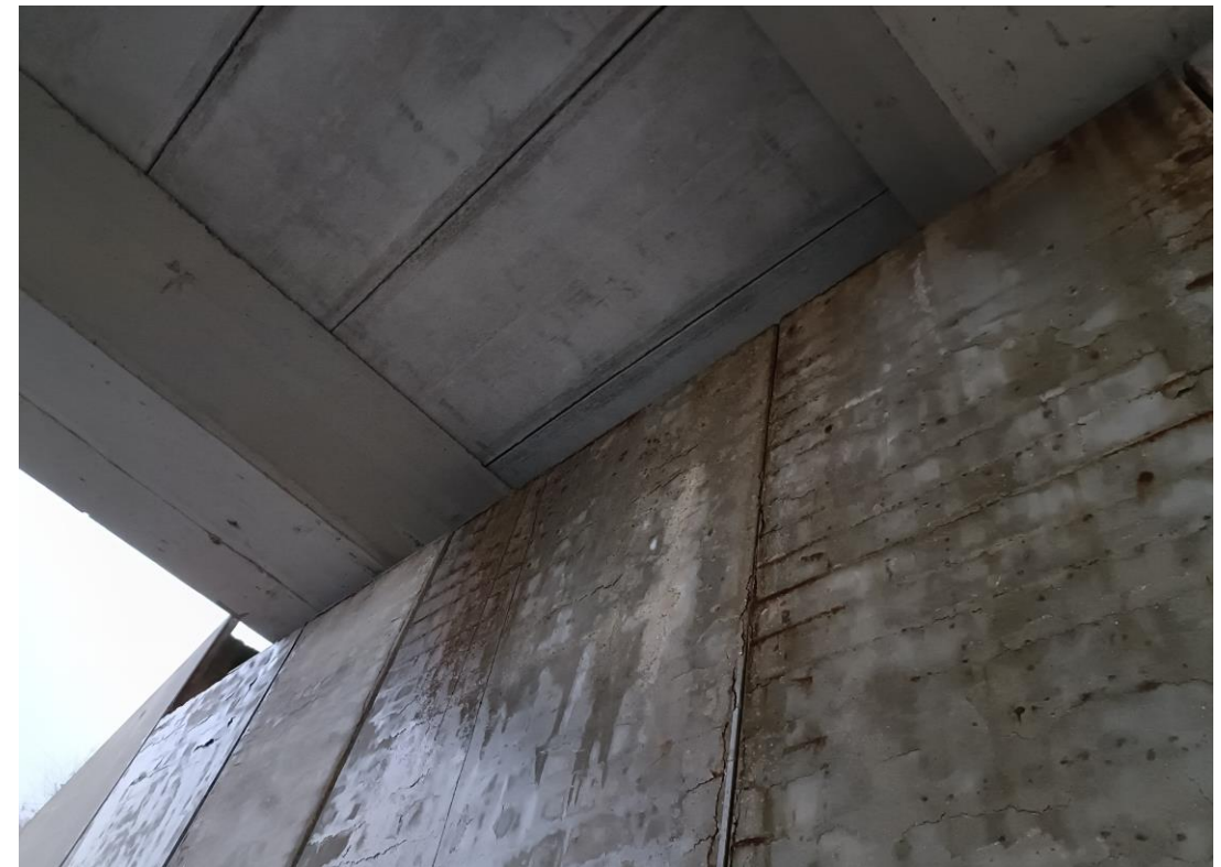
Foto Nº 32 . Estribo E1. Detalle de oxidación de barras y falta de recubrimiento en alzado de muros. Manchas de humedad y eflorescencias en alzado de muros. Agua discurriendo por alzado de estribo. Detalle de humedad en unión entre módulos de prelosas.
