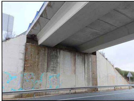
FOTO 5 HUMEDADES Y EFLORESCENCIAS EN MUROS DE ESTRIBO 1
