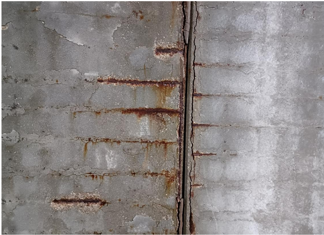
Foto Nº 27 . Estribo E1. Detalle de oxidación de barras y falta de recubrimiento en alzado de muros. Manchas de humedad y eflorescencias en alzado de muros.
