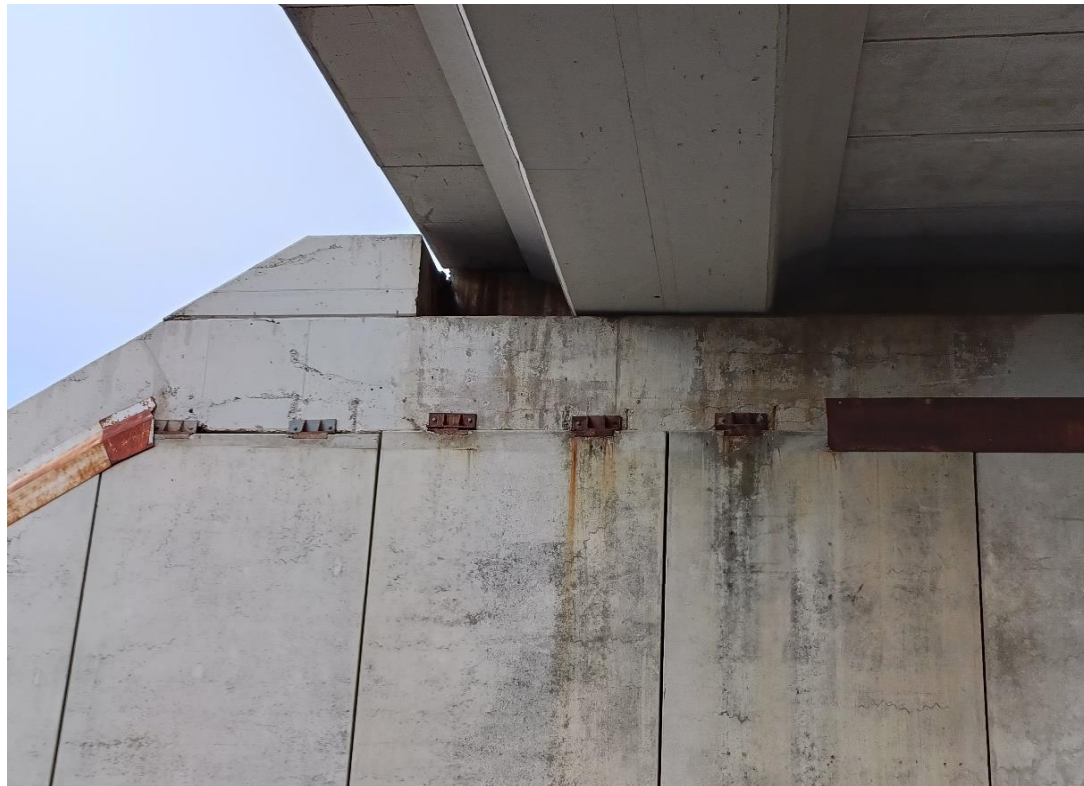
Foto Nº 9 . Vista estribo E2. Humedades y eflorescencias en cargadero y alzado de muros. Manchas de óxido por corrosión de chapa de unión en cabeza de alzado de muros. Rotura de chapa de conexión.
