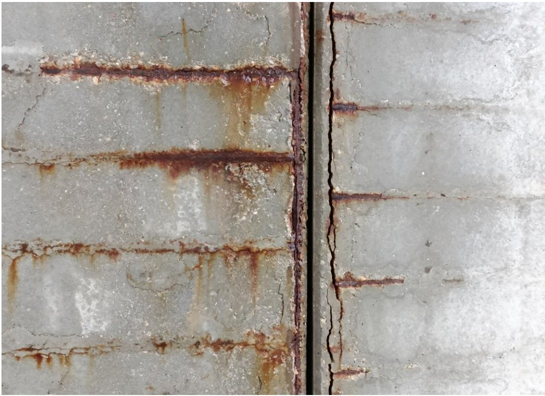
Foto Nº 26 . Estribo E1. Detalle de oxidación de barras y falta de recubrimiento en alzado de muros.
