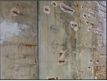
FOTO 5 DETALLE DE ARMADURAS OXIDADAS Y FALTA DE RECUBRIMIENTO DEL ESTRIBO 1
