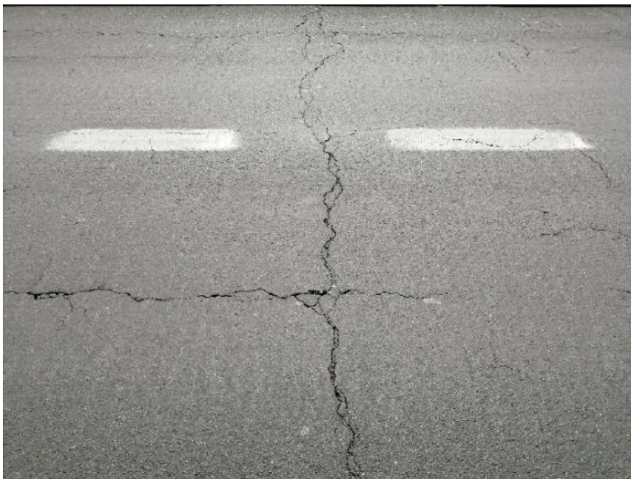
Figura 16. Continuidad en pavimento sobre los estribos, aunque se ha formado una grieta en el pavimento
