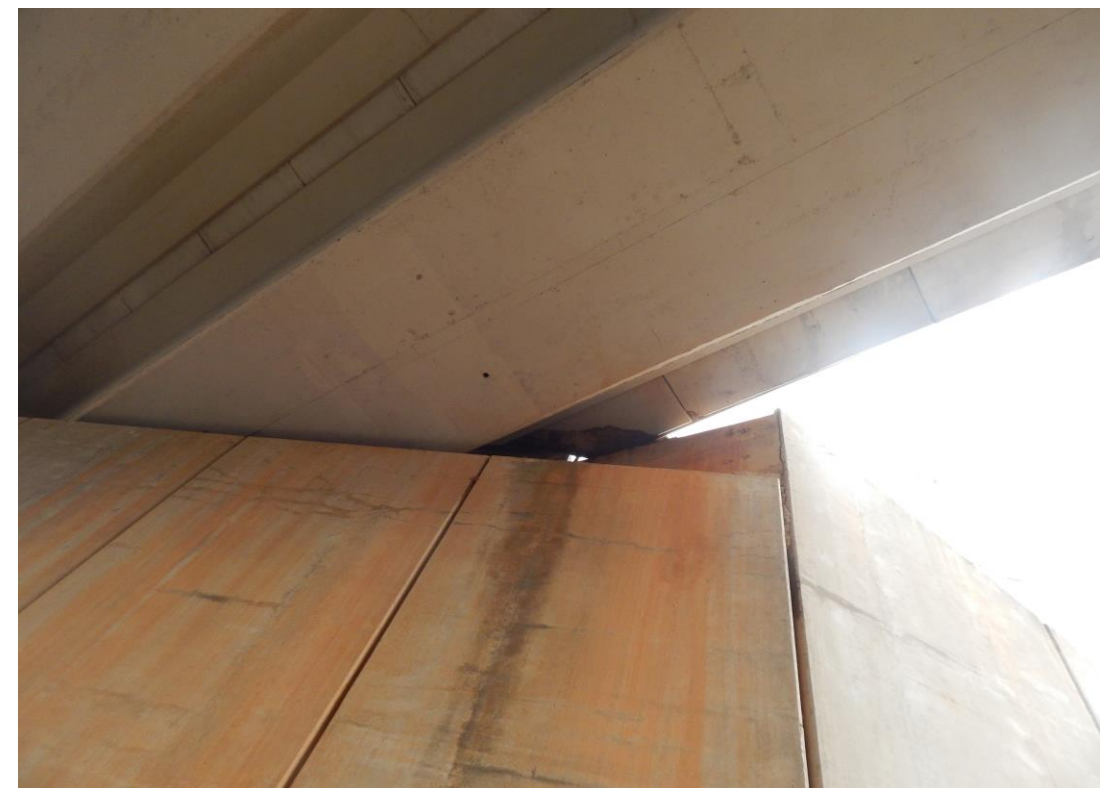
Foto Nº 44 . Humedades y eflorescencias en espaldón de Estribo 2. Manchas de humedad en el tablero.
