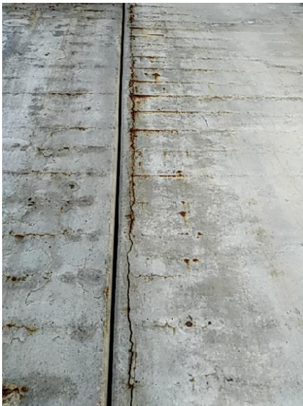
Fisuración vertical en estribo 2
