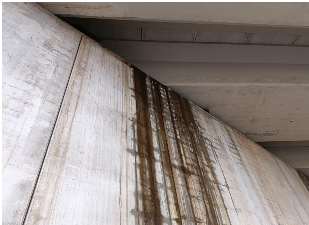
Foto Nº 38 . Falta de recubrimiento y armaduras vistas en el alzado de los muros del Estribo 1.
