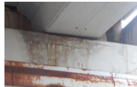
Figura 58 Fisura horizontal en el cargadero del Estribo 1, debajo de cada viga
