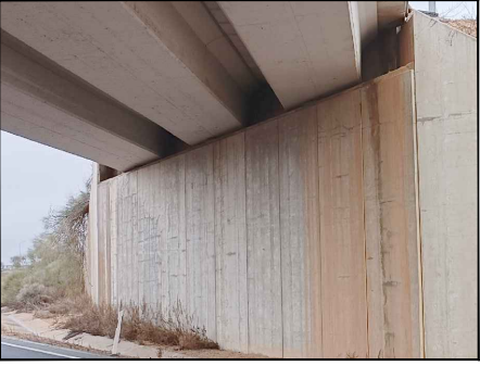
FOTO 8 HUMEDADES, EFLORESCENCIAS Y MANCHAS PUNTUALES DE ÓXIDO EN MURO DEL ESTRIBO 2
