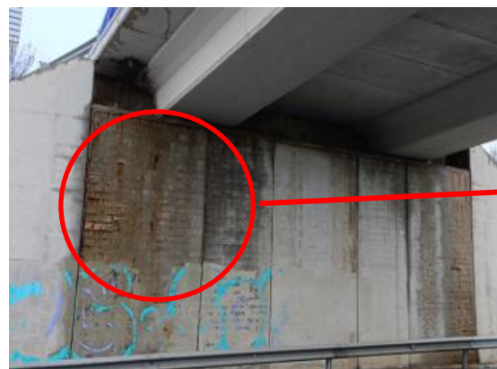
Figura 50 Humedades, escurridos y eflorescencias en Estribo 1
