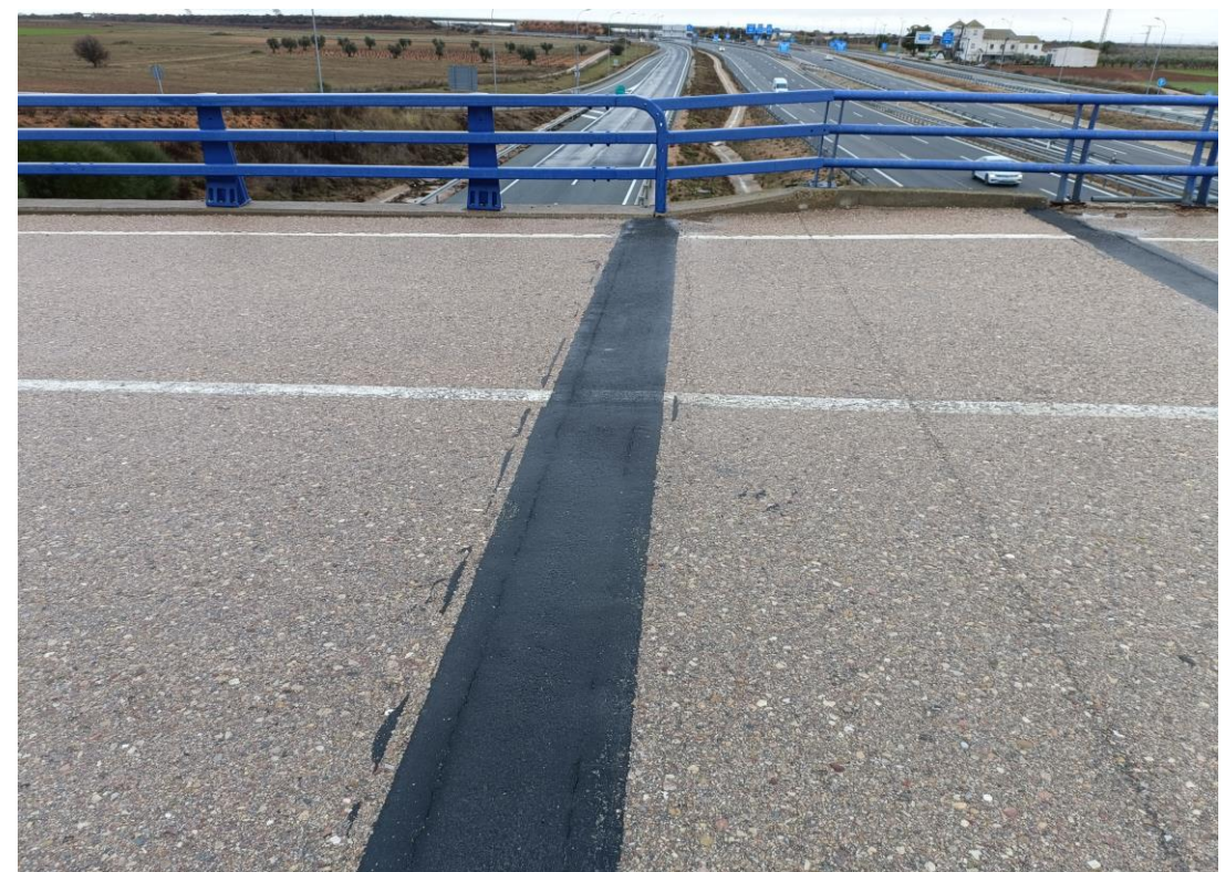
Foto Nº 4 . Vista de la plataforma del Paso Superior 0A-0004-0067+500 D. Estado de las juntas de dilatación que separan el Paso Superior Derecho y el Central. Vista del zócalo entra ambos pasos.
