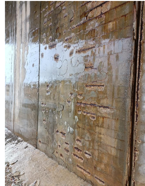
Foto Nº 23 . Falta de recubrimiento y armaduras vistas en el alzado de los muros del Estribo 1.
