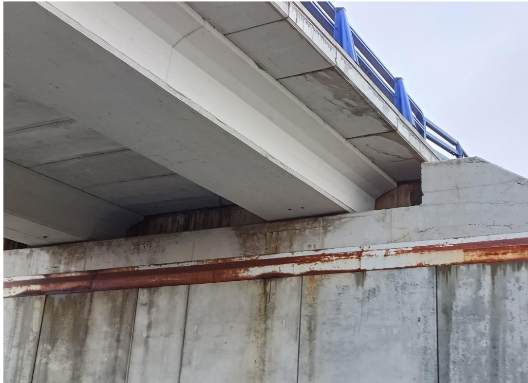
Foto Nº 17 . Fisura horizontal en cargadero debajo de la viga.
