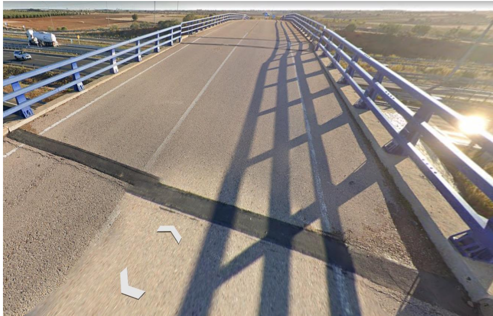
Figura 26 Características del pretil y de la junta de dilatación del Paso Superior 0A-0004-0067+500-D
