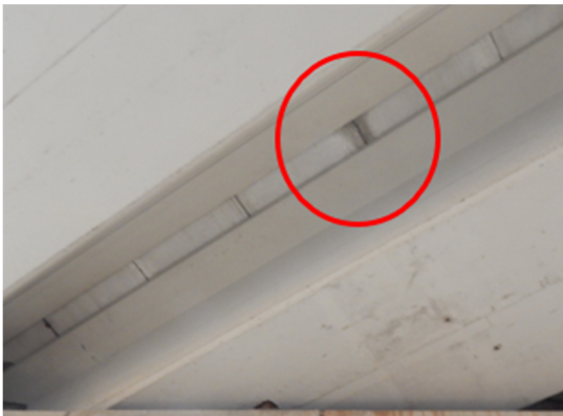
Figura 26 Manchas de humedad en la parte inferior de las prelosas
