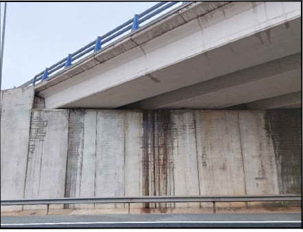
FOTO 2 MANCHAS DE HUMEDAD, ESCURRIDOS Y EFLORESCENCIAS EN ESTRIBO 1
