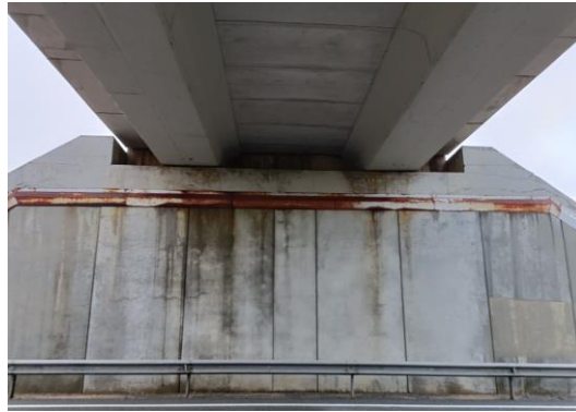
Figura 48 Humedades y eflorescencias en muros de Estribo 2
