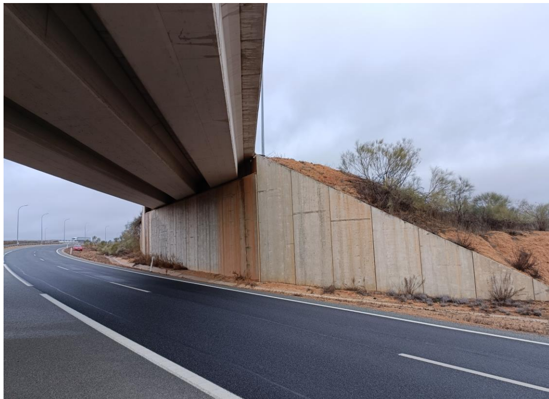
Foto Nº 50 . Alzado muros en Estribo 2.
