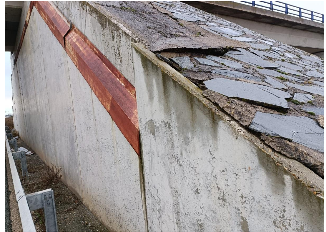
Foto Nº 19 . Estribo E2. Detalle de falta de alineación de muro extremo. Detalle de enchado sobre estribo.
