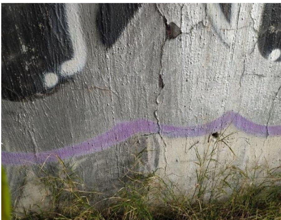
Figura 21. Fisuras en mapa en el muro frontal del estribo 1 de la calzada izquierda, extraída de la inspección realizada en 2020
