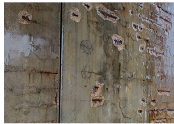
Figura 20 Detalle de armaduras oxidadas y falta de recubrimiento del Estribo 1
