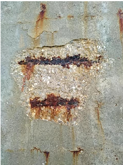
Armadura vista en estribo 2
