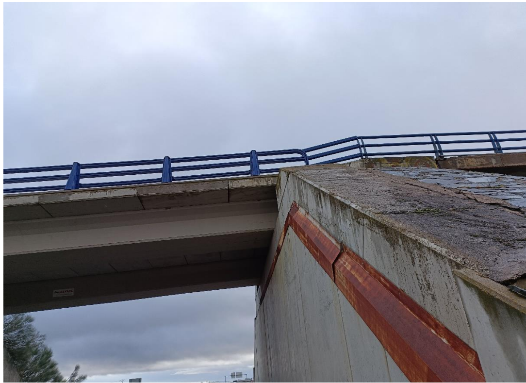
Foto Nº 21 . Estribo E2. Detalle de falta de alineación de muro extremo.
