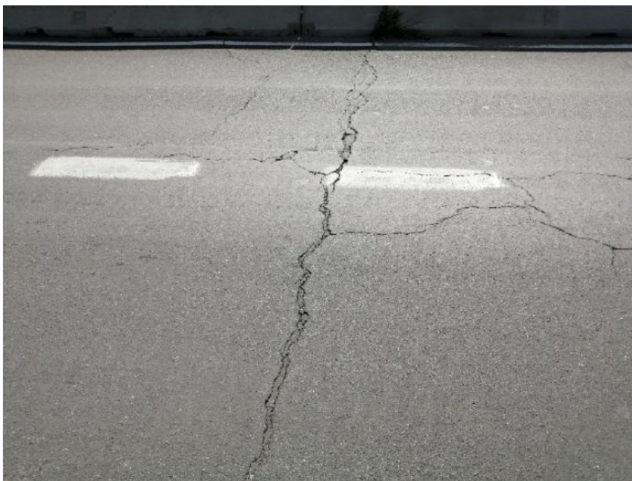
Figura 36. Grietas en pavimento sobre el estribo 1 de la calzada derecha. Inspección principal de 2020
