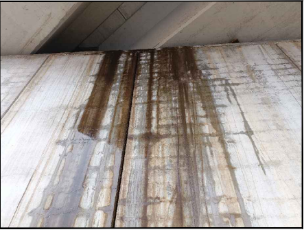
FOTO 3 DETALLE DE MANCHAS DE HUMEDAD, ESCURRIDOS Y EFLORESCENCIAS EN ESTRIBO 1
