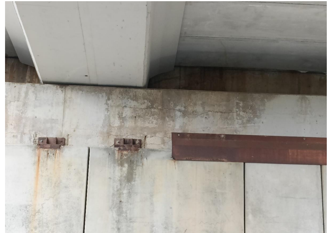
Foto Nº 11 . Estribo E2. Fisuras y eflorescencias en alzado de muros y cargadero.
