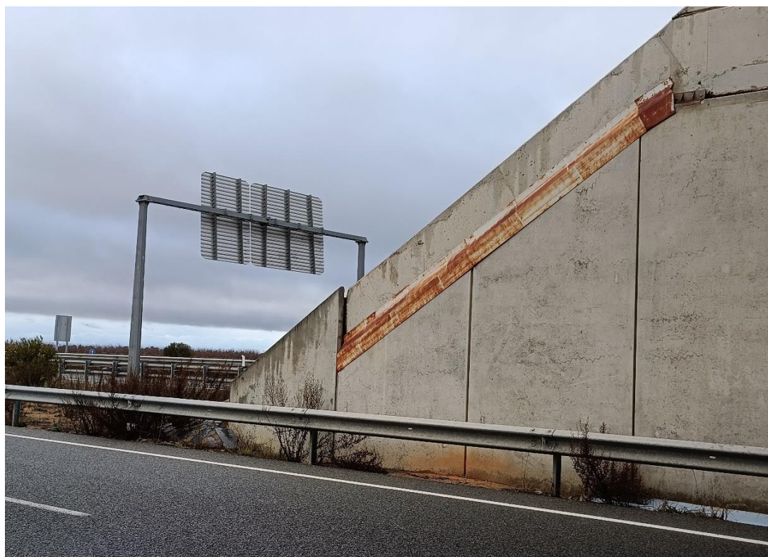
Foto Nº 14 . Estribo E2. Deformación en alzado de muro extremo.
