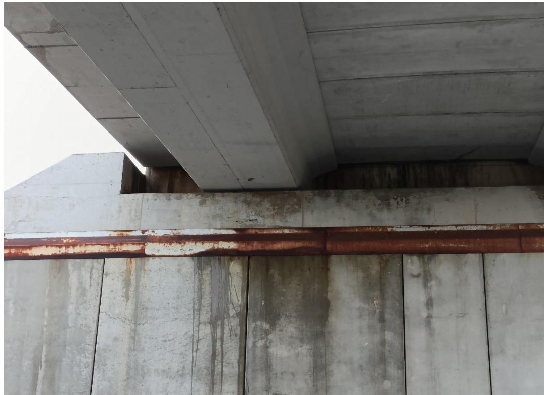
Foto Nº 13 . Estribo E1. Fisuras y eflorescencias en alzado de muros.
