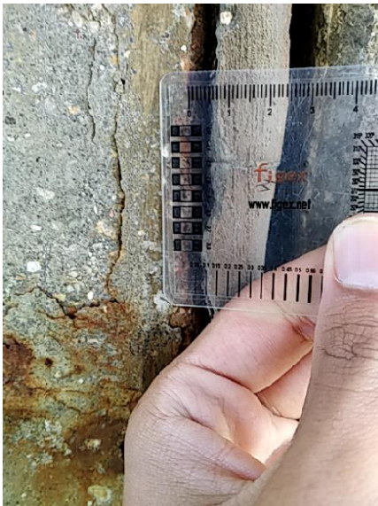
Fisuras verticales en estribo 2
