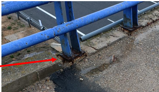
Figura 68 Detalle del estado del zócalo de anclaje
