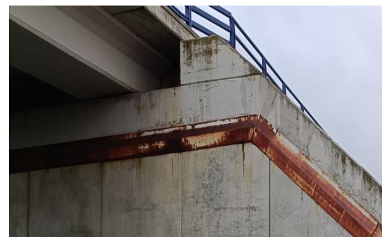
Figura 38 Manchas puntuales de óxido debido a las chapas metálicas del estribo 1 (central)
