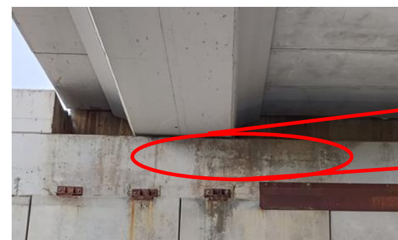
Figura 39 Fisura horizontal en el cargadero del estribo central, debajo de cada viga
