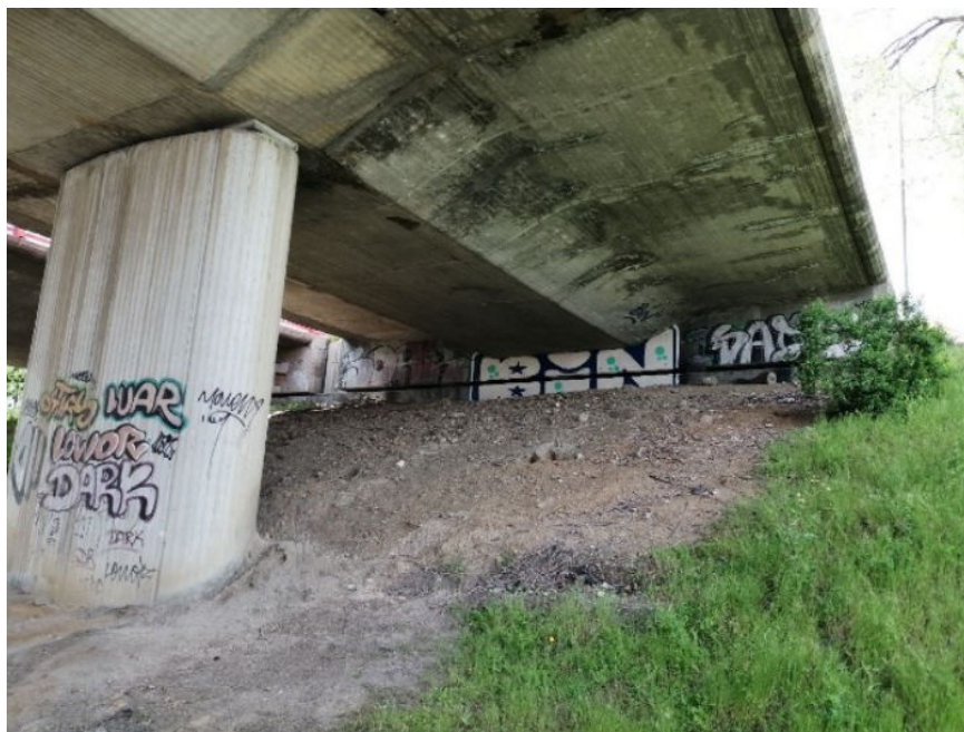
Figura 24. Manchas de humedades y eflorescencias en paramentos exteriores del tablero, extraído de la inspección principal de 2020
