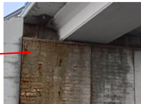
Figura 51 Detalle de Humedades y eflorescencias en muro de Estribo 1
