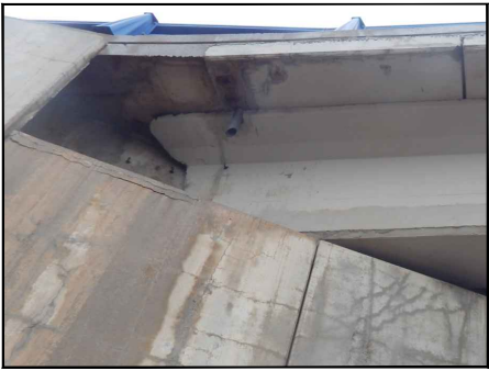
FOTO 10 ESCURRIDOS Y HUMEDADES EN PROXIMIDADES DE TUBOS DE DRENAJE DE ESTRIBO 2
