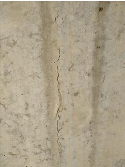
Fisuración vertical en estribo 1
