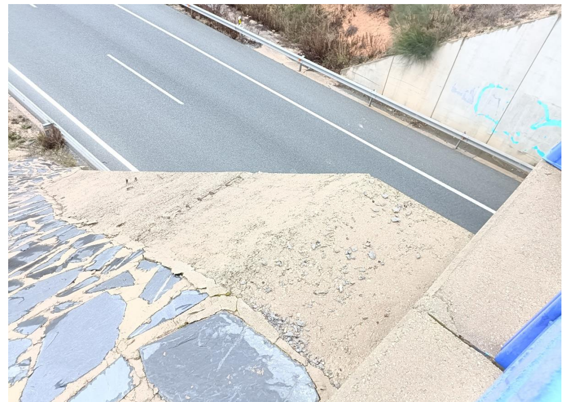
Foto Nº 4 . Vista de la autovía desde plataforma del paso superior central. Detalle hormigón y encachado estribo 1 central.
