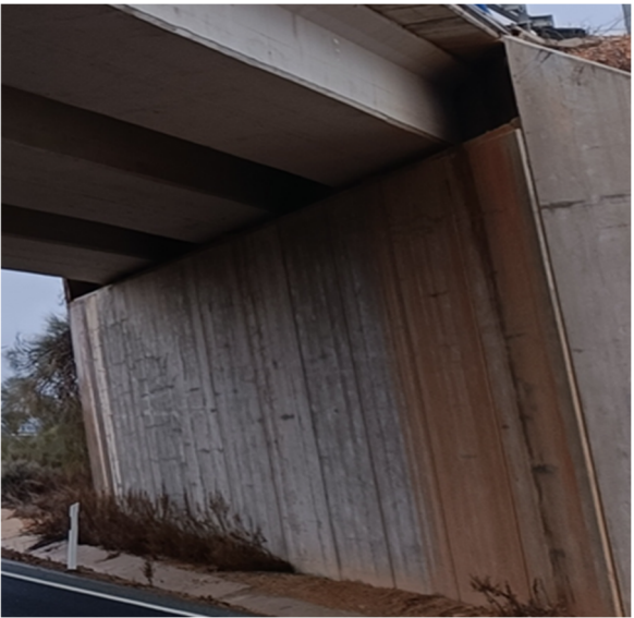
Figura 22 Manchas puntuales de óxido en el muro del Estribo 2
