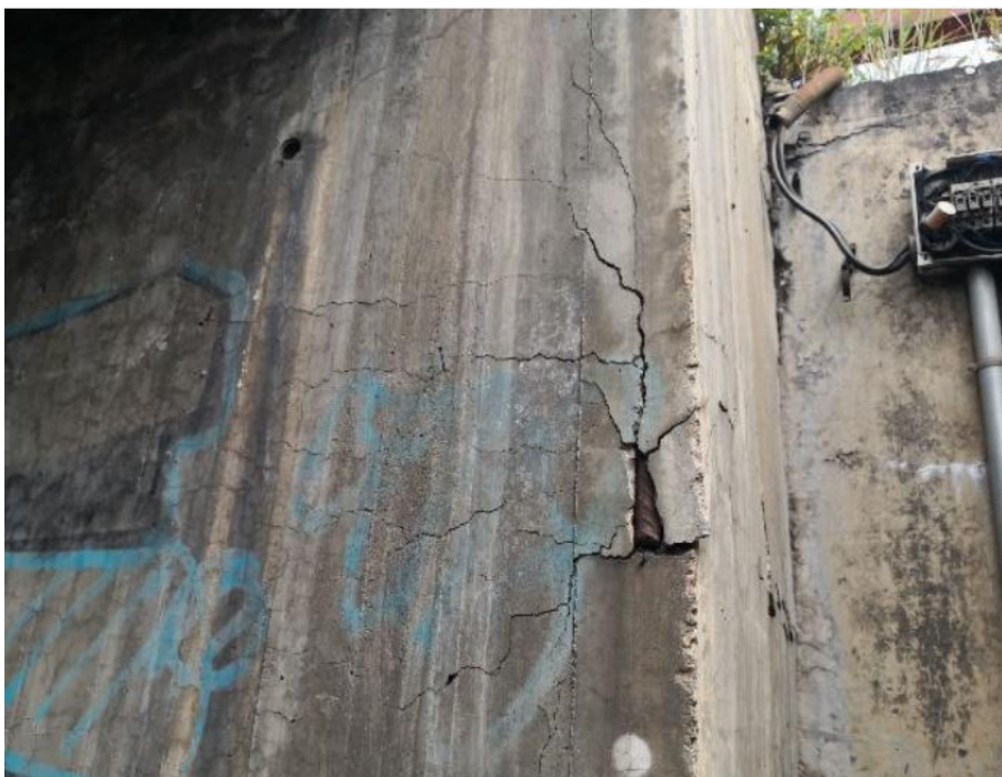
Figura 27. Desconchones con armadura vista la riostra transversal de la losa del tablero sobre estribo 1, extraído de la inspección principal de 2020
