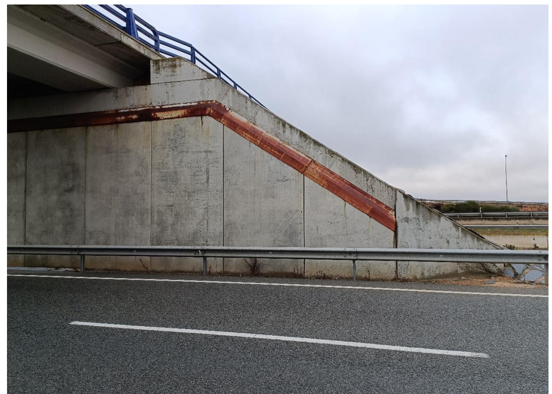
Foto Nº 16 . Estribo E2. Manchas de óxido por corrosión de chapa de unión en cabeza de alzado de muros. Deformación en alzado de muro extremo.
