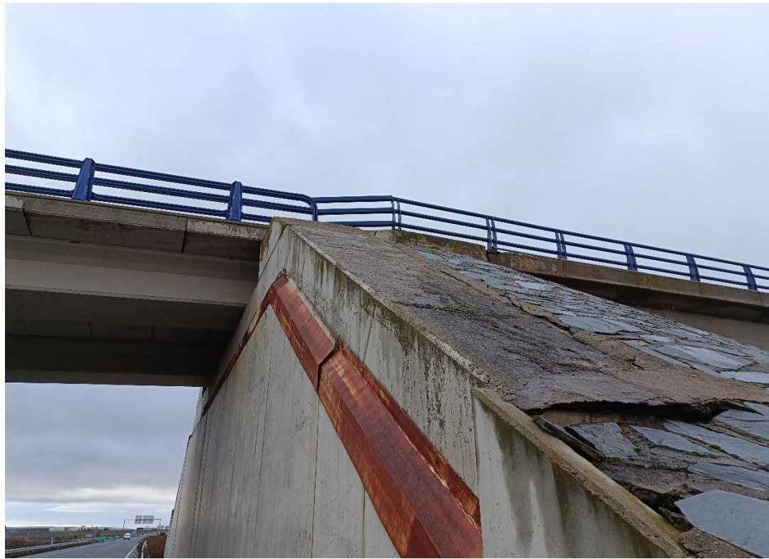
Foto Nº 17 . Estribo E2. Detalle de falta de alineación de muro extremo. Detalle de enchado sobre estribo.
