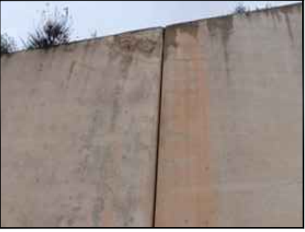
FOTO 9 MANCHAS PUNTUALES DE ÓXIDO EN LOS MUROS DE ACOMPAÑAMIENTO DEL ESTRIBO 2
