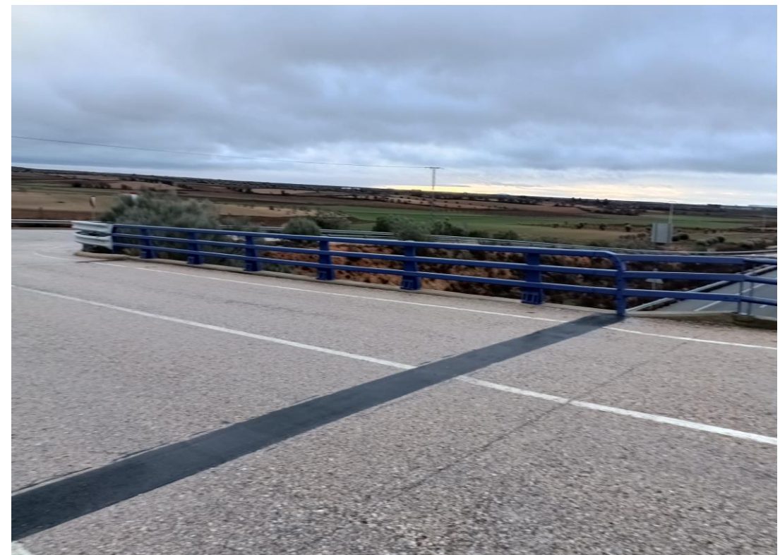
Foto Nº 8 . Vista de la plataforma del Paso Superior 0A-0004-0067+500 I. Estado de la junta de dilatación sobre el estribo E2.
