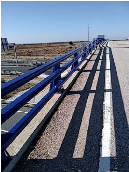
Pretil metálico en lado PK+
