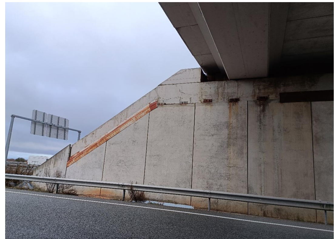
Foto Nº 12 . Estribo E2. Manchas de óxido por corrosión de chapa de unión en cabeza de alzado de muros. Deformación en alzado de muro extremo.
