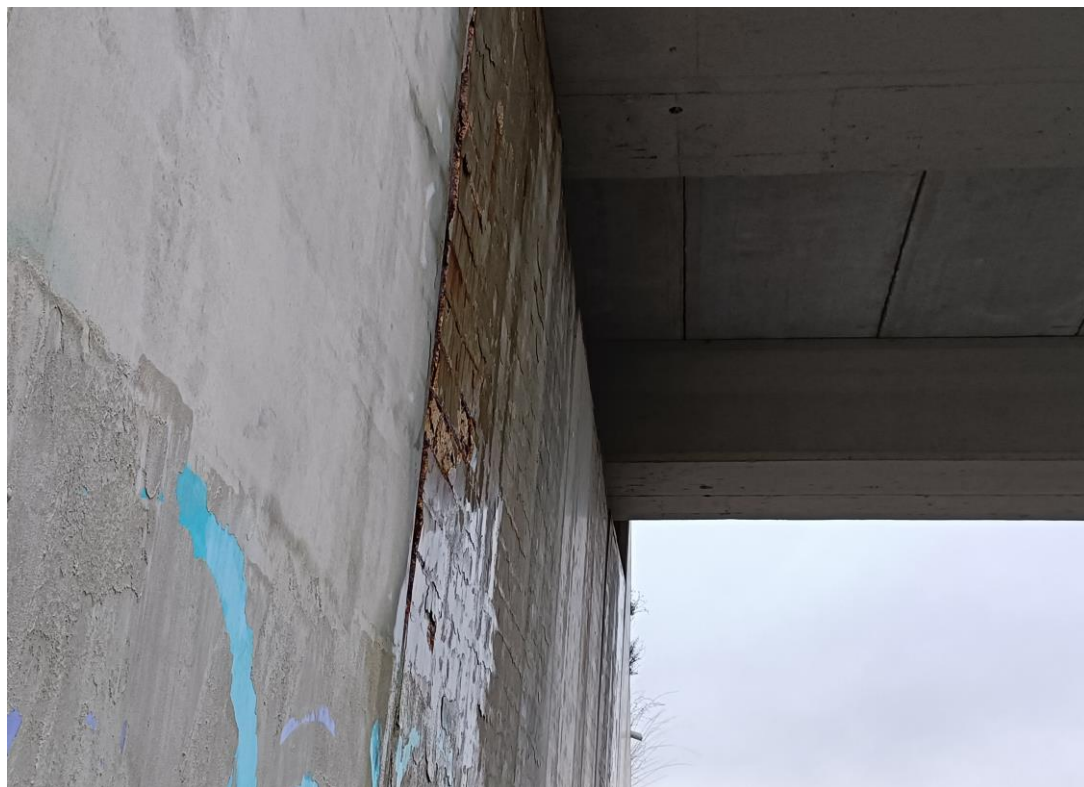
Foto Nº 22 . Estribo E2. Fisuras, eflorescencias, falta de recubrimiento y oxidación en alzado de muros.
