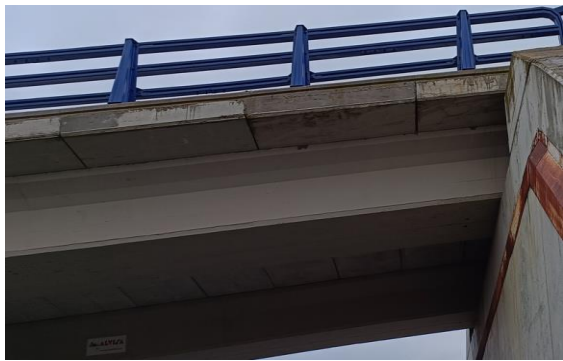
Figura 44 Manchas de humedad en los extremos de las prelasas
