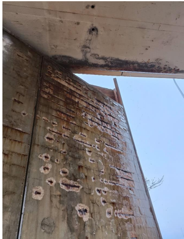
Foto Nº 25 . Falta de recubrimiento y armaduras vistas en el alzado de los muros del Estribo 1.
