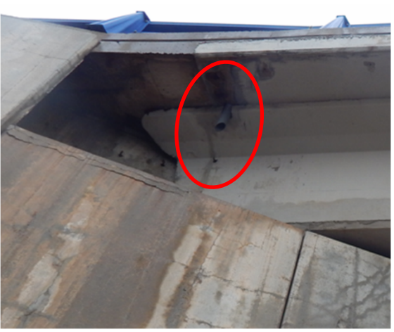
Figura 29 Tubos de drenaje con escasa longitud próximo al Estribo 2
