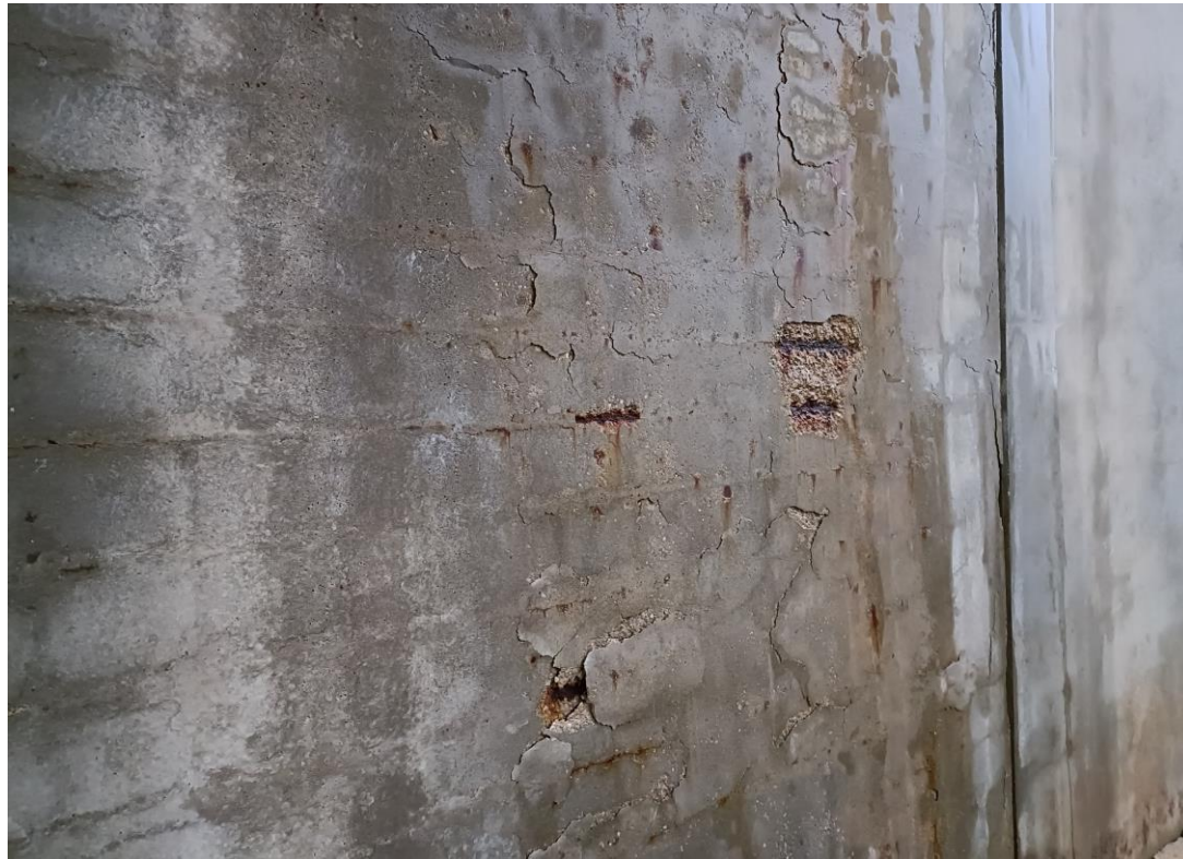
Foto Nº 29 . Estribo E1. Detalle de oxidación de barras y falta de recubrimiento en alzado de muros. Manchas de humedad y eflorescencias en alzado de muros.
