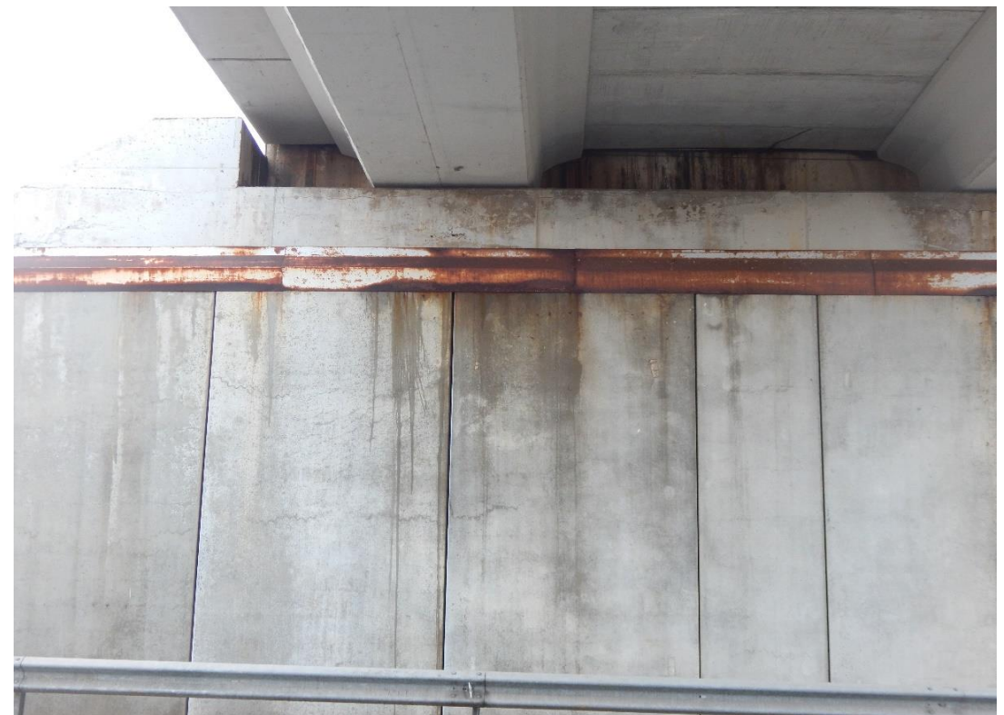
Foto Nº 8 . Estribo E1. Fisuras y eflorescencias en alzado de muros.
