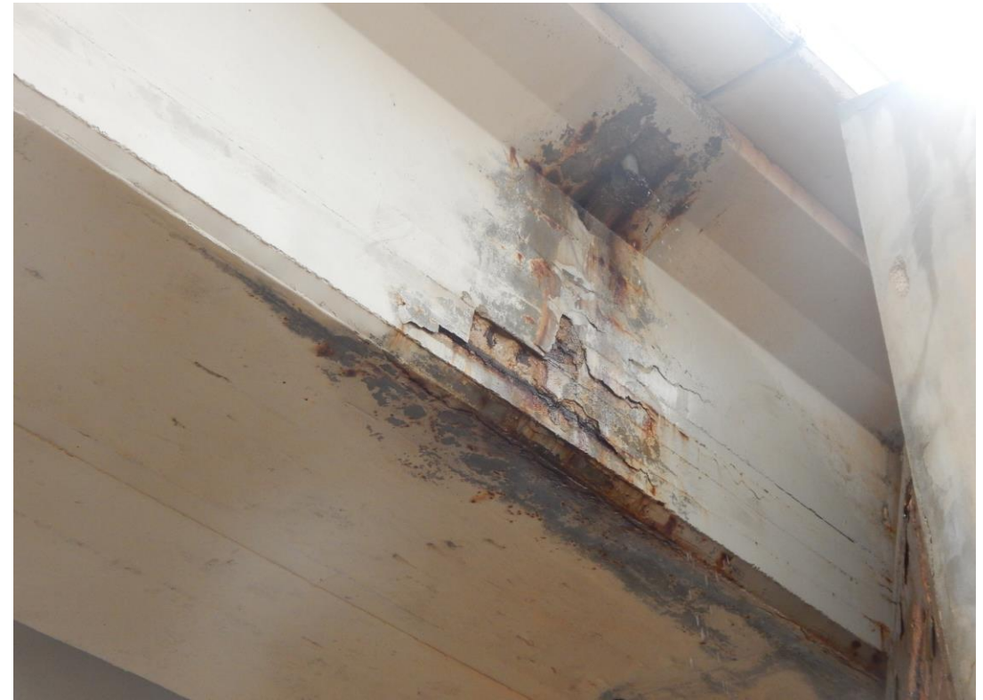
Foto Nº 59 . Viga artesa extrema con falta de recubrimiento y armaduras vistas. Agua saliendo por el tubo de drenaje.
