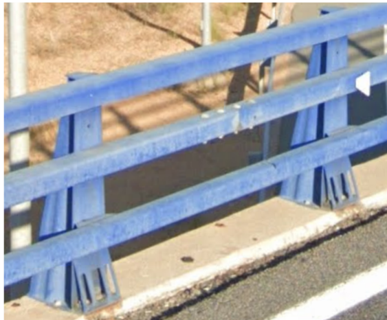
Figura 31 Manchas de oxidación en las placas y tornillos de anclaje
