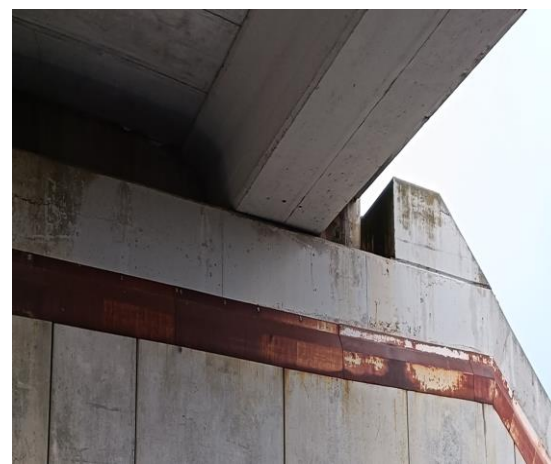
Figura 33 Detalle de manchas de humedad y eflorescencias, oxidación de chapa metálica
