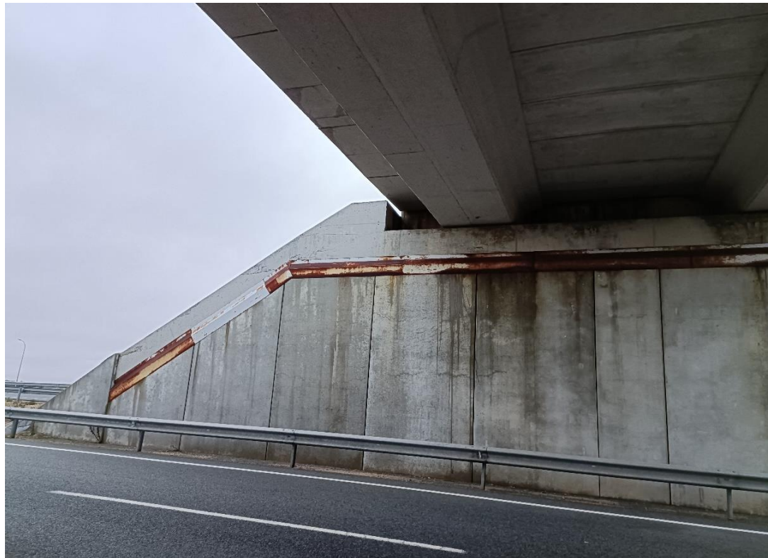
Foto N° 9 . Estribo E1. Fisuras y eflorescencias en alzado de muros.
