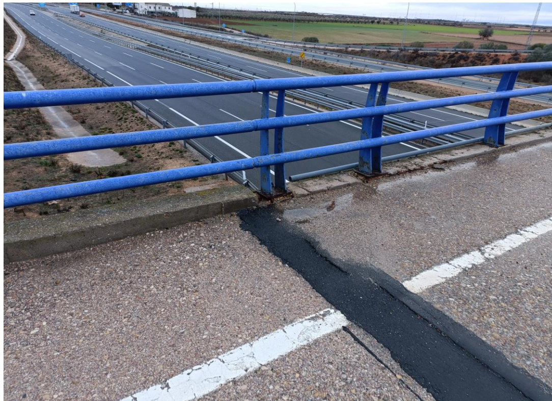
Foto Nº 5 . Transición de zócalos entre el Paso Superior Derecho y el Central. Detalle del sistema de contención.
