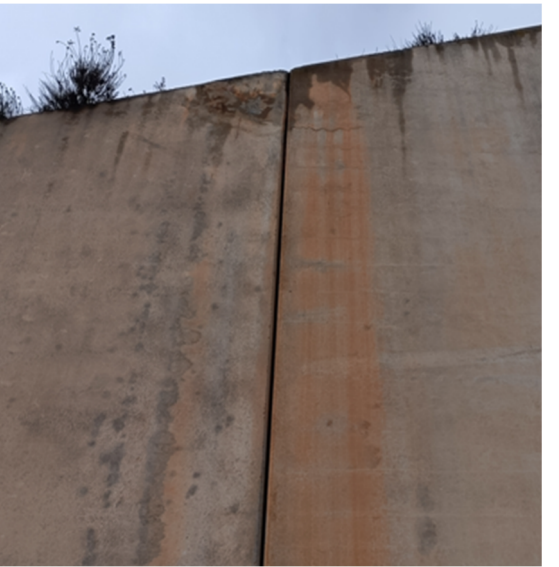
Figura 23 Manchas puntuales de óxido en los muros de acompañamiento del Estribo 2
