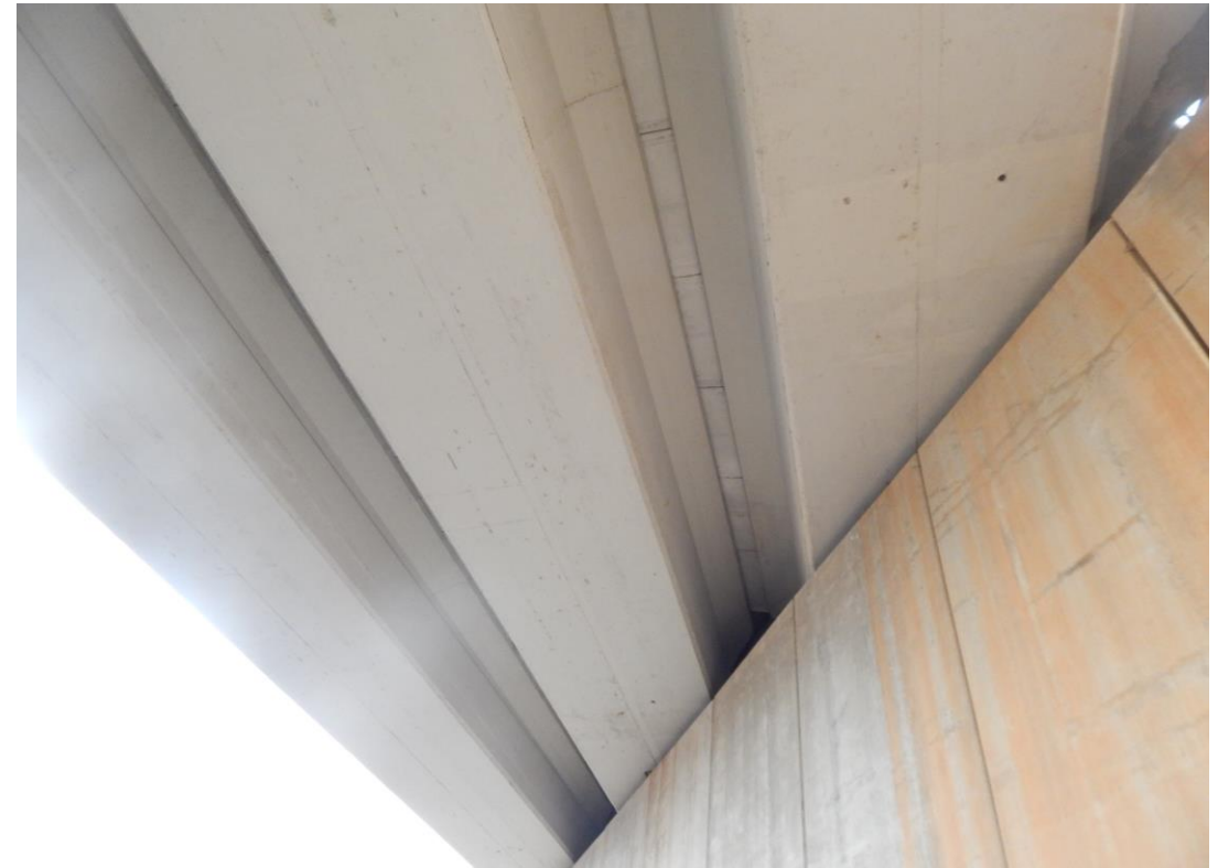
Foto Nº 47 . Humedades y eflorescencias en espaldón de Estribo 2. Manchas de humedad en el tablero.
