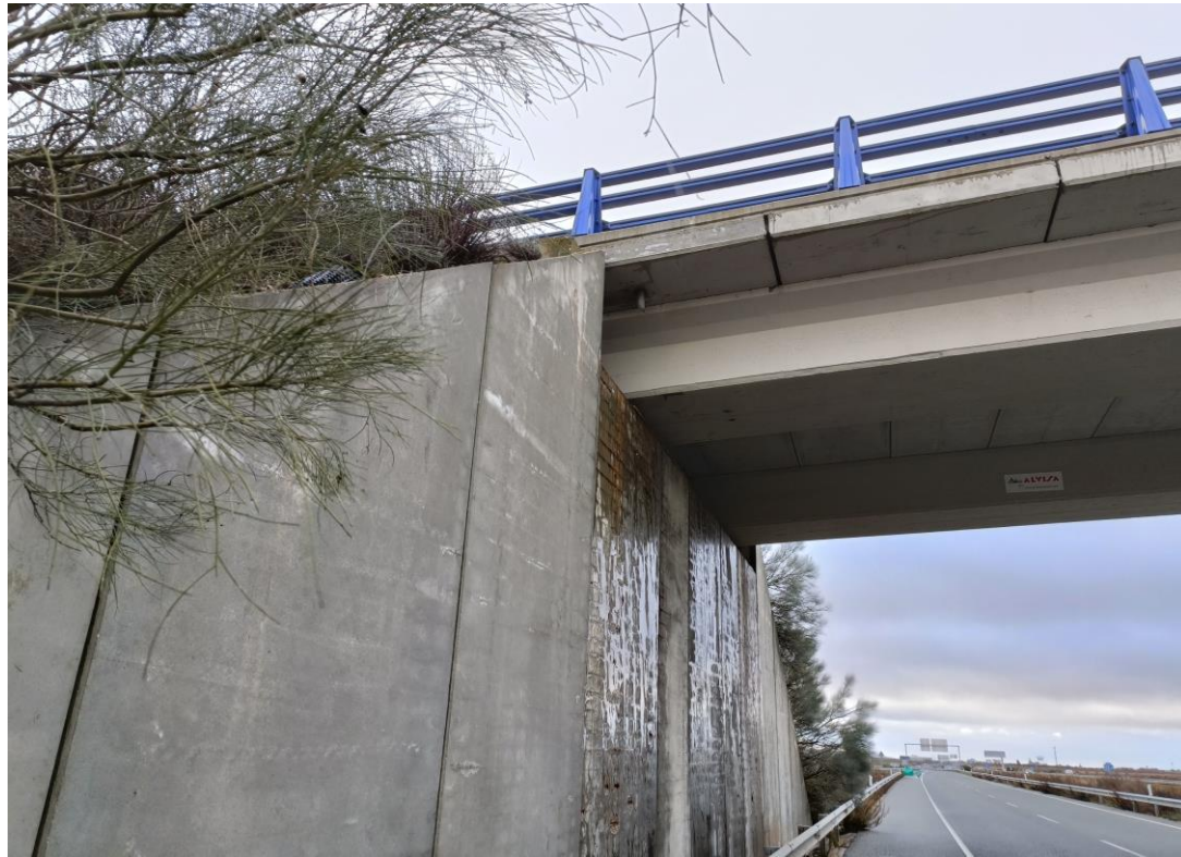
Foto Nº 33 . Estribo E1. Agua discurriendo por alzado de estribo en zona de desagüe de los tubos de drenaje.
