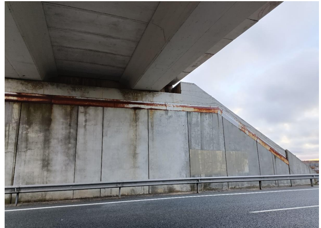
Foto N° 11 . Estribo E1. Fisuras y eflorescencias en alzado de muros.
