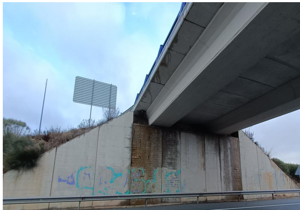
Figura 20 Apoyo lateral del Paso Superior 0A-0004-0067+500-D
