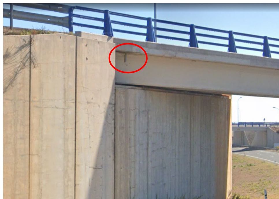
Figura 12 Tubo de drenaje próximo a Estribo 2 del Paso Inferior
