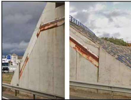
FOTO 4 BASCULAMIENTO DE LOS MUROS LATERALES EXTREMOS DEL ESTRIBO 2
