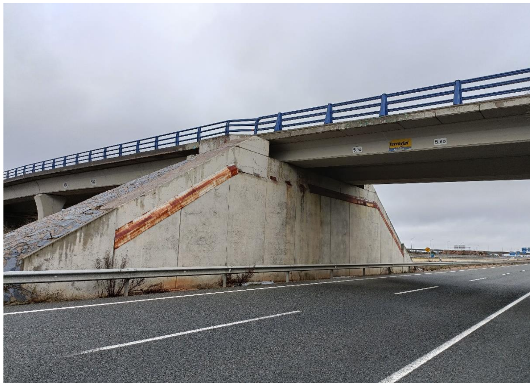
Foto Nº 6 . Alzado Paso Superior. Vista estribo E2. Humedades y eflorescencias en cargadero y alzado de muros.
