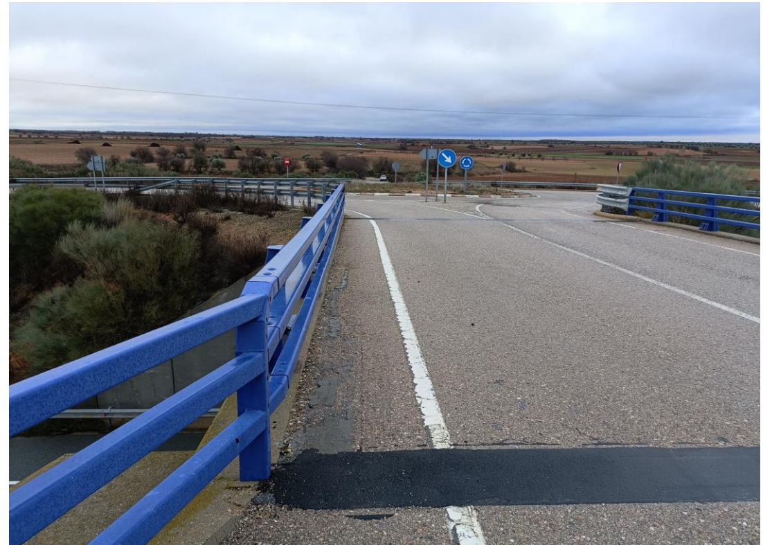
Foto N° 15 . Estado de la junta de dilatación del Paso Superior Izquierdo.
