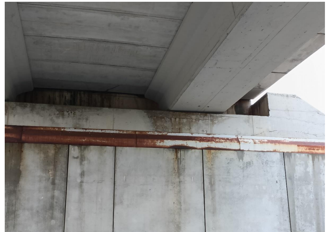
Foto N° 12 . Fisura horizontal en cargadero debajo de la viga.
