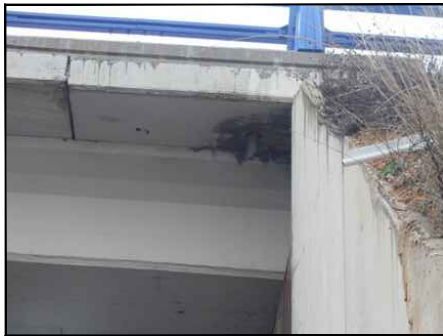
FOTO 12 MANCHAS DE HUMEDAD EN LOS ALREDEDORES DE LA GÁRGOLA DE DRENAJE
