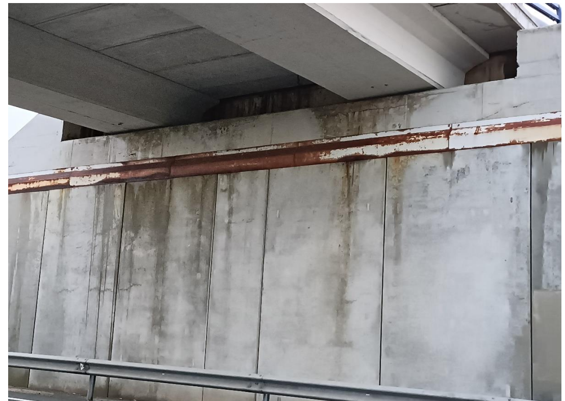
Foto Nº 16 . Estribo E1. Fisuras y eflorescencias en alzado de muros y cargadero.
