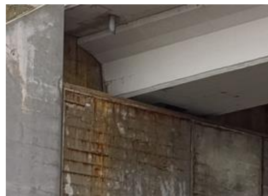
Figura 34 Armaduras oxidadas en el cargadero y muros del estribo 2
