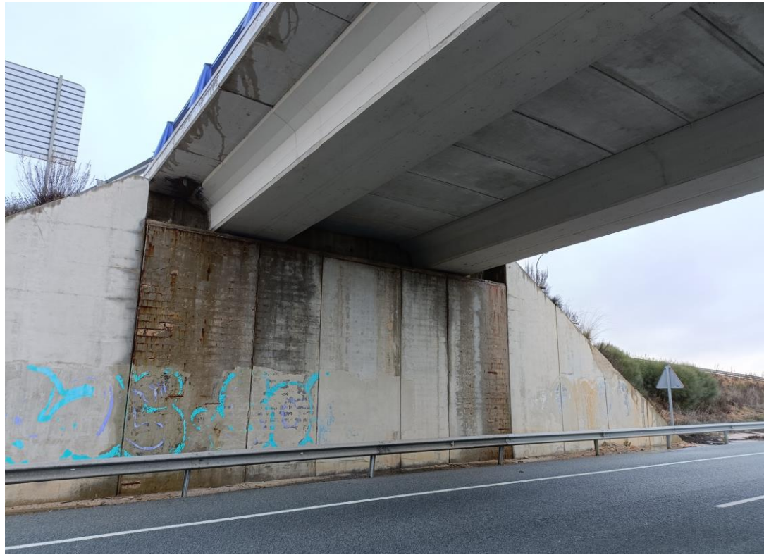
Foto Nº 29 . Estribo E2. Armaduras sin recubrimiento y oxidadas en alzados de muros. Grafitis en alzado de muros.
