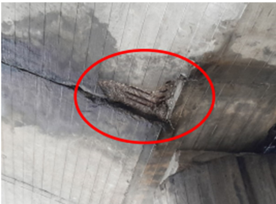
Figura 26. Desconchones con armadura vista en la losa del tablero, extraído de la inspección principal de 2025
