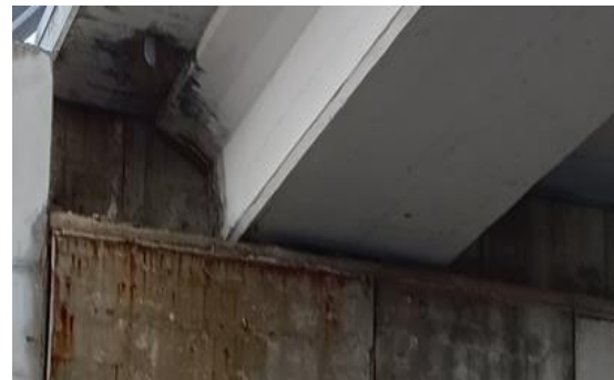
Figura 57 Armaduras oxidadas en los alzados de los muros del Estribo 1
