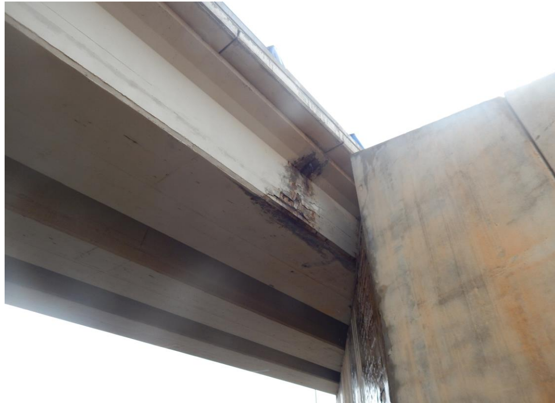
Foto Nº 57 . Viga artesa extrema con falta de recubrimiento y armaduras vistas.
