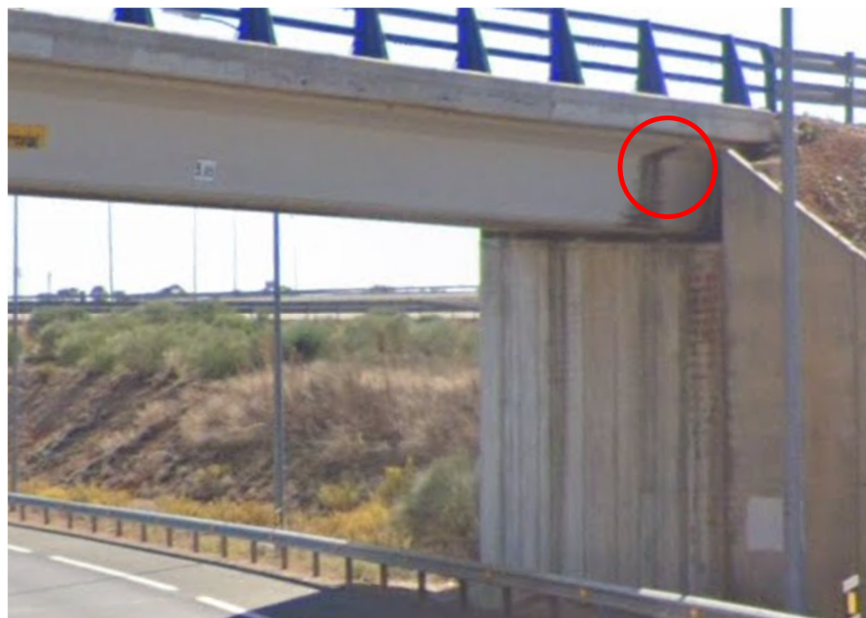
Figura 11 Tubo de drenaje próximo a Estribo 1 del Paso Inferior
