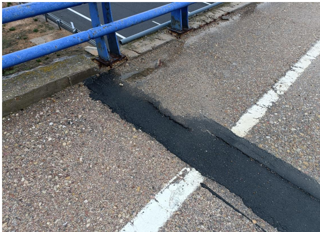
Foto Nº 6 . Transición de zócalos entre el Paso Superior Derecho y el Central. Detalle del sistema de contención.
