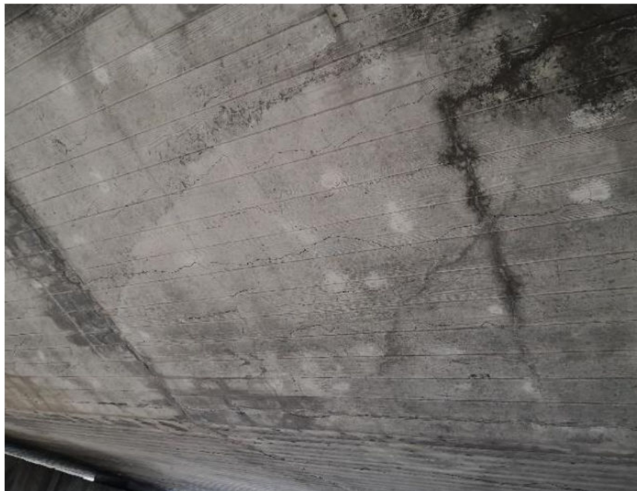
Figura 34. Fisuras oblicuas en la losa del tablero de la calzada derecha, extraído de la inspección principal de 2020
