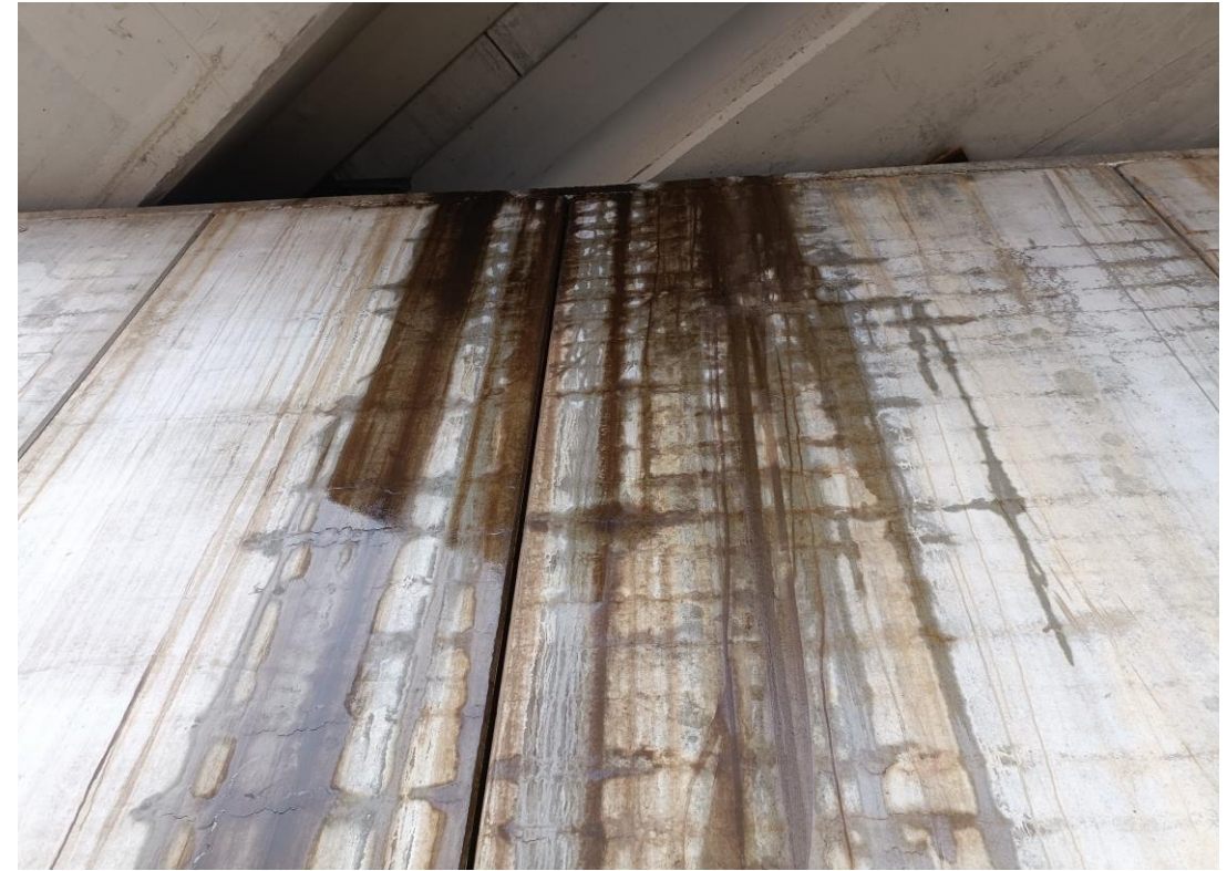
Foto Nº 35 . Falta de recubrimiento y armaduras vistas en el alzado de los muros del Estribo 1.
