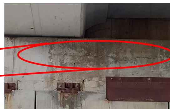
Figura 39 Fisura horizontal en el cargadero del estribo central, debajo de cada viga
