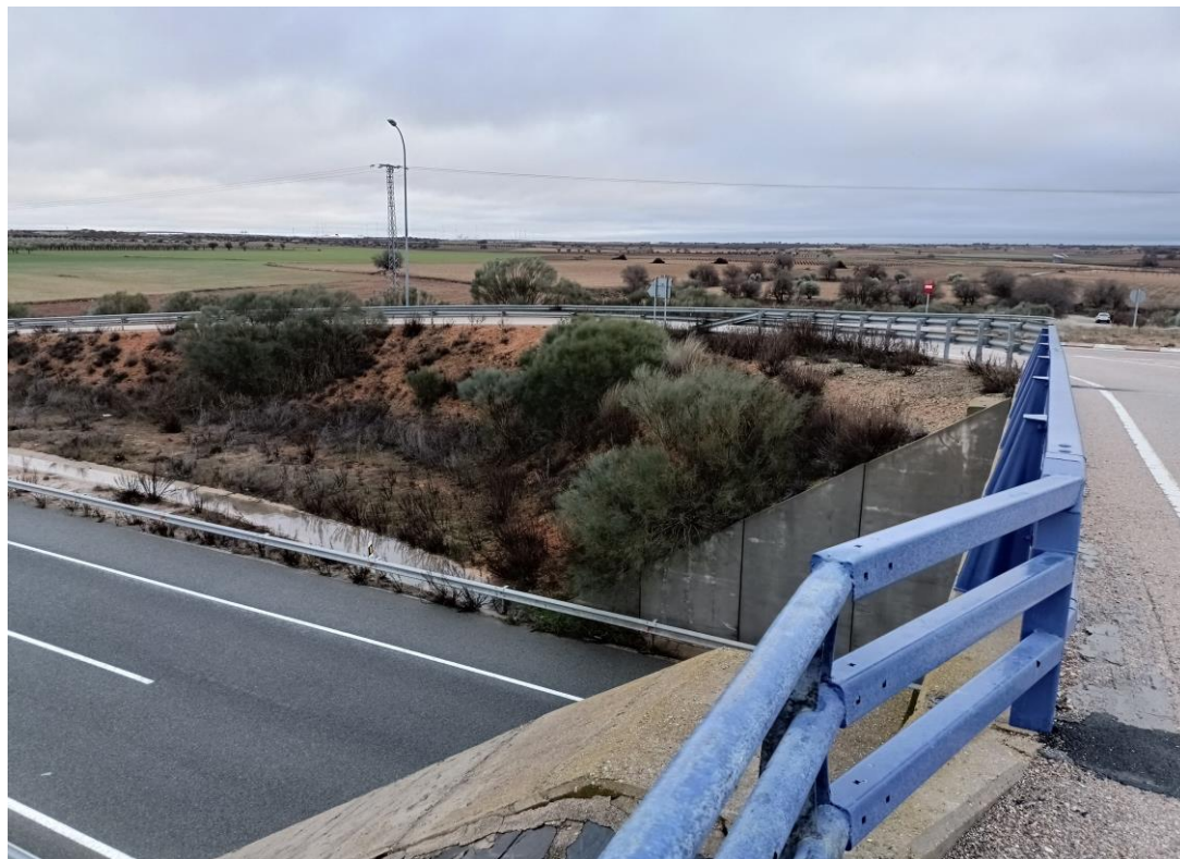
Foto Nº 10 . Vista de la plataforma del Paso Superior 0A-0004-0067+500 I. Estado de la junta de dilatación sobre el estribo E2. Transición entre los sistemas de contención del Paso Superior Central y el Izquierdo.
