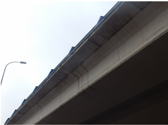
Figura 27 Manchas de humedad en los extremos de las prelosas
