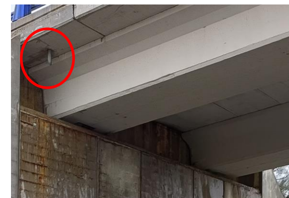
Figura 30 Tubos de drenaje con escasa longitud
