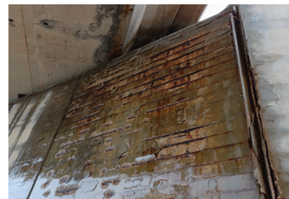
Figura 19 Armaduras oxidadas en muro del Estribo 1
