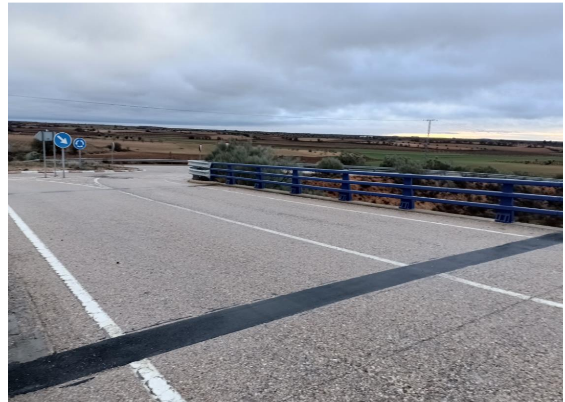
Foto Nº 7 . Vista de la plataforma del Paso Superior 0A-0004-0067+500 I. Estado de la junta de dilatación sobre el estribo E2.
