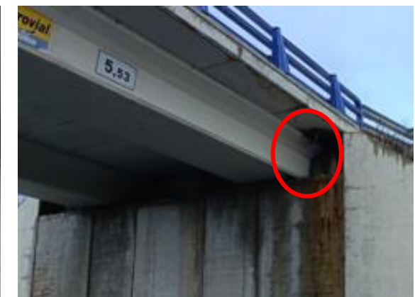
Figura 54 Tubos de drenaje de escasa longitud
