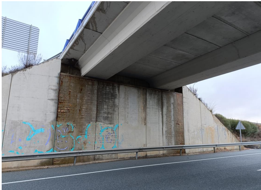
Foto Nº 30 . Estribo E2. Armaduras sin recubrimiento y oxidadas en alzados de muros. Grafitis en alzado de muros. Humedades en parte inferior de prelosas del tablero.
