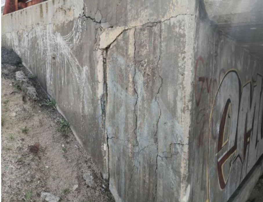
Figura 33. Fisuras en mapa en la borde lateral de la riostra transversal de la losa del tablero de la calzada derecha, extraído de la inspección principal de 2020
