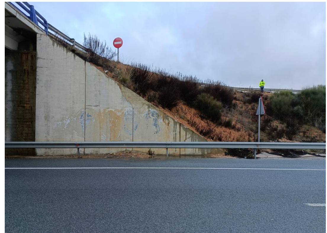
Foto Nº 40 . Estribo E2. Alzado de muros en prolongación conteniendo el terraplén. Grafitis en alzado de muros.
