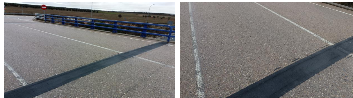
Figura 61 Estado de conservación de la junta de dilatación del Paso Superior 0A-0004-0067+500 D
