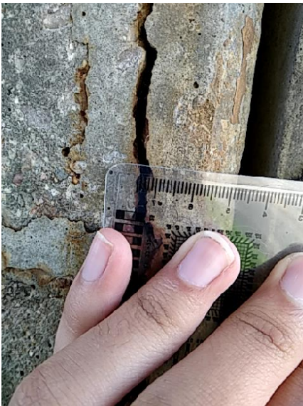
Fisuras verticales en estribo 2
