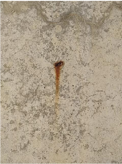
Corrosión armadura en estribo 1
