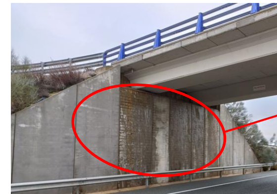
Figura 28 Manchas de humedad, escurridos y eflorescencias en muro de frente, estribo 2
