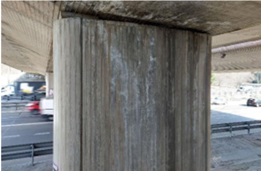
Figura 22. Manchas de humedades y eflorescencias en paramento frontal de pila 1, extraído de la inspección principal de 2024
