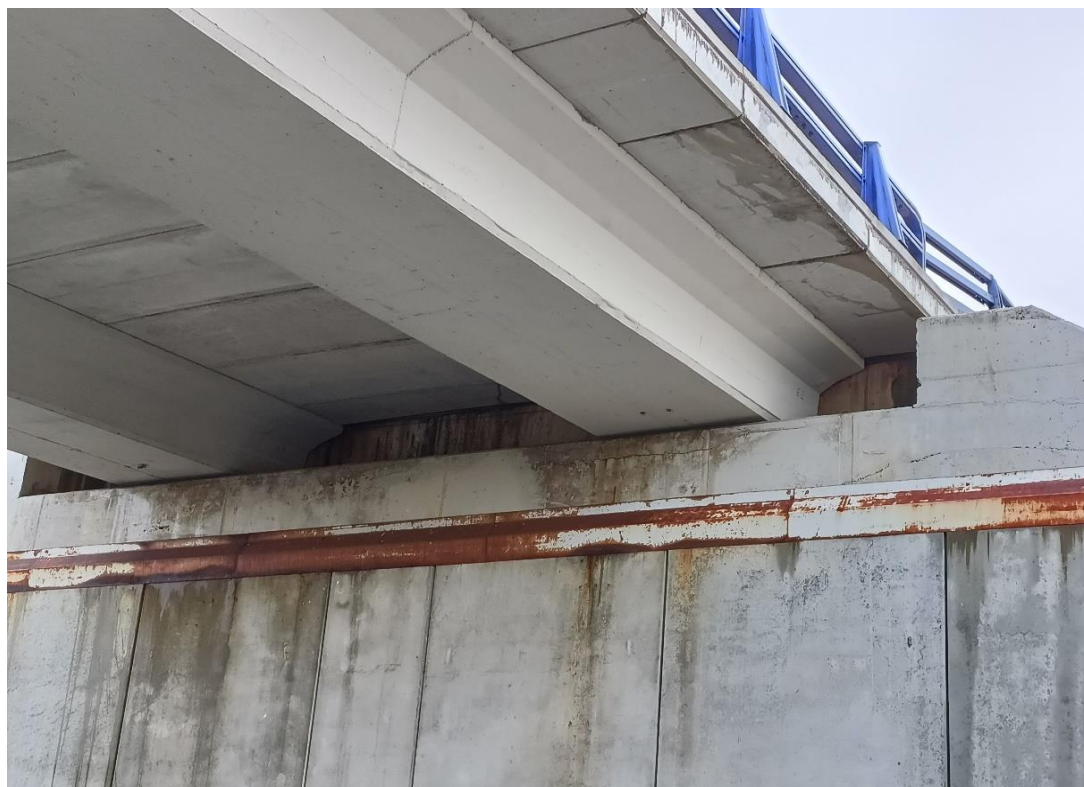
Foto Nº 18 . Fisura horizontal en cargadero debajo de la viga.
