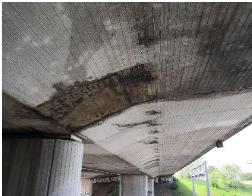
Figura 25. Manchas de humedades y eflorescencias en paramentos exteriores del tablero, especialmente en las zonas de las medias maderas, extraído de la inspección principal de 2020
