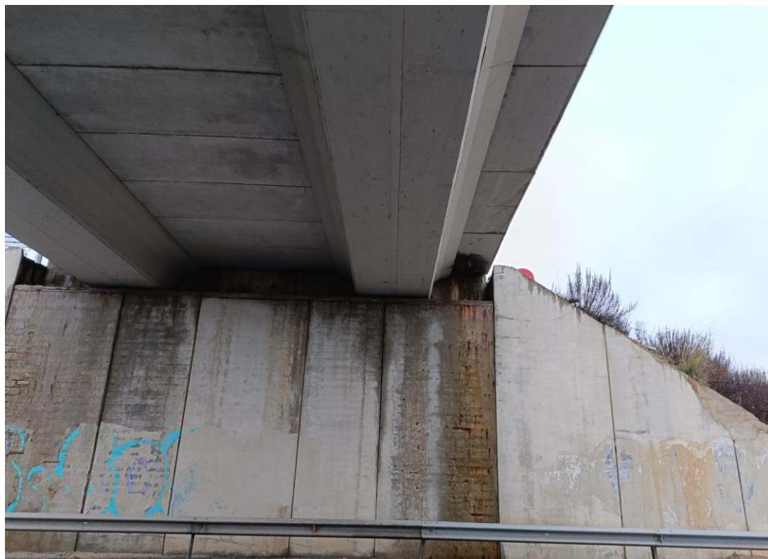
Foto Nº 34 . Estribo E2. Fisuras y eflorescencias en alzado de muros. Grafitis en alzado de muros.
