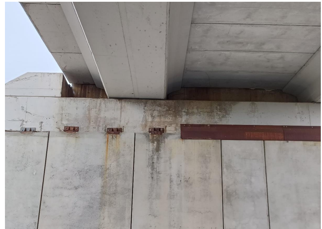
Foto Nº 8 . Vista estribo E2. Humedades y eflorescencias en cargadero y alzado de muros. Manchas de óxido por corrosión de chapa de unión en cabeza de alzado de muros.
