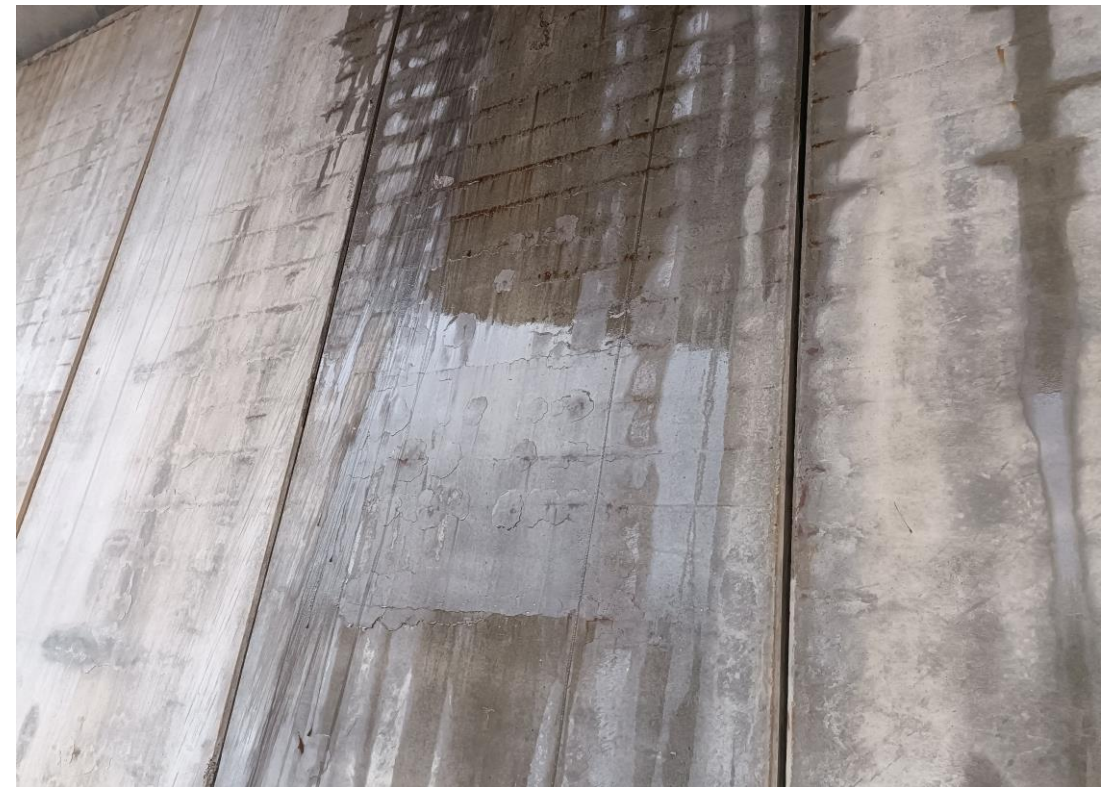
Foto Nº 32 . Falta de recubrimiento y armaduras vistas en el alzado de los muros del Estribo 1.
