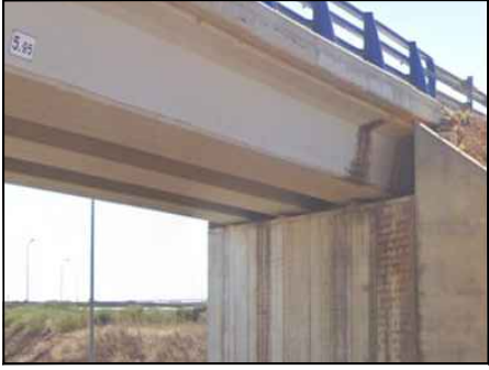
FOTO 7 ESCURRIDOS Y HUMEDADES EN PROXIMIDADES DE TUBOS DE DRENAJE DE ESTRIBO 1
