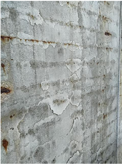
Deterioro superficial en estribo 2
