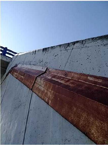
Desagregación en estribo 1
