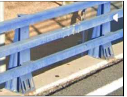
FOTO 15 MANCHAS DE OXIDACIÓN EN LAS PLACAS Y TORNILLOS DE ANCLAJE
