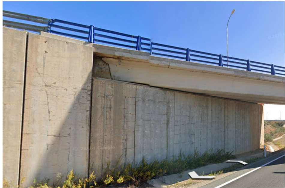
Figura 8 Estribo derecho del Paso Inferior
