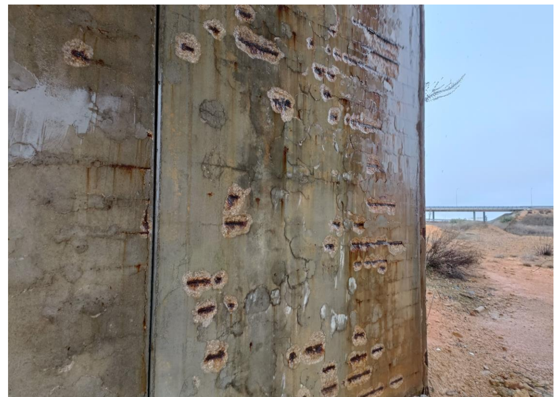
Foto Nº 28 . Falta de recubrimiento y armaduras vistas en el alzado de los muros del Estribo 1.
