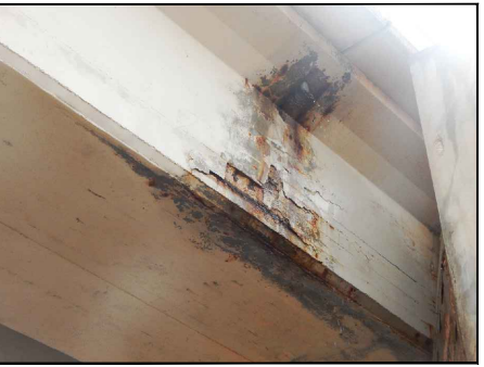
FOTO 11 PÉRDIDA DE RECUBRIMIENTO EN ARMADURA DE VIGA ARTESA 1 PRÓXIMA A ESTRIBO 1
