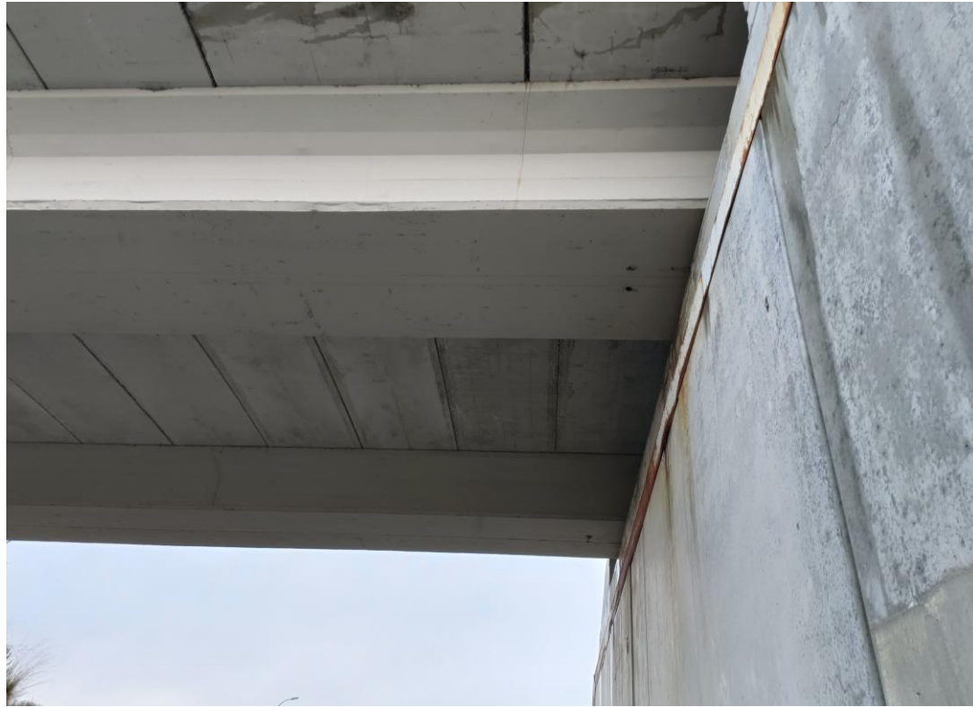
Foto Nº 33 . Vista inferior del Paso Superior. Humedades en parte inferior de prelasas del tablero.
