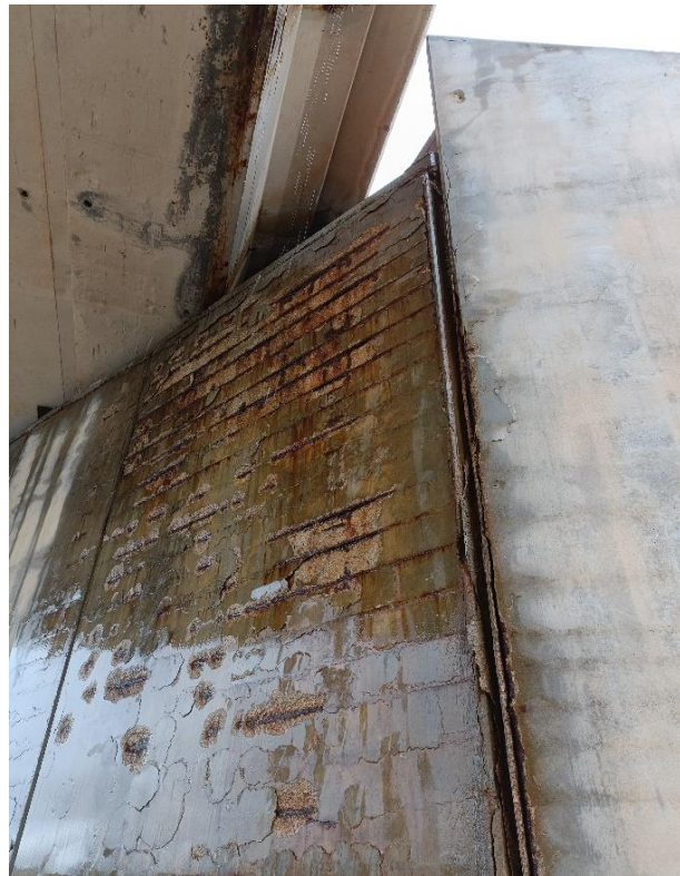
Foto Nº 21 . Falta de recubrimiento y armaduras vistas en el alzado de los muros del Estribo 1.
