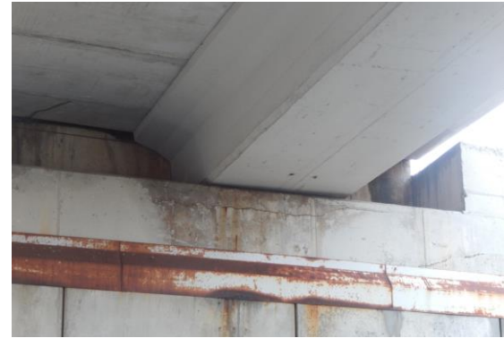
Figura 49 Humedades y eflorescencias en espaldón de Estribo 2
