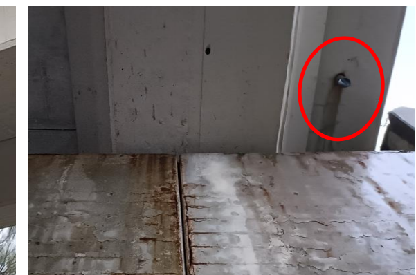
Figura 31 Escurrido y humedades en proximidades de tubos de drenaje
