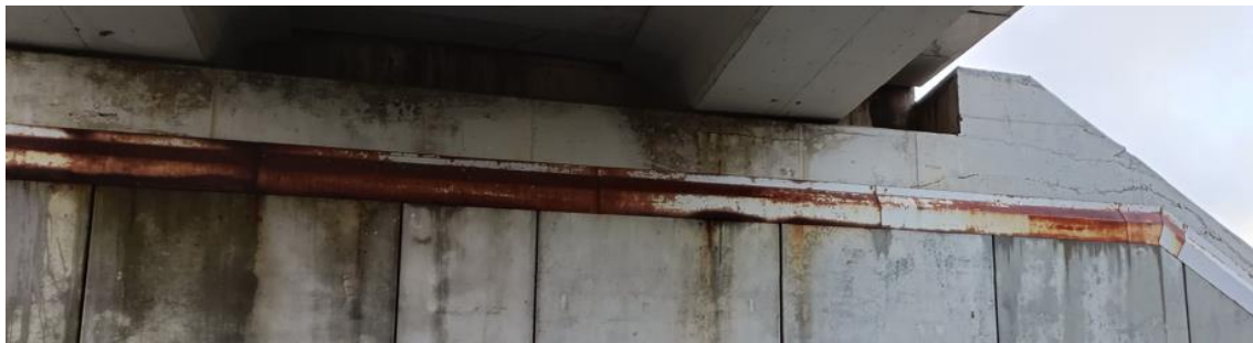
Figura 55 Manchas puntuales de óxido en las proximidades de las chapas metálicas de Estribo 2
